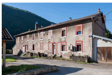
Logement ouvrier (8 appartements). Vue depuis le sud. Phot. Jérôme Mongreville
