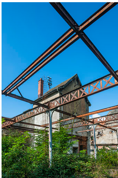
Charpente métallique de l'atelier de fabrication. Phot. Jérôme Mongreville IVR43_20142501253NUC4A
