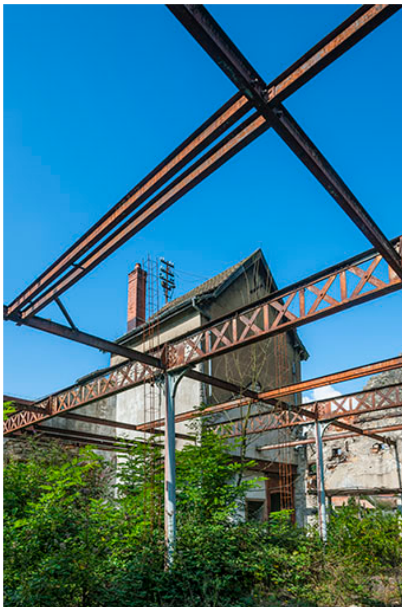
Charpente métallique de l'atelier de fabrication.
