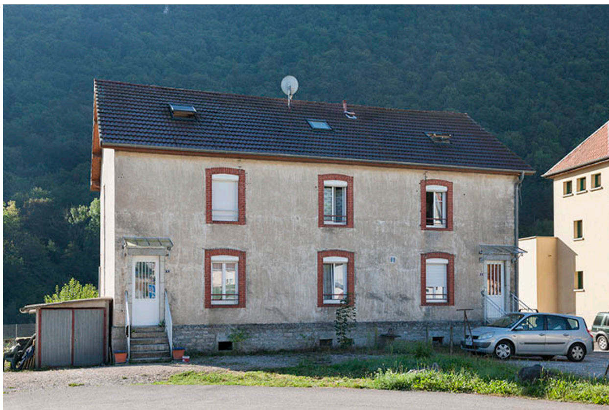
Logement ouvrier (sud) à 4 appartements. Façade ouest.
