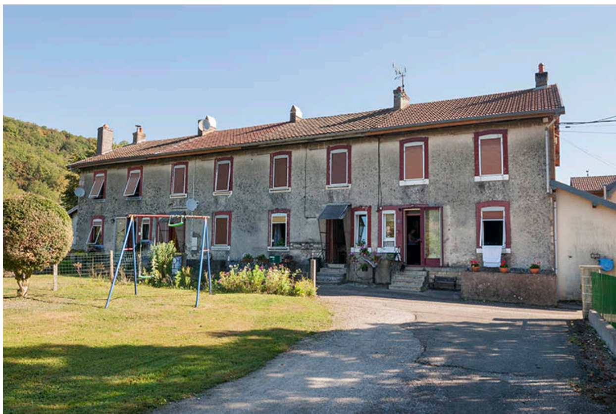
Logement ouvrier (8 appartements). Vue depuis le nord.
