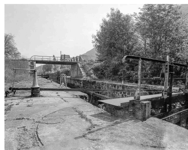
L'usine depuis la porte aval de l'écluse en 1976. Phot. Bernard Lardière IVR43_19762500096X
