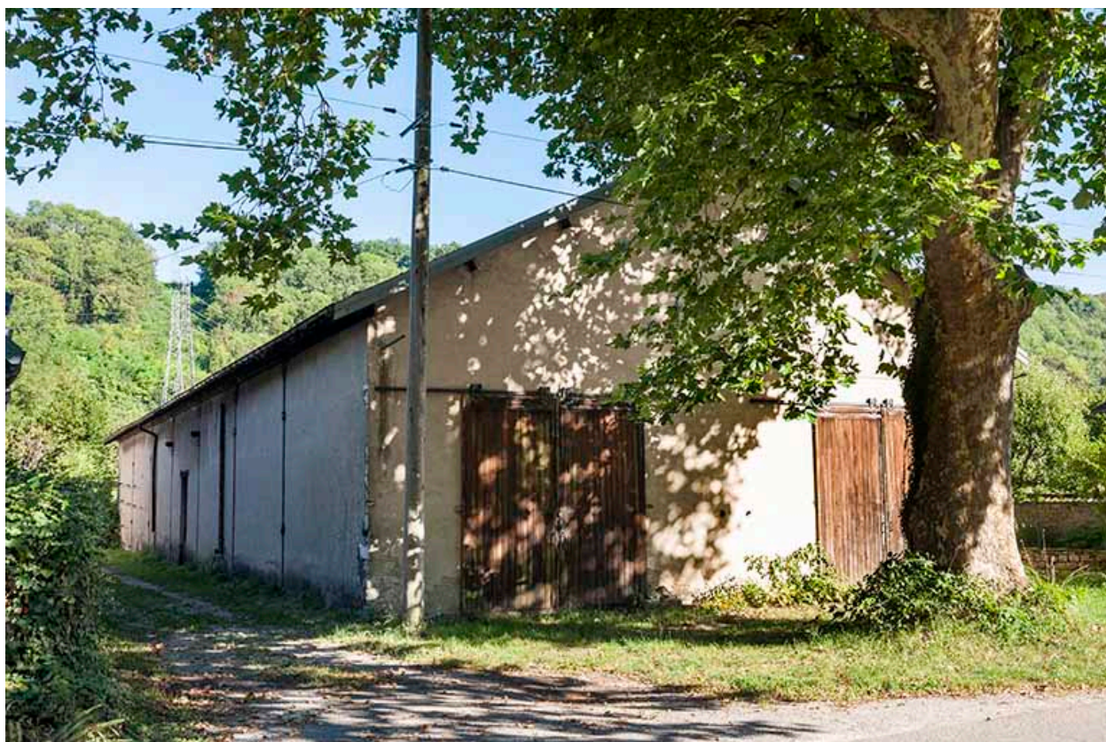
Magasin industriel vu depuis la route.
