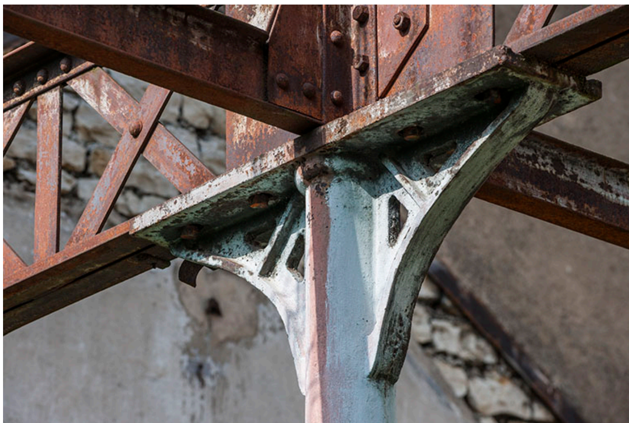
Détail de la charpente métallique.
