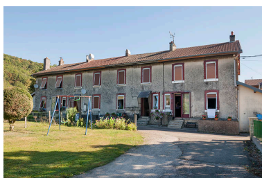
Logement ouvrier (8 appartements). Vue depuis le nord. Phot. Jérôme Mongreville
