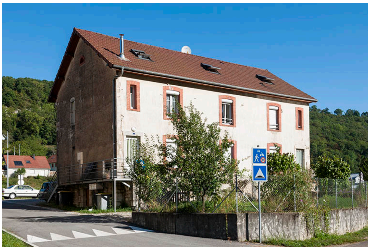
Logement ouvrier (sud) à 4 appartements. Façade est.
