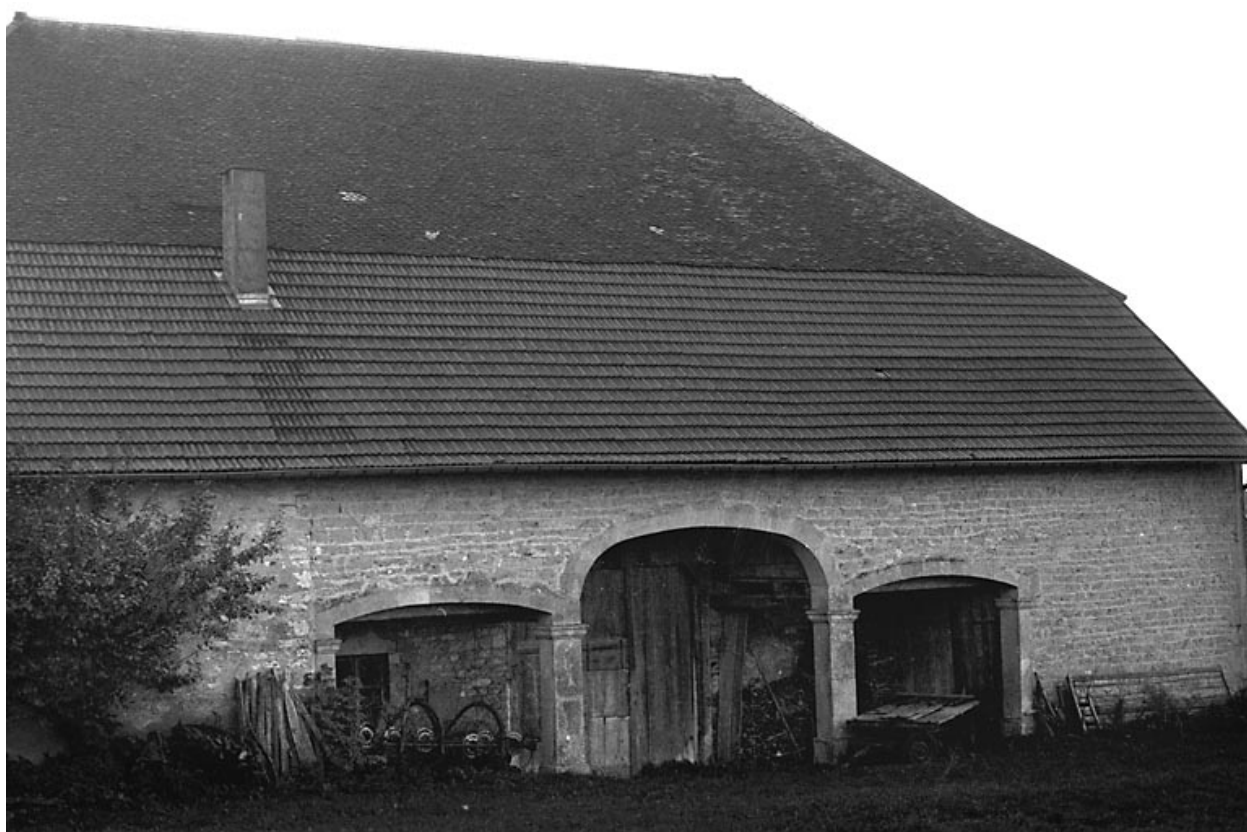
Vue du mur gouttereau droit.
