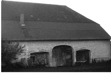
Vue du mur gouttereau droit.
