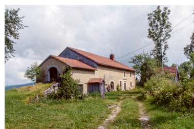
Ferme située au lieudit Les Baptaillards. Phot. Yves Sancey IVR43_19993900283ZA
