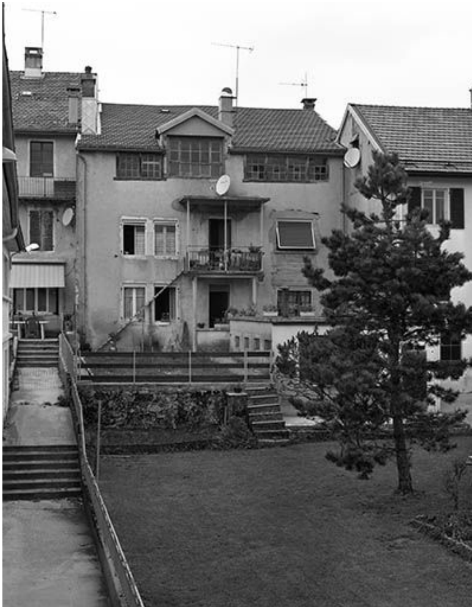
Façade postérieure d'un immeuble.
