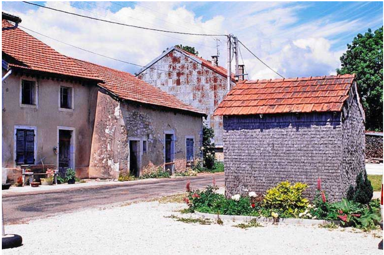
Ferme située au lieudit Orcières.
