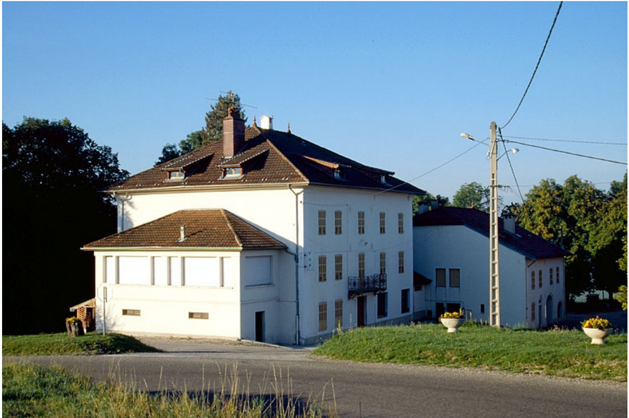
Maison, usine d'instruments de mesure, usine de lunetterie dites usine de lunetterie et fabrique de mesures linéaires Tournier Frères.
