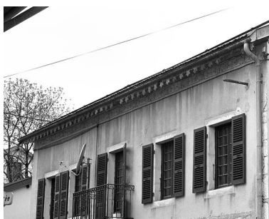
Décor en partie supérieure de la façade de la ferme transformée en maison. Phot. Jérôme Mongreville IVR43_20013900525X
