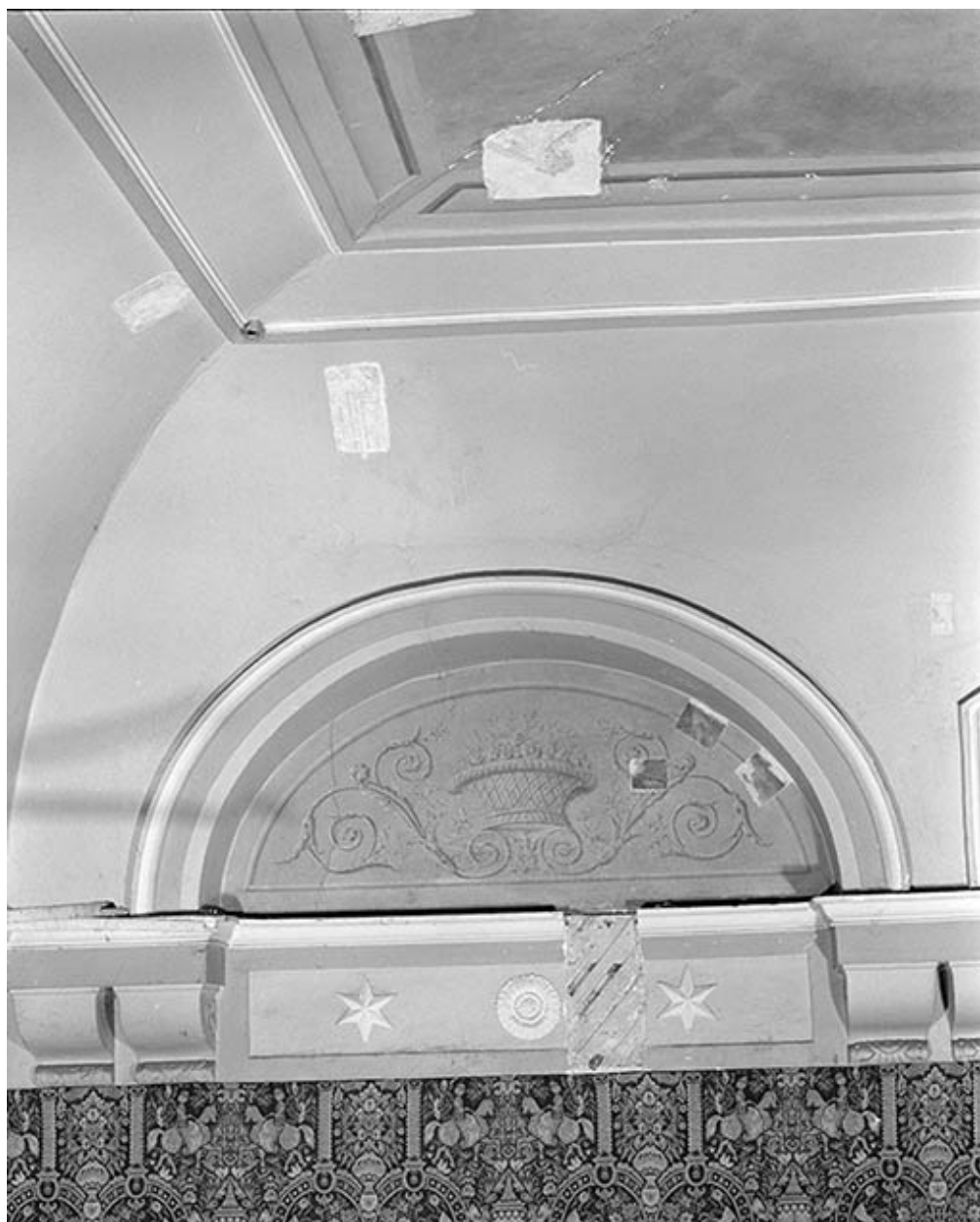
Chambre de l'Aigle, mur est, partie nord
