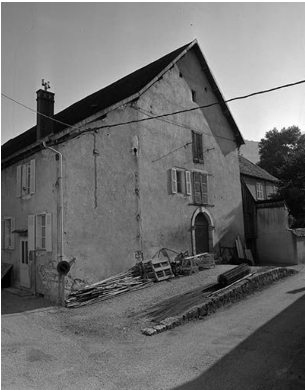
Façade antérieure de la chapelle.
