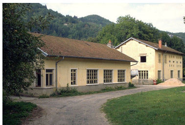
Bâtiments depuis l'entrée. Phot. Laurent Poupard IVR43_19903900573ZA
