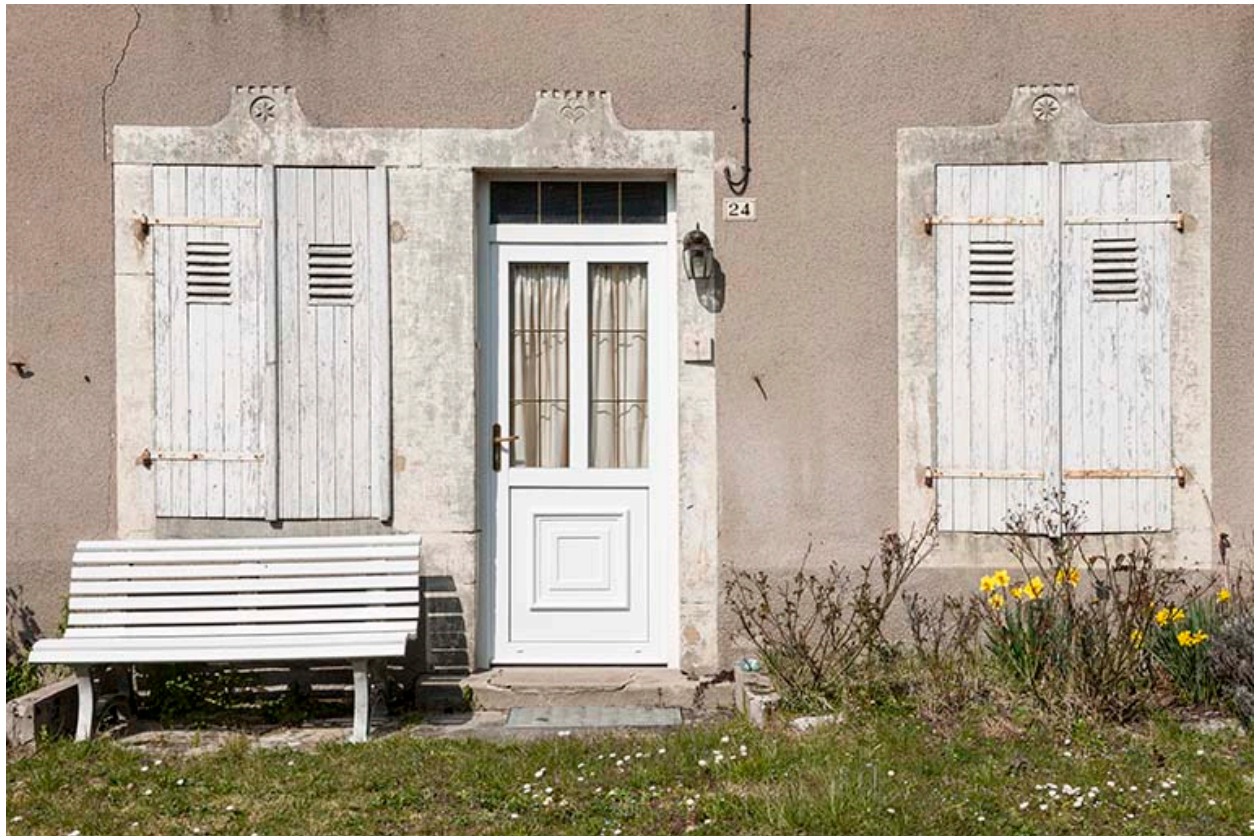
Porte d'entrée, façade principale.
