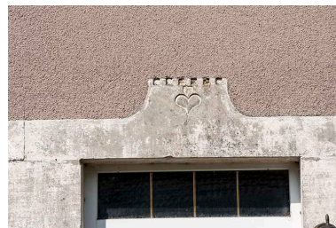
Détail du décor sur les linteaux. Phot. Jérôme Mongreville IVR43_20167000488NUC4A
