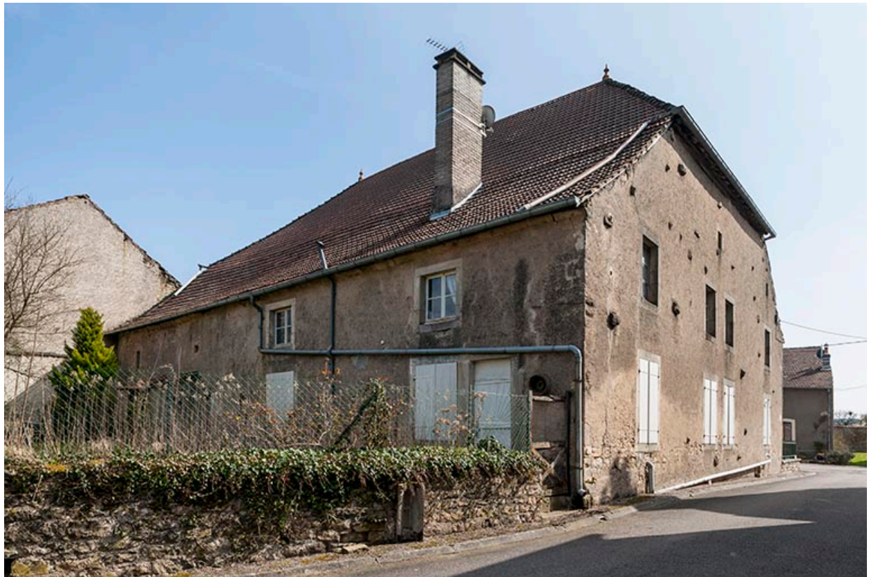
Façade postérieure et mur pignon ouest.
