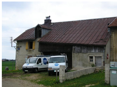
Façade postérieure. Phot. Marie-Pierre Reynet IVR43_20083900423NUC1A
