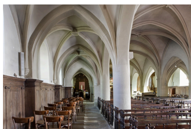
Bas-côté sud en 2021. Phot. Jérôme Mongreville IVR43_20212500312NUC4A
