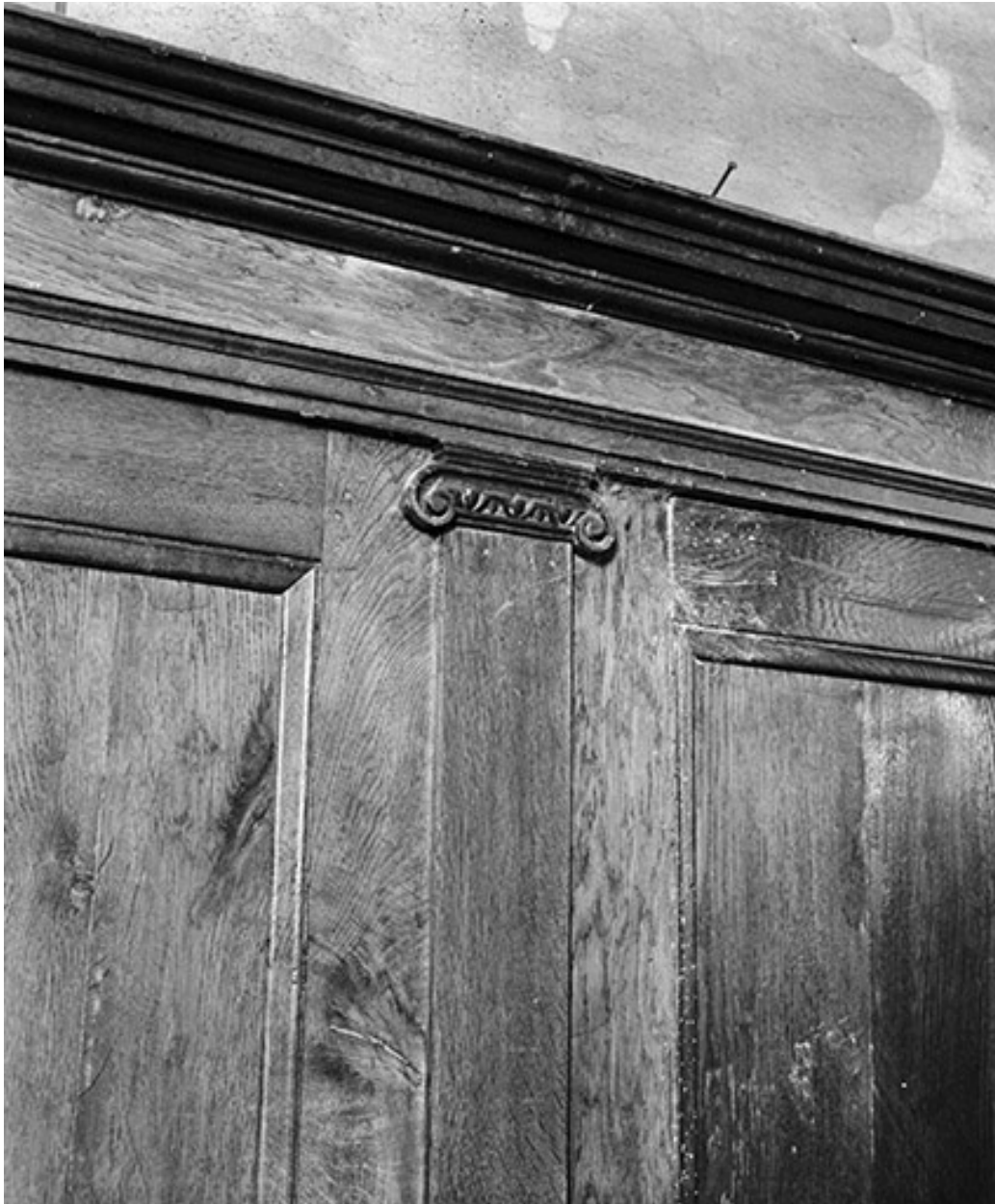
Boiseries du choeur : détail chapiteau et corniche (partie centrale).
