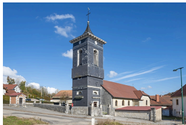
Vue de trois quarts droit en 2021. Phot. Jérôme Mongreville IVR43_20212500308NUC4A
