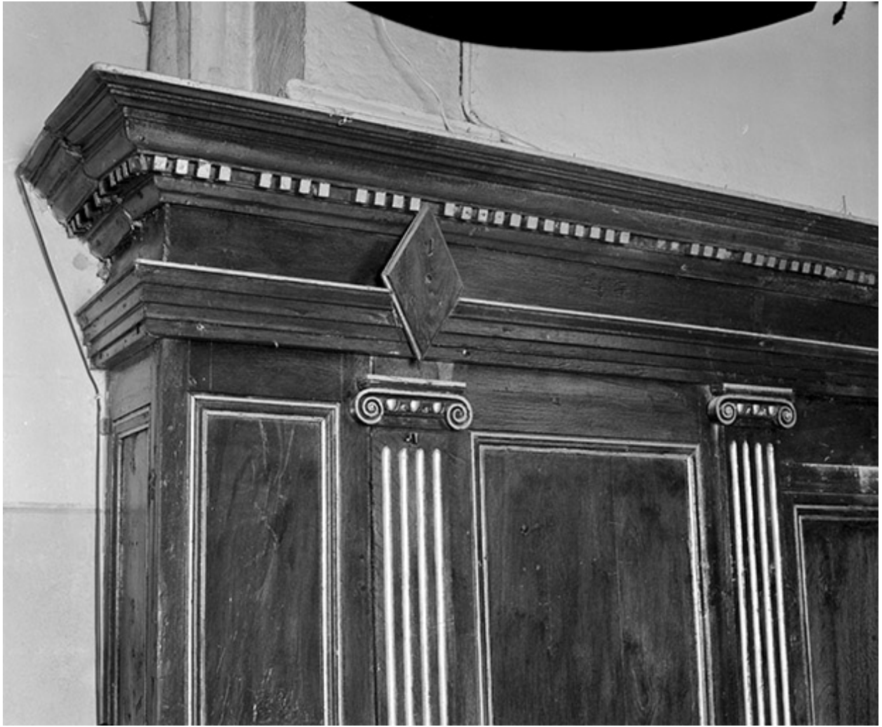
Boiseries du choeur : détail chapiteau et corniche.
