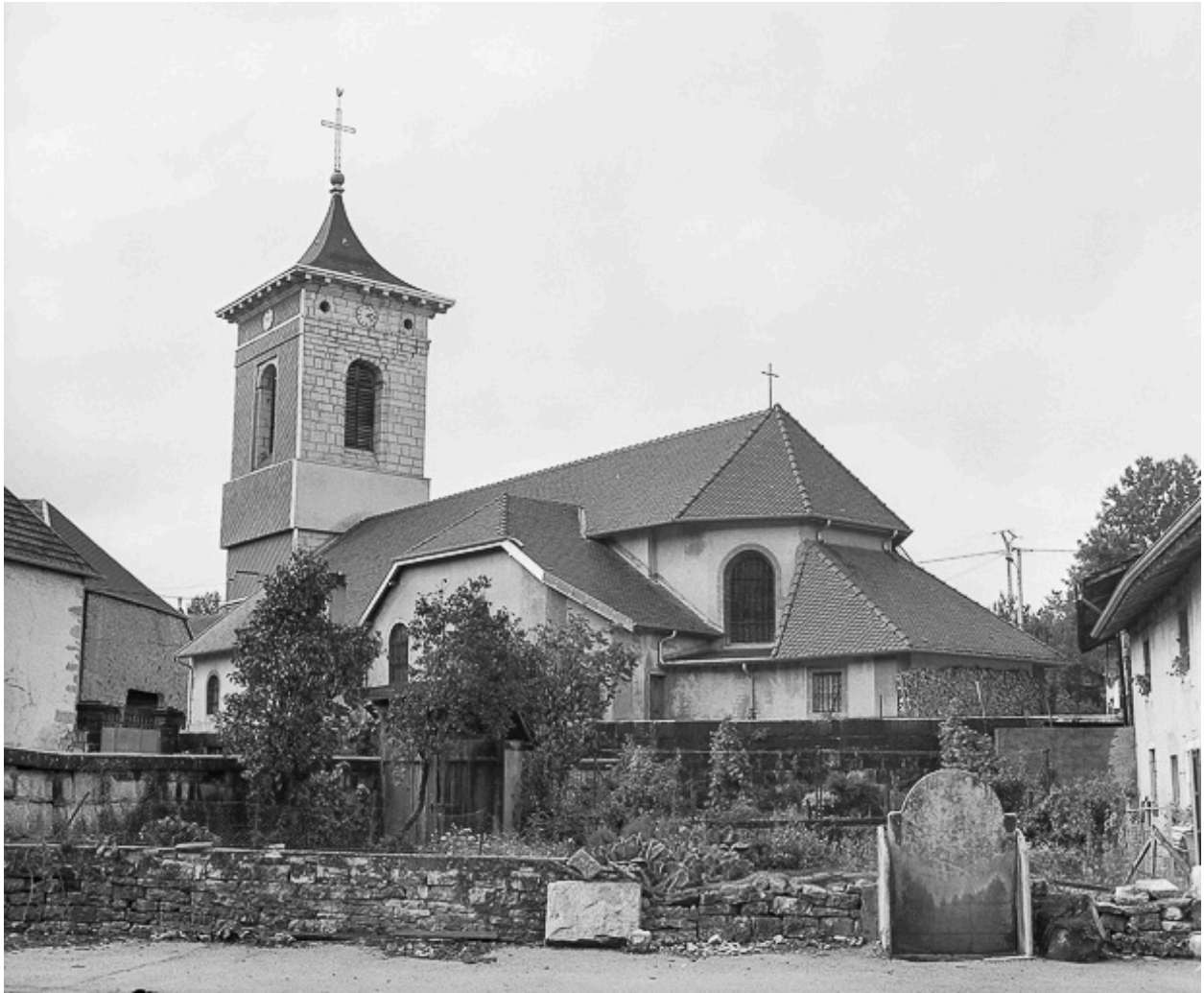
Extérieur : face latérale sud en 1976.
