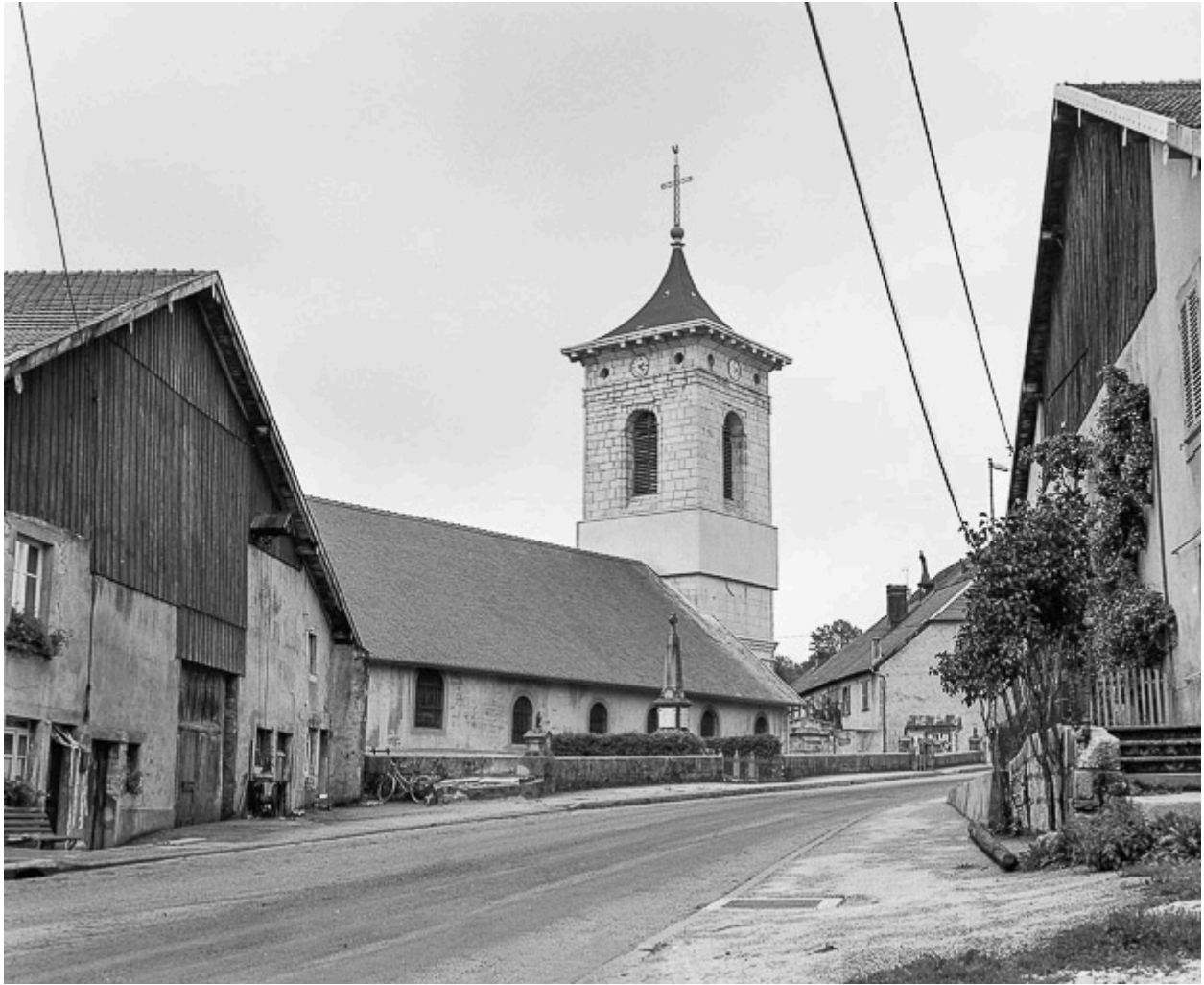
Façade latérale gauche en 1971.
