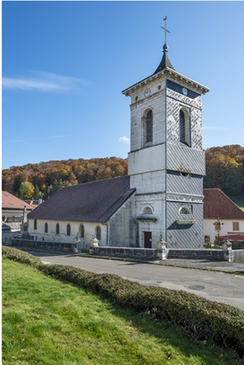
Façade latérale gauche en 2021.
