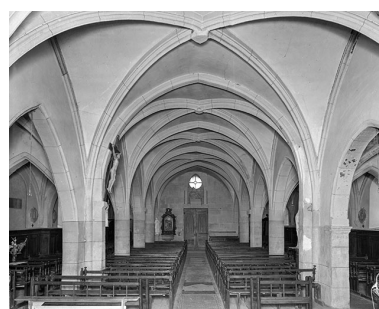
La nef vue depuis le chœur en 1976. Phot. Yves Sancey IVR43_19762500273V
