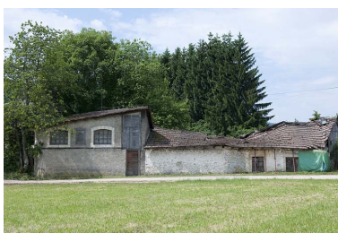
Entrepôt industriel et salle des machines. Phot. Jérôme Mongreville IVR43_20122501152NUC4A
