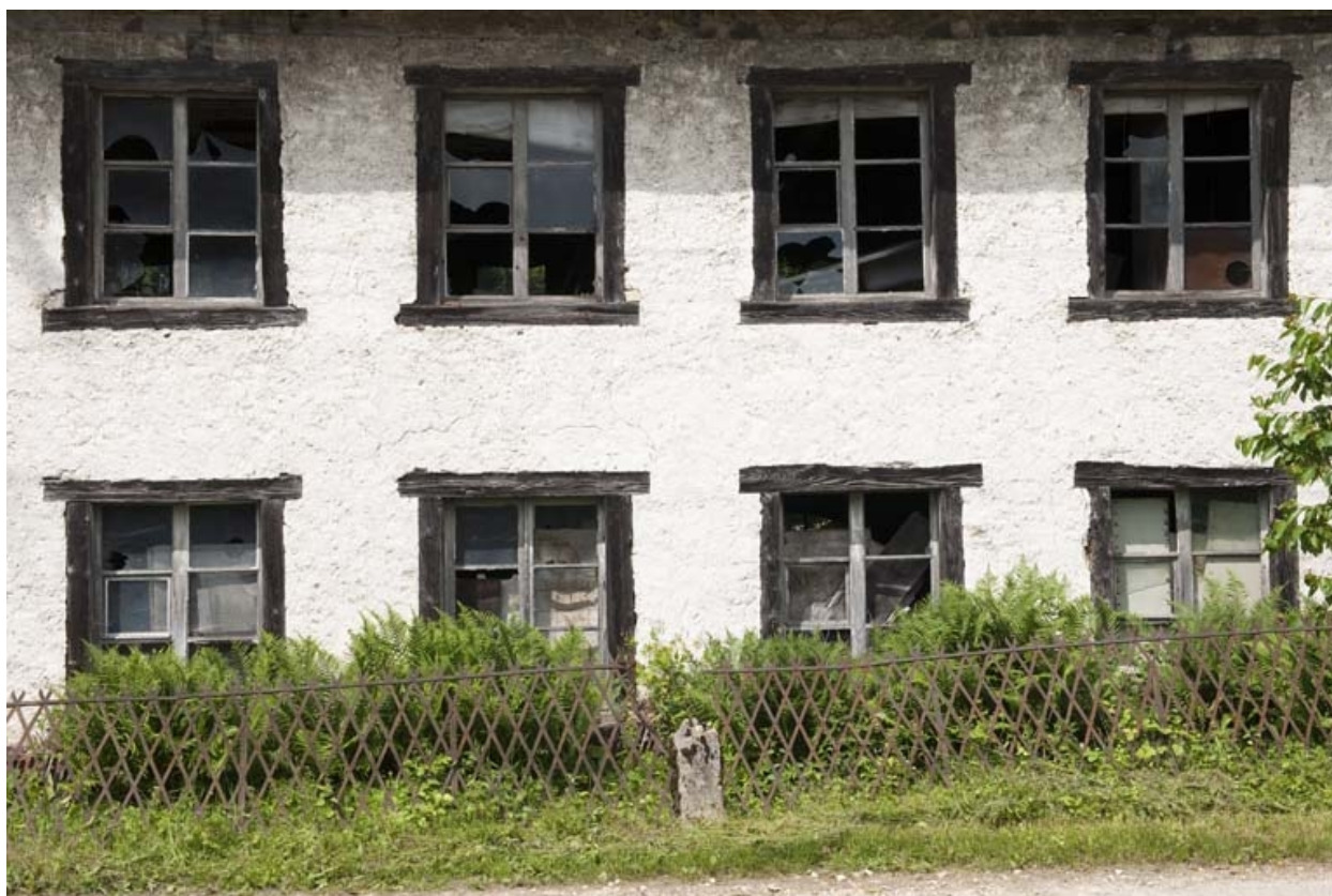
Détail de la façade est de l'atelier.
