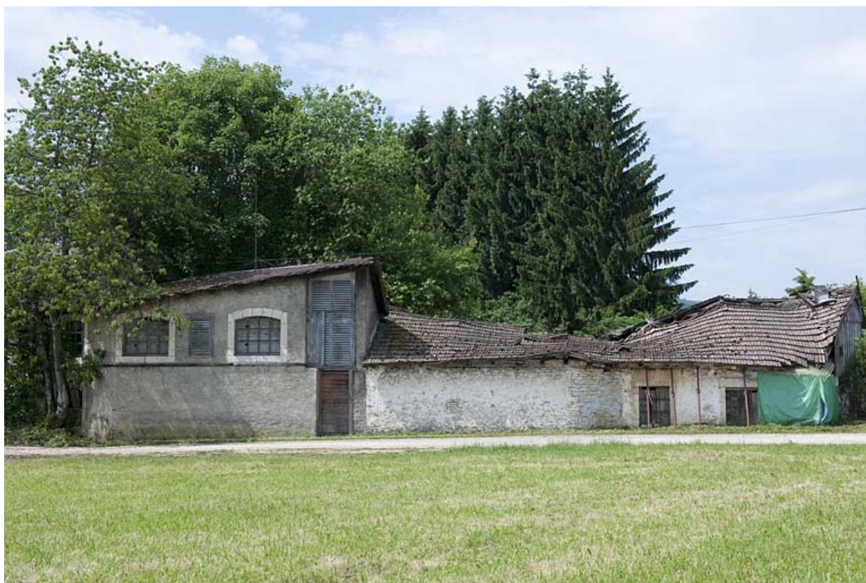
Entrepôt industriel et salle des machines.
