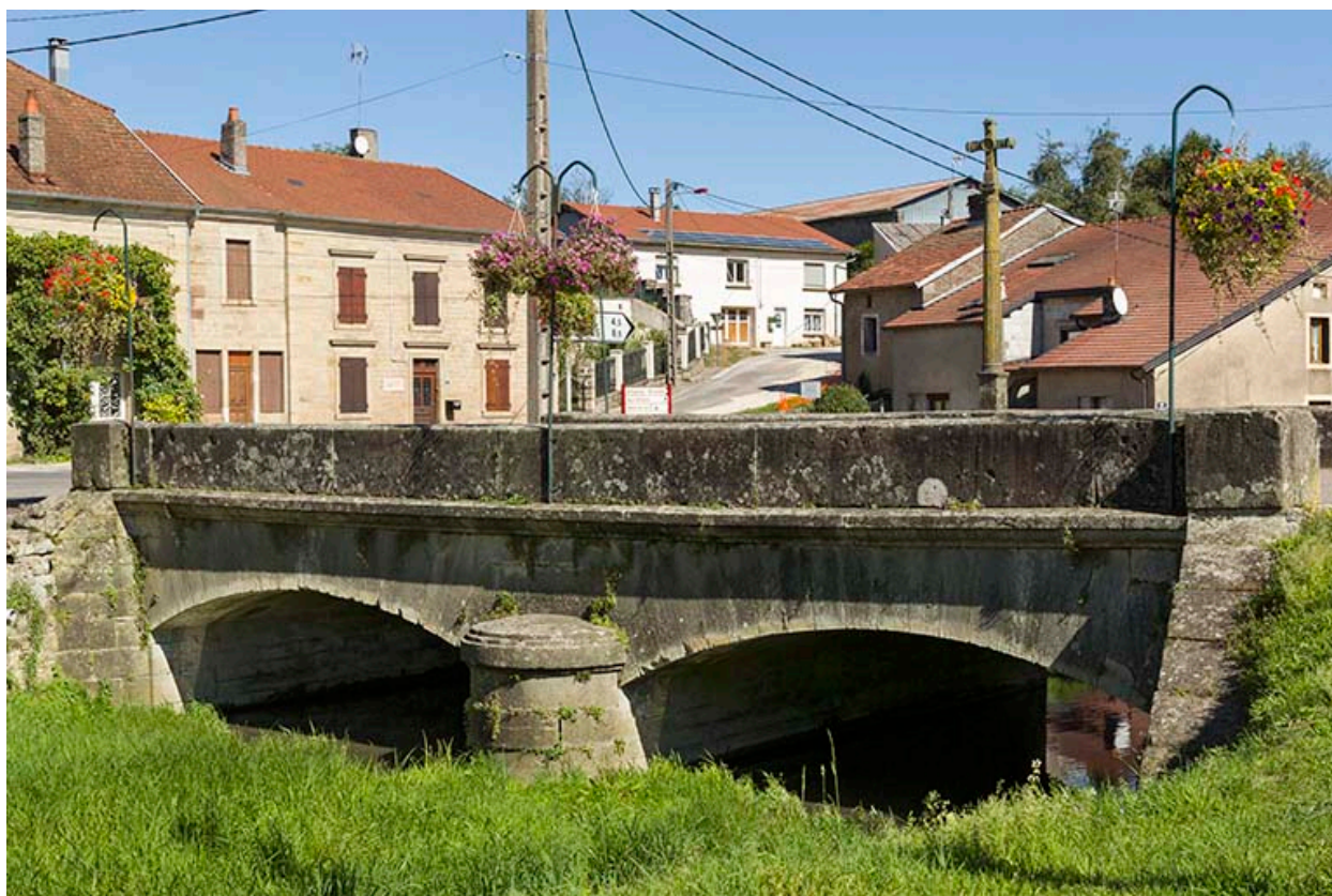
Pont avec une croix enjambant le ruisseau de la Noué.
