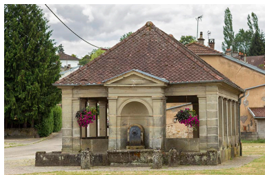
Fontaine-lavoir de la rue Charrière de Vouécourt. Phot. Sonia Dourlot IVR43_20157000570NUC2A
