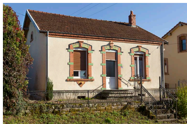
Maison d'ouvrier. Phot. Sonia Dourlot IVR43_20157000647NUC2A
