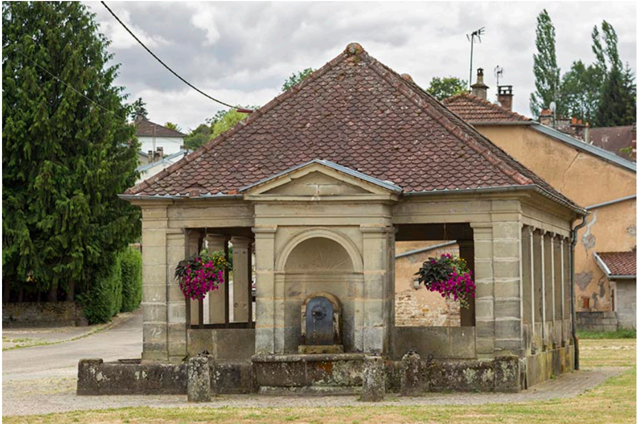
Fontaine-lavoir de la rue Charrière de Vouécourt.
