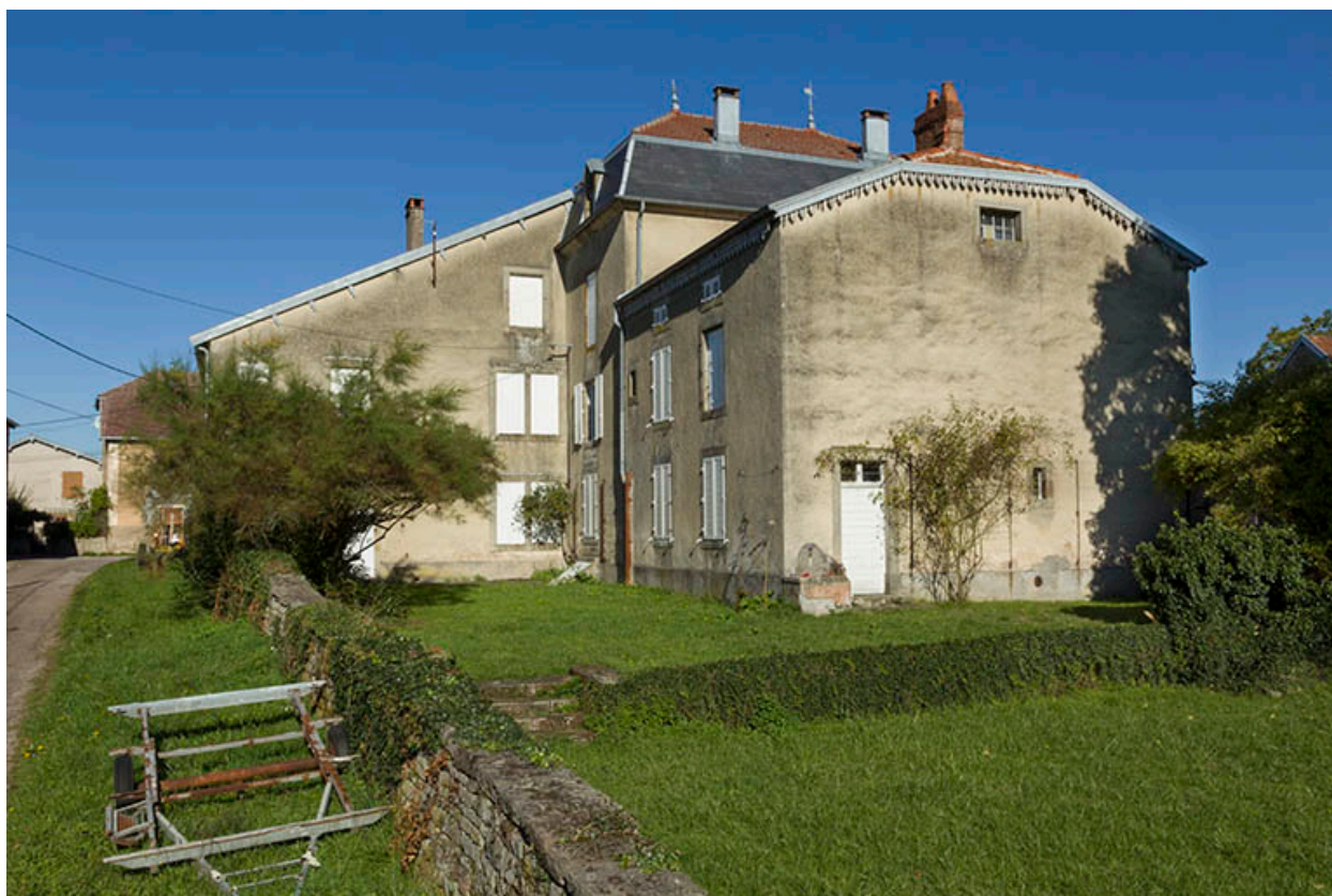
Maison, rue du Château, façades postérieures.
