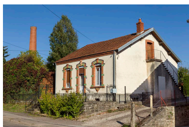
Logement d'ouvrier. Phot. Sonia Dourlot IVR43_20157000648NUC2A
