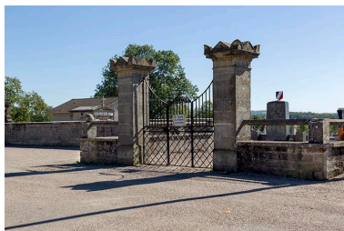
Le cimetière transféré au 19e siècle, rue du Cimetière. Phot. Sonia Dourlot IVR43_20157000642NUC2A
