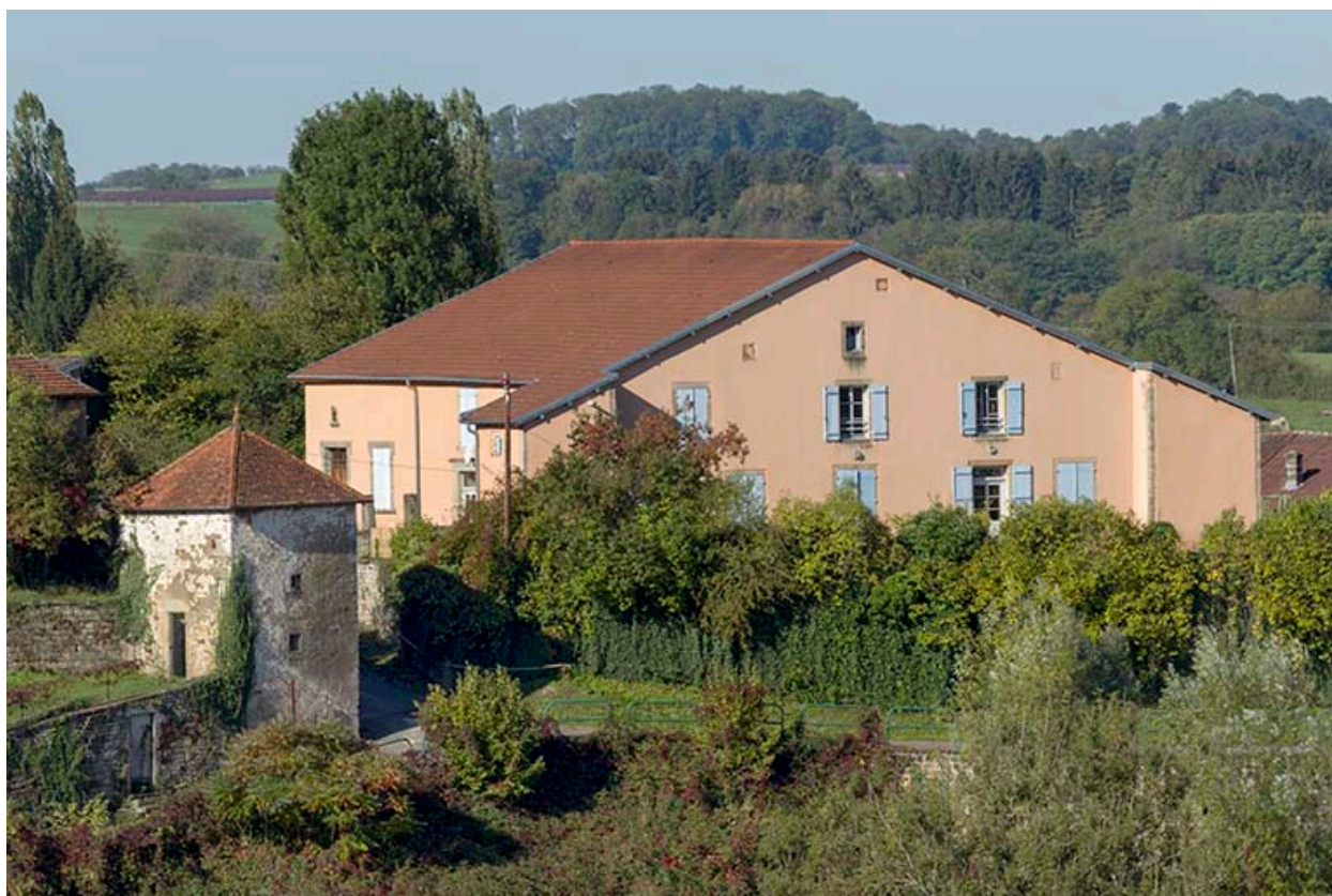
Maison comprise dans l'ancienne enceinte fortifiée du bourg.
