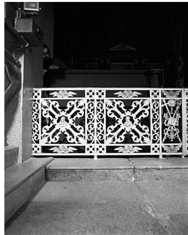
Détail : partie gauche. Phot. Yves Sancey IVR43_19742500274X
