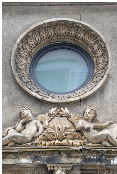
Vue rapprochée. Phot. Jérôme Mongreville IVR43_20223900318NUC4A
