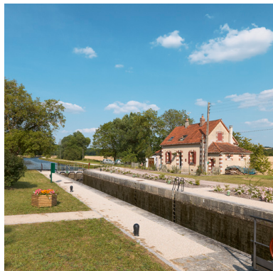
Vue d'aval du site d'écluse. Phot. Thierry Kuntz IVR26_20138900085NUC4A
