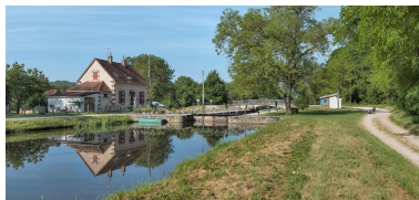
Vue d'amont du site d'écluse. Phot. Thierry Kuntz IVR26_20138900080NUC4A
