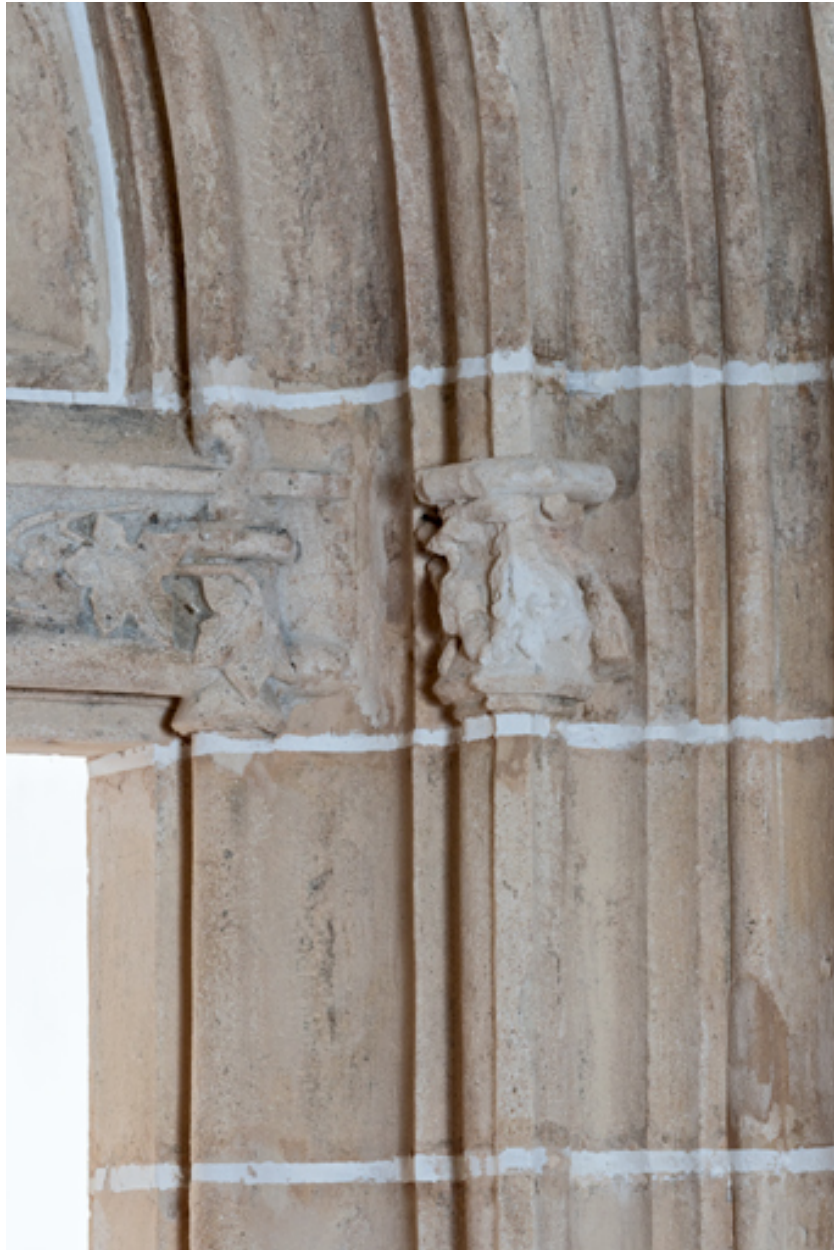
Détail : piédroit, partie supérieure.
