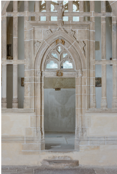
Détail : porte. Phot. Pierre-Marie Barbe-Richaud IVR26_20237100321NUC4A
