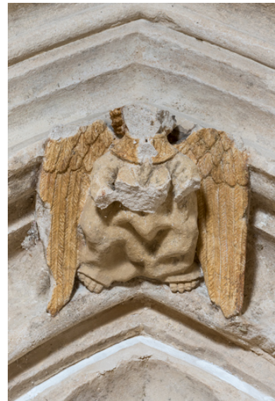
Détail : ange porteur d'écu de la voussure. Phot. Pierre-Marie Barbe-Richaud IVR26_20237100312NUC4A
