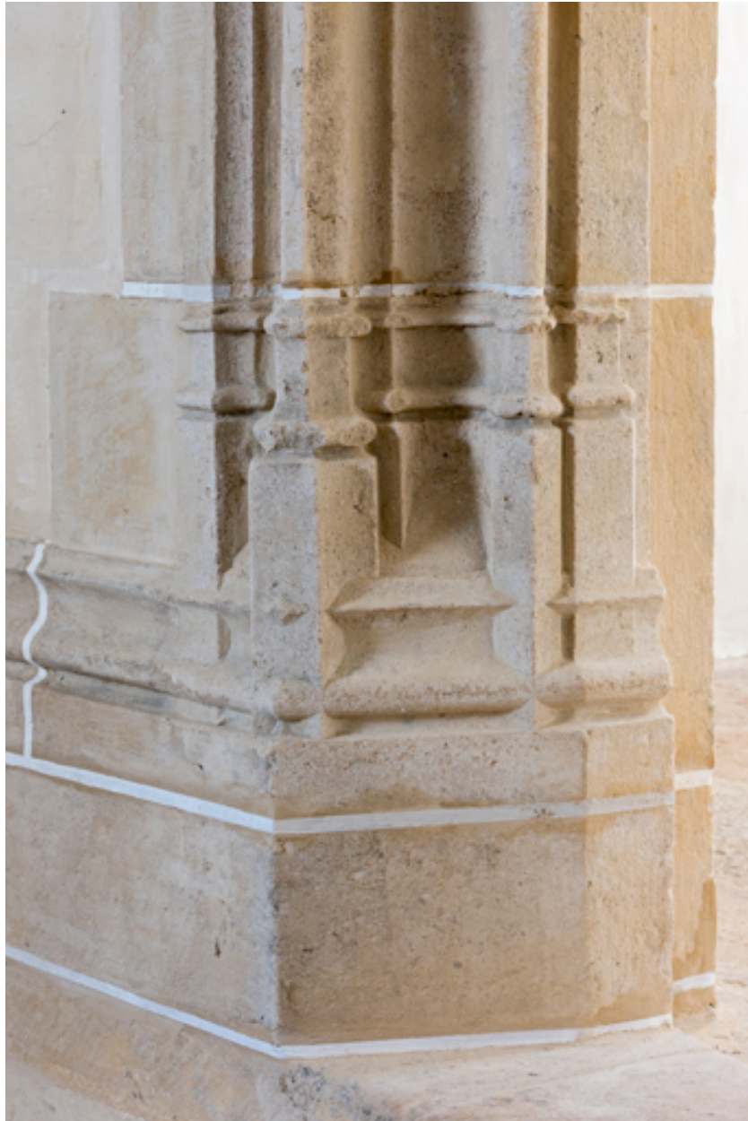
Détail : piédroit, partie inférieure.
