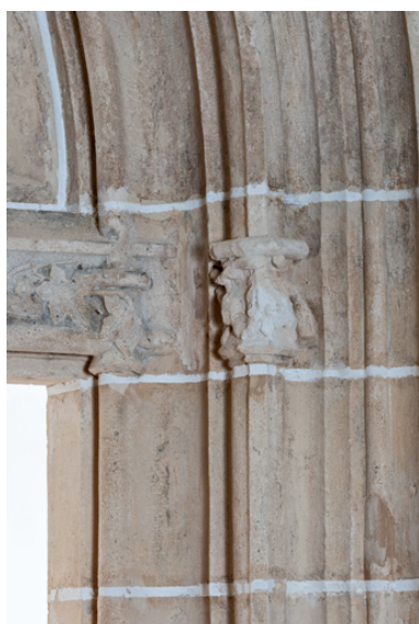
Détail : piédroit, partie supérieure. Phot. Pierre-Marie Barbe-Richaud IVR26_20237100313NUC4A
