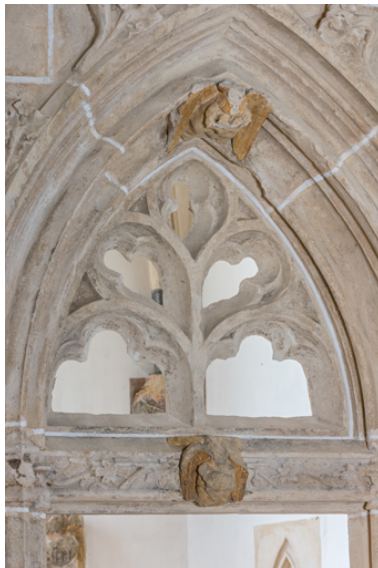
Détail : linteau et tympan ajouré, vus de trois quarts. Phot. Pierre-Marie Barbe-Richaud IVR26_20237100317NUC4A
