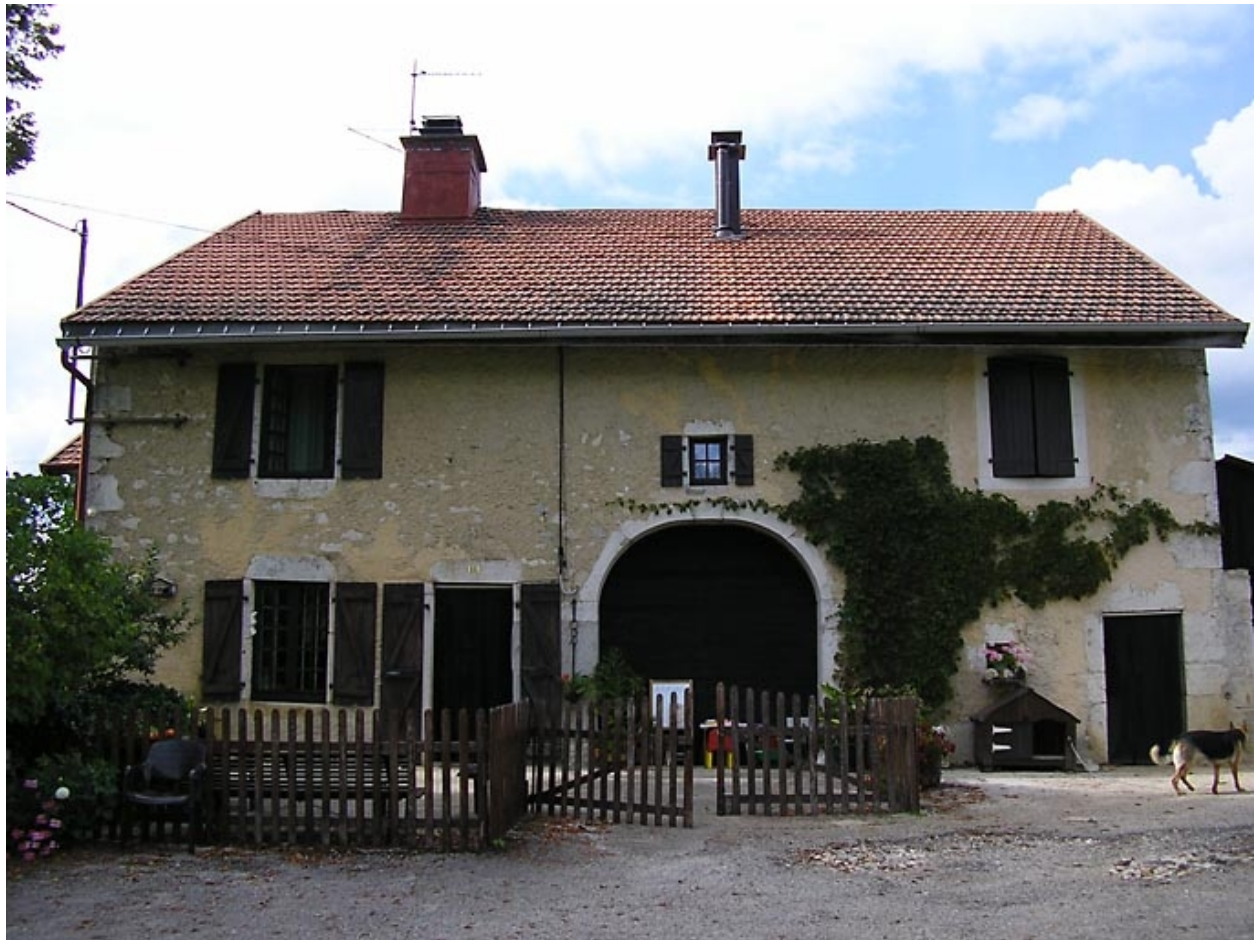
Vue générale de la façade antérieure.
