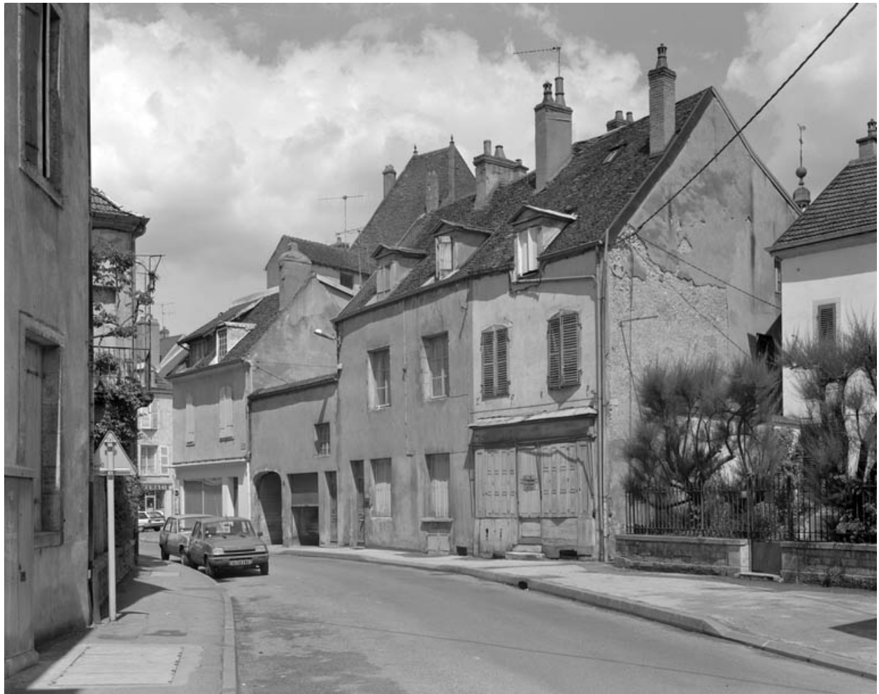
Partie de l'édifice donnant rue des Casernes.
