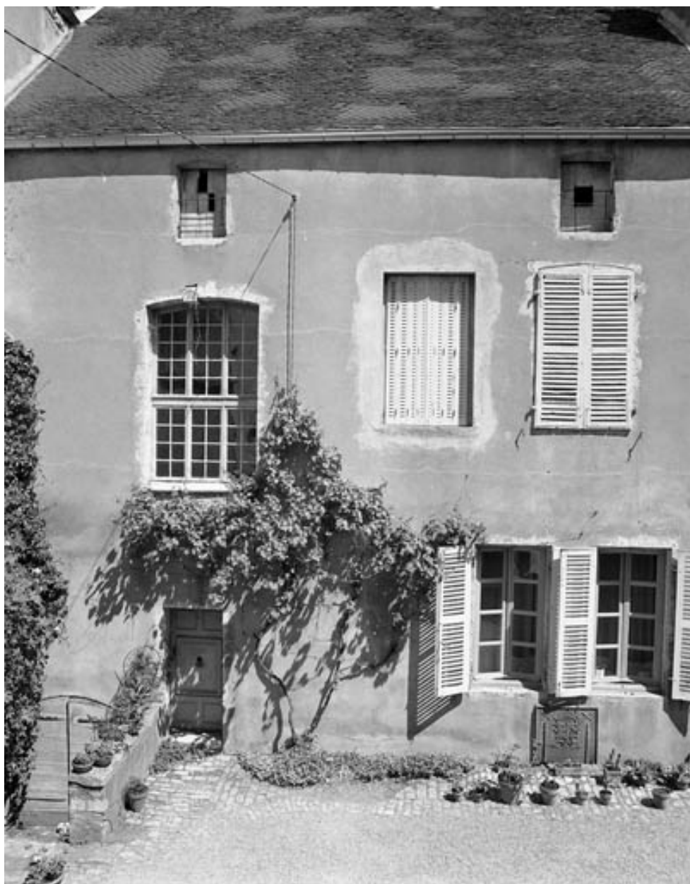
Façade postérieure de l'édifice principal.
