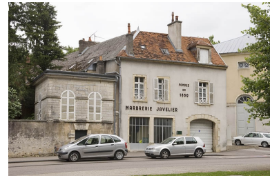
Vue d'ensemble depuis la rue Revon.
