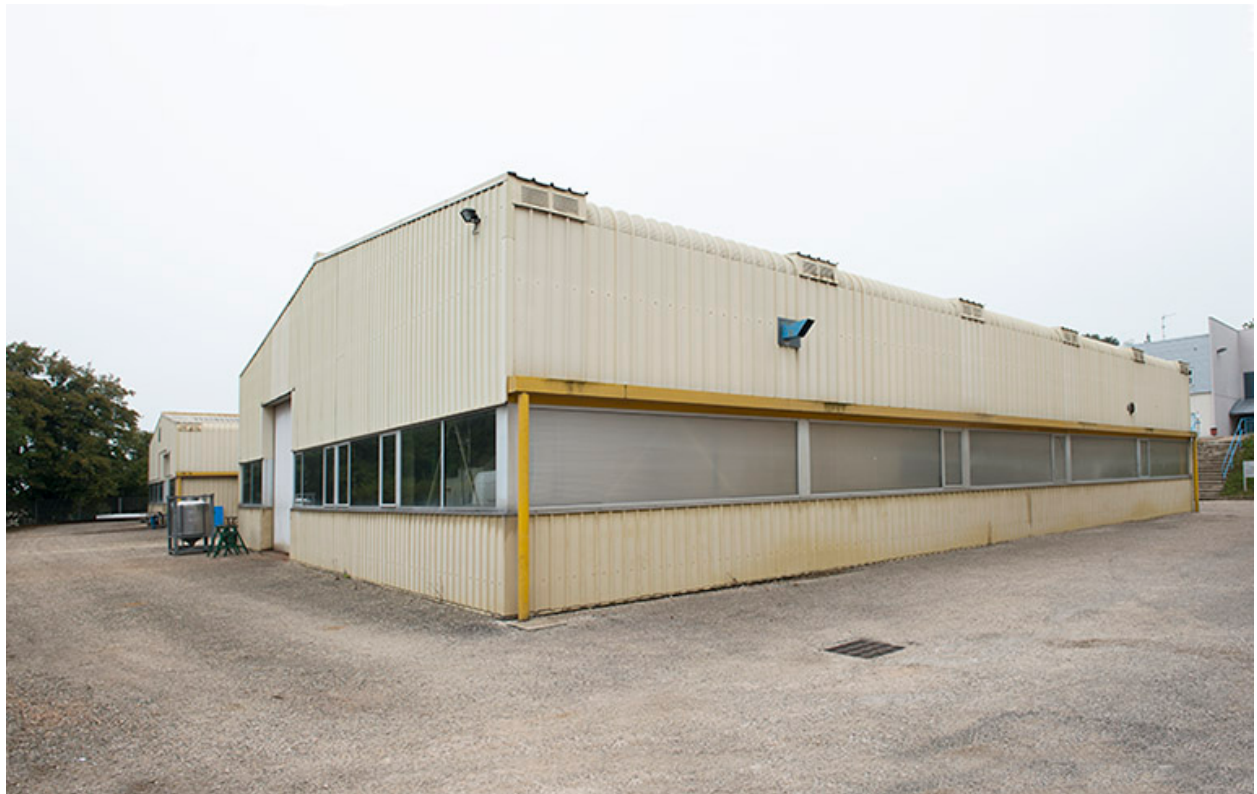
Atelier : vue trois-quart.
