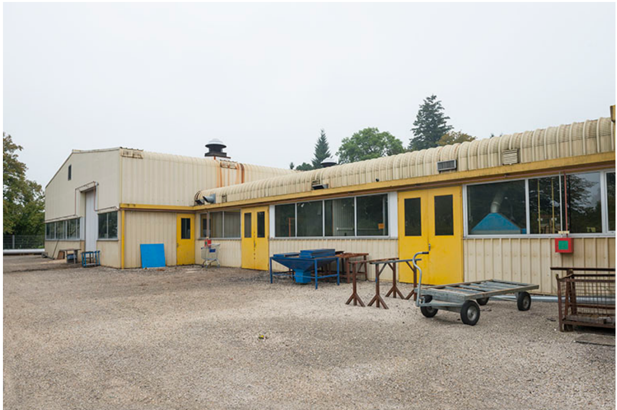
Ateliers : façade antérieure.
