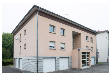
Vue 3/4 du bâtiment de logements. Phot. Mary Ruffinoni IVR43_20143900772NUC4A
