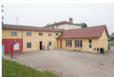
Externat : vue 3/4 de l'espace cafétéria. Phot. Mary Ruffinoni IVR43_20143900776NUC4A
