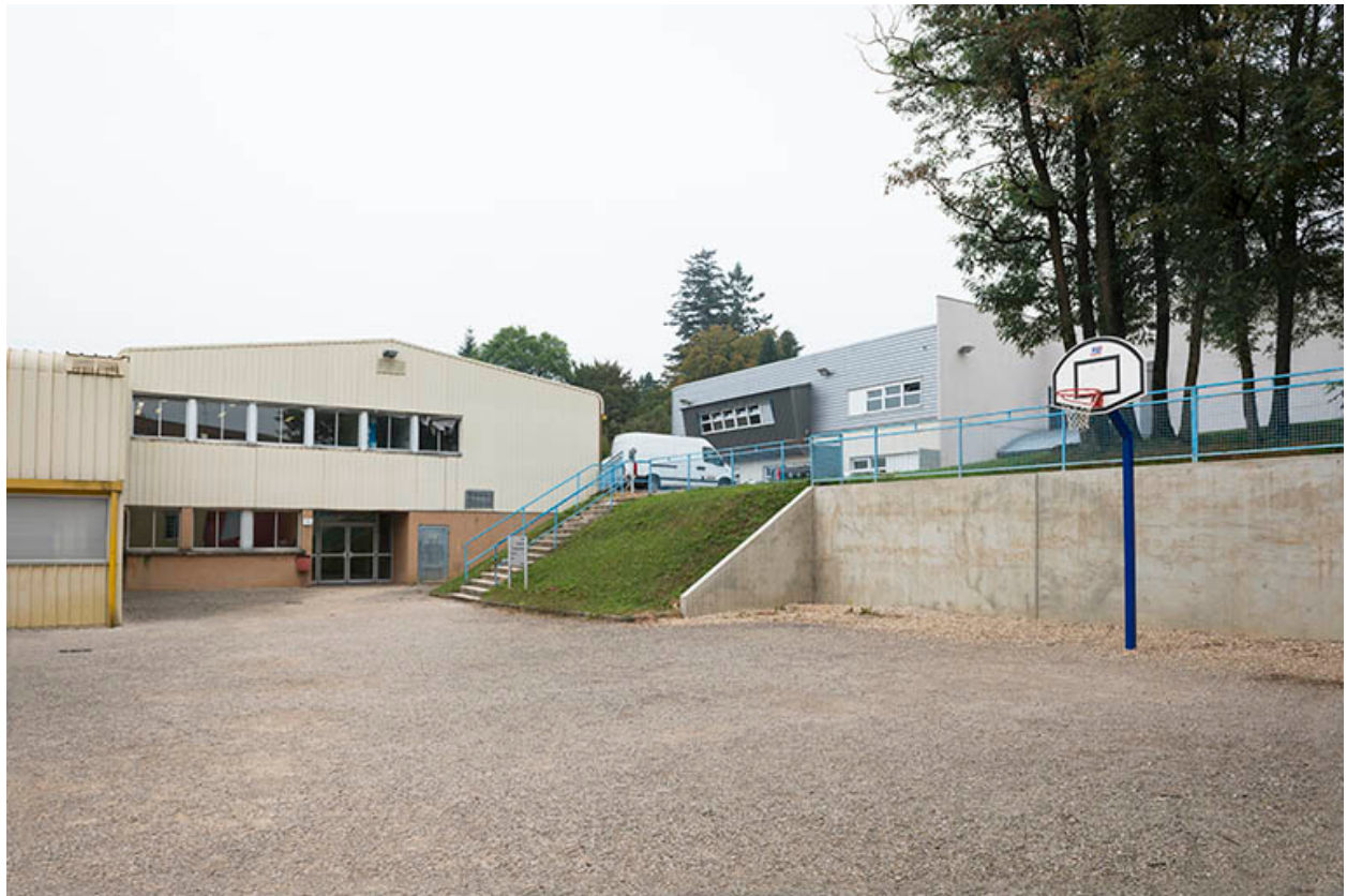
Ateliers : façade sud.
