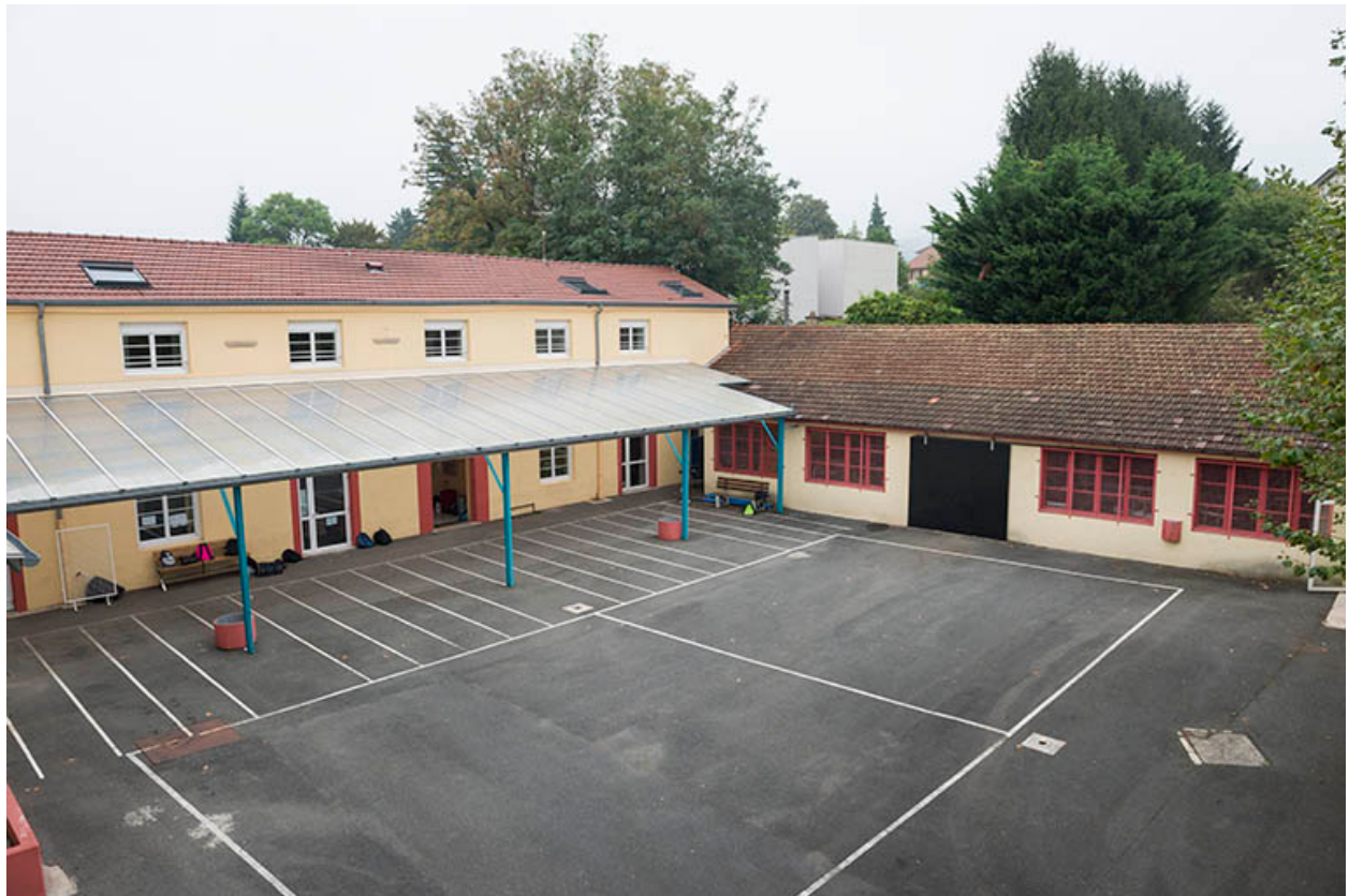
Externat - cafétéria : vue des façades sur cour.
