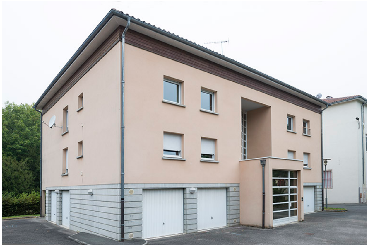
Vue 3/4 du bâtiment de logements.
