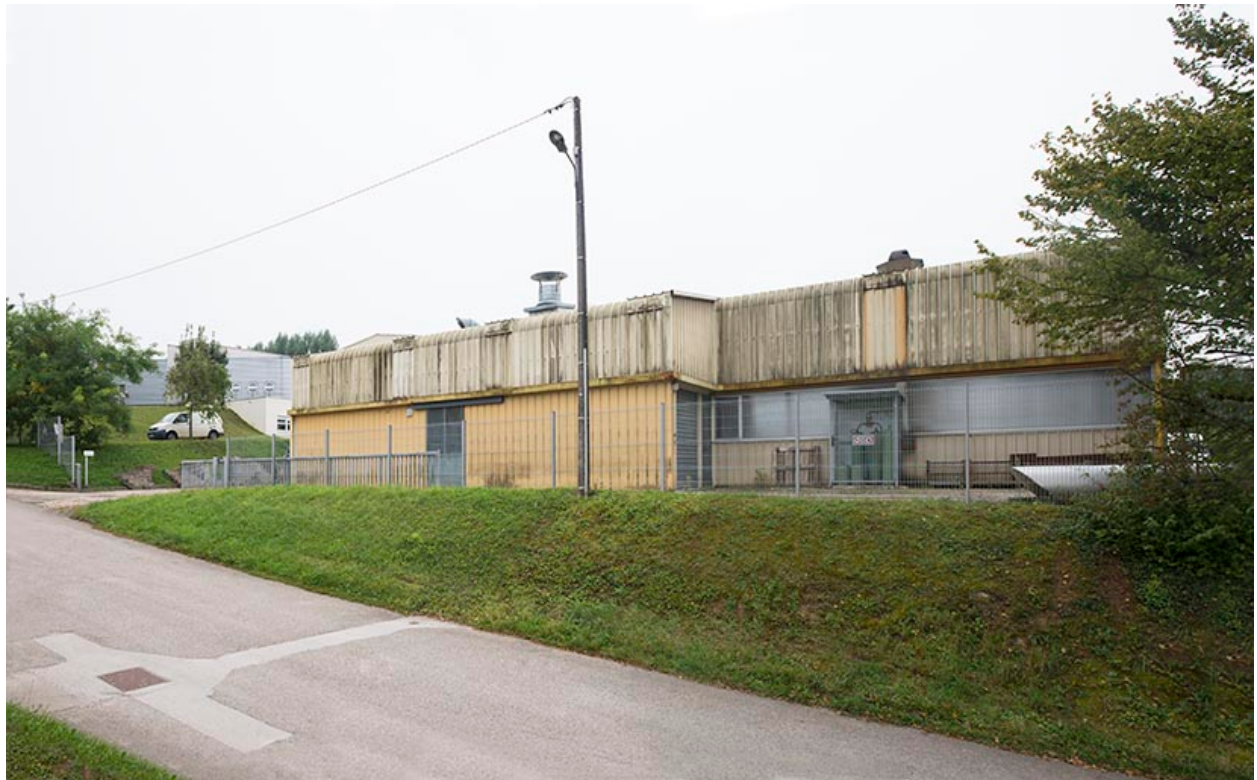
Atelier : façades Est.
