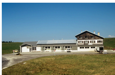
Vue d'ensemble. Phot. Jérôme Mongreville IVR43_19943901247ZA
