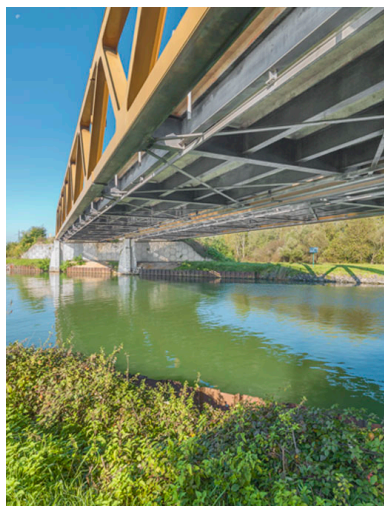
Le tablier du pont. Phot. Thierry Kuntz IVR26_20172100486NUC4A
