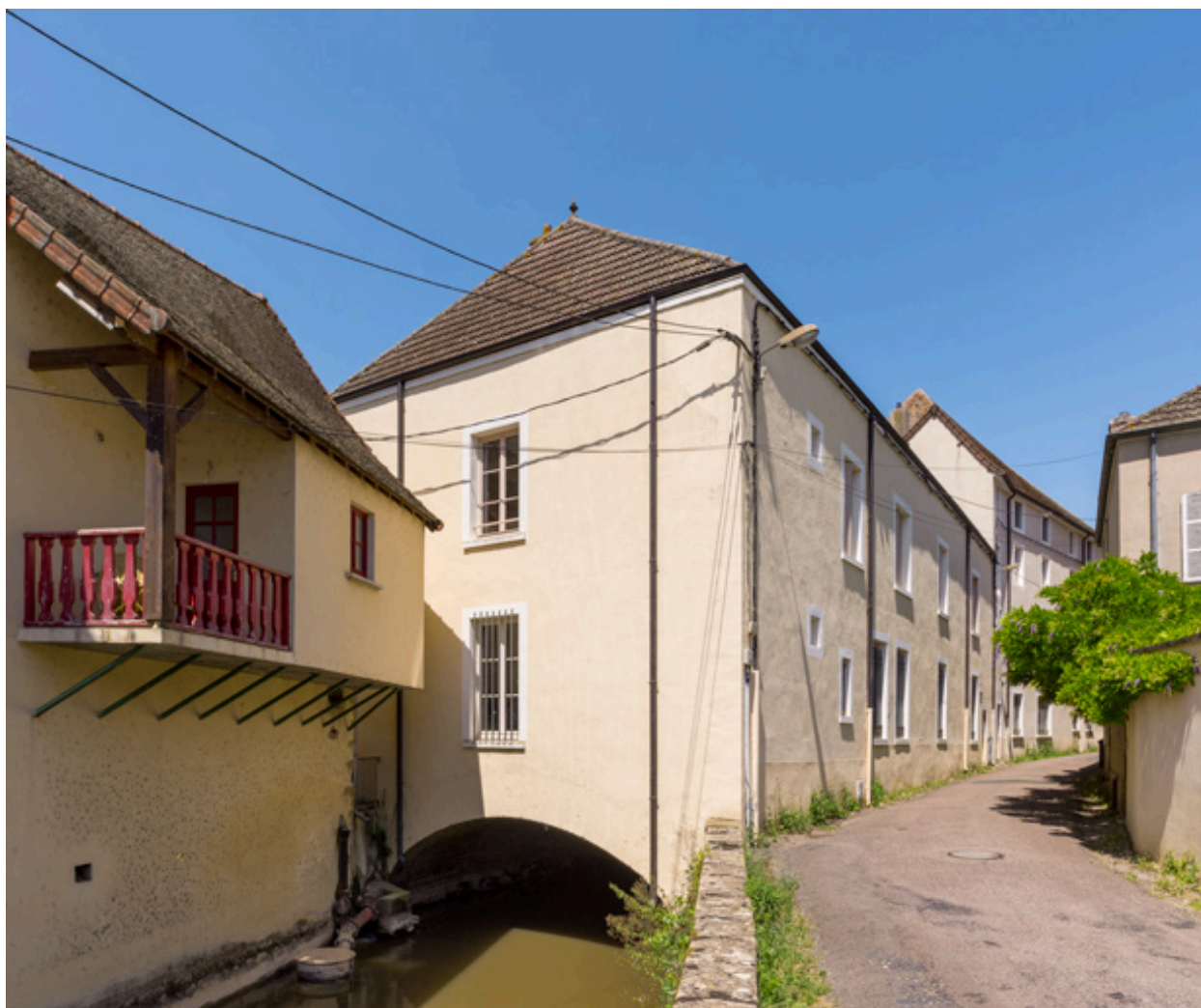
Façades postérieure (sur la rue des Marais) et latérale droite (sur la Semence), depuis le sud.
