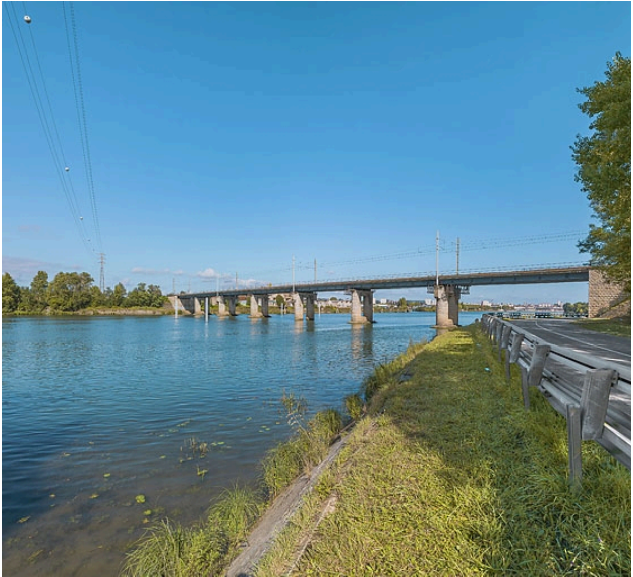
Le pont vu d'aval, rive gauche.
