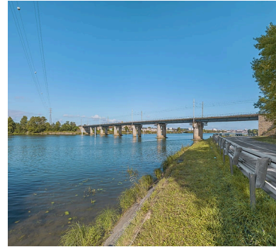
Le pont vu d'aval, rive gauche. Phot. Thierry Kuntz IVR26_20217100583NUC4A
