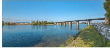
Le pont vu d'aval, rive gauche. Phot. Thierry Kuntz IVR26_20217100582NUC4A
