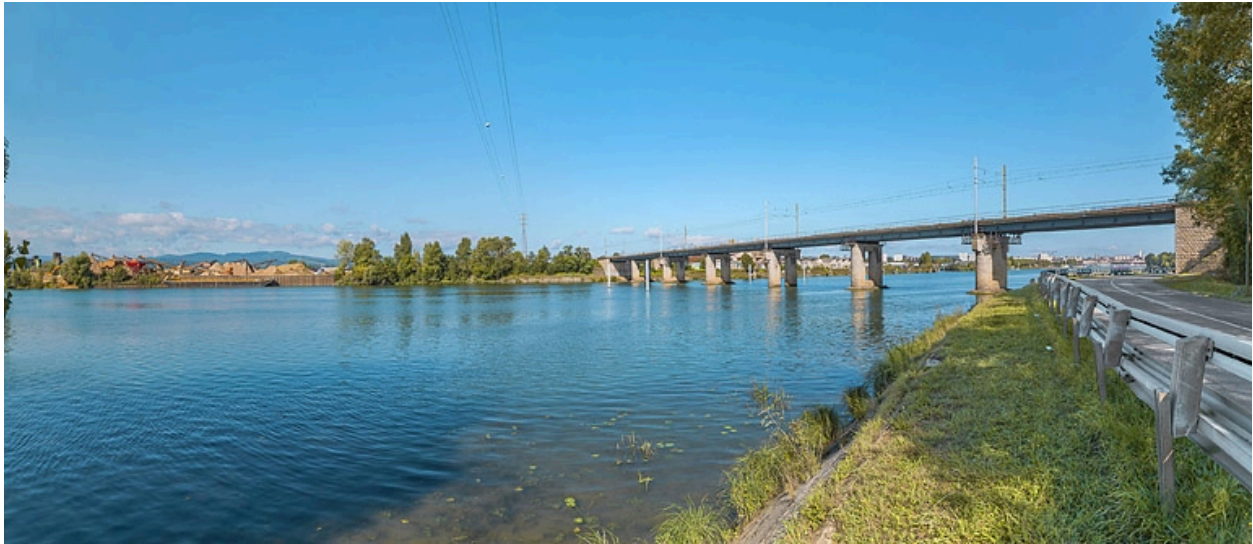
Le pont vu d'aval, rive gauche.
