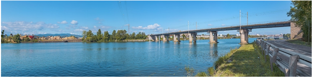
Le pont vu d'aval, rive gauche.
