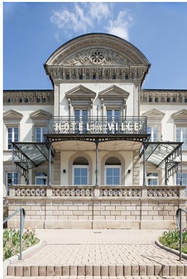
Façade antérieure. Détail de l'avant-corps central. Phot. Jérôme Mongreville IVR43_20132500280NUC4A
