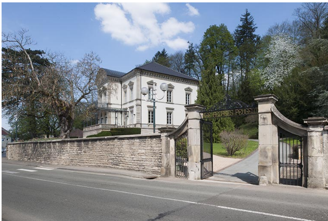
Vue rapprochée depuis le sud-ouest.
