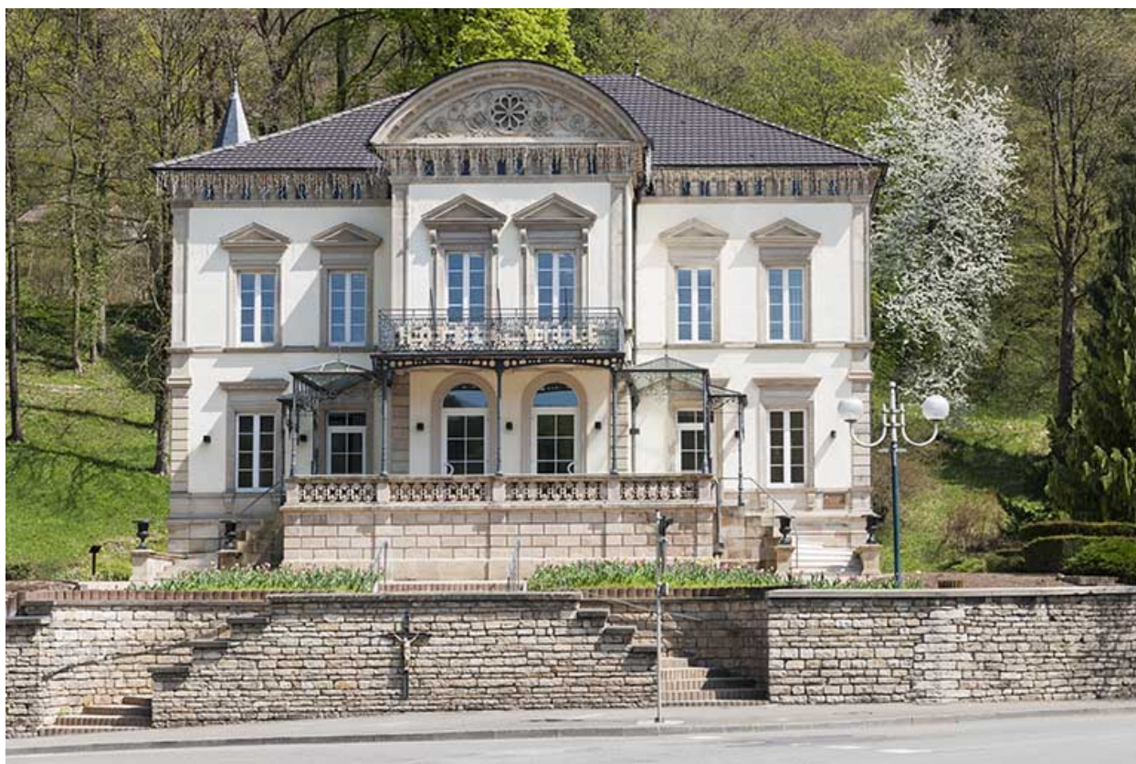
Façade antérieure vue de face.
