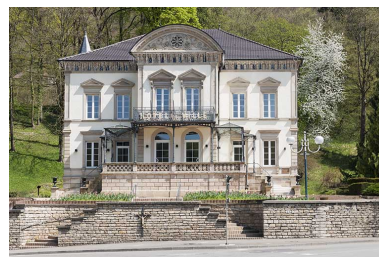
Façade antérieure vue de face. Phot. Jérôme Mongreville IVR43_20132500276NUC4A
