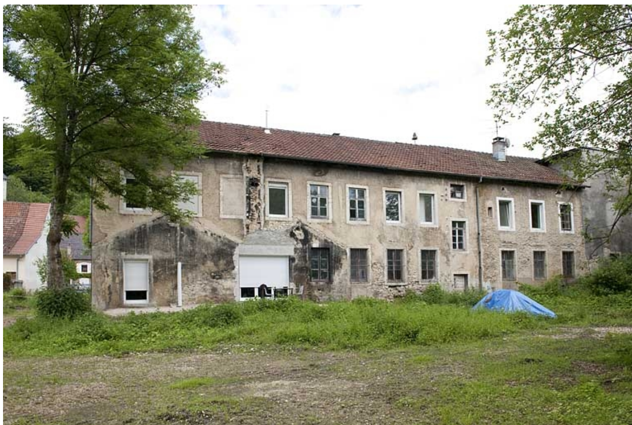
Façade postérieure des logements et bureaux.
