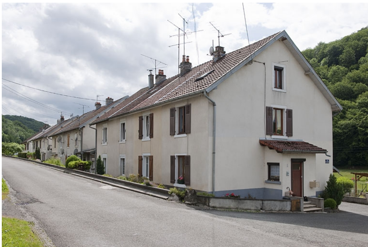
Logements ouvriers depuis le nord.
