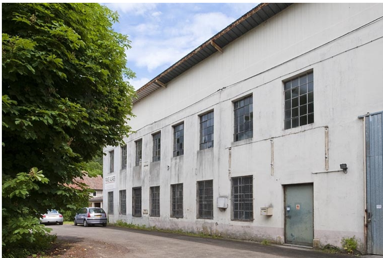
Façade nord de l'atelier de fabrication.
