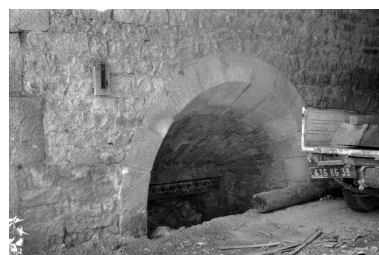
Ouverture de défournement nord. Phot. Laurent Poupard IVR43_19893900173Z
