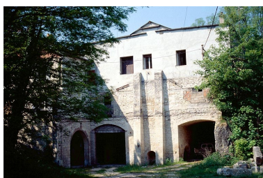
Base du four à chaux, depuis l'est. Phot. Laurent Poupard IVR43_19893900172ZA
