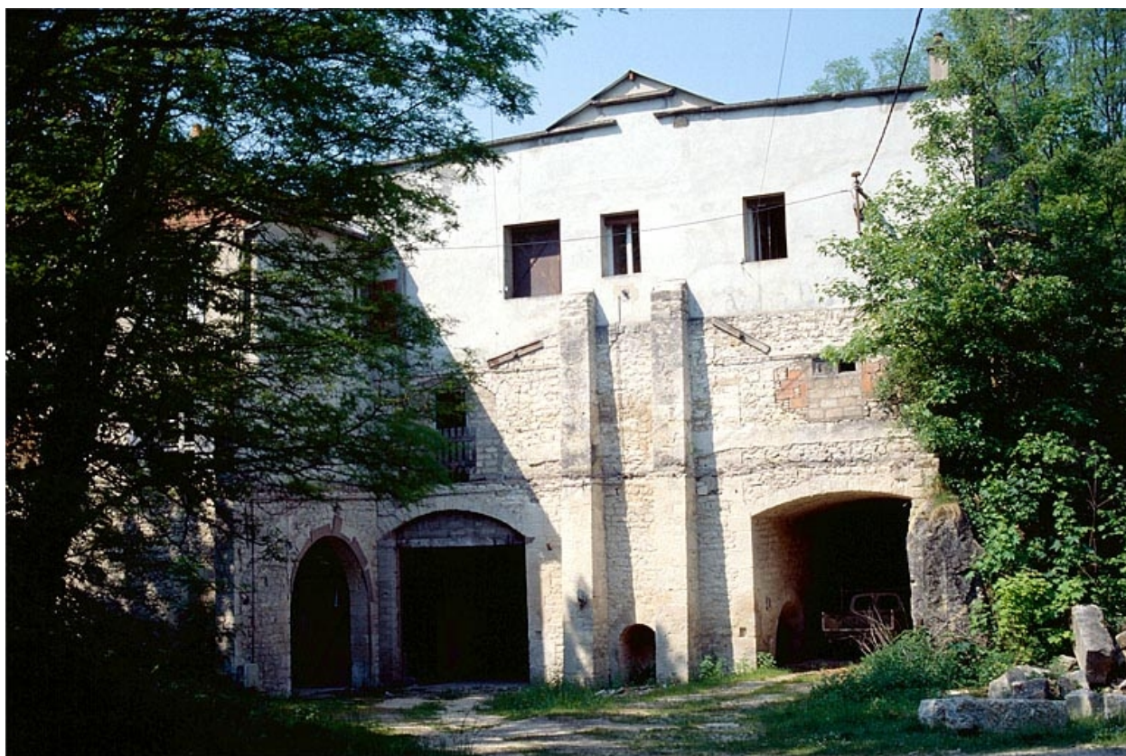
Base du four à chaux, depuis l'est.
