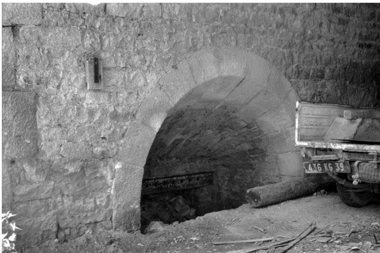
Ouverture de défournement nord.
