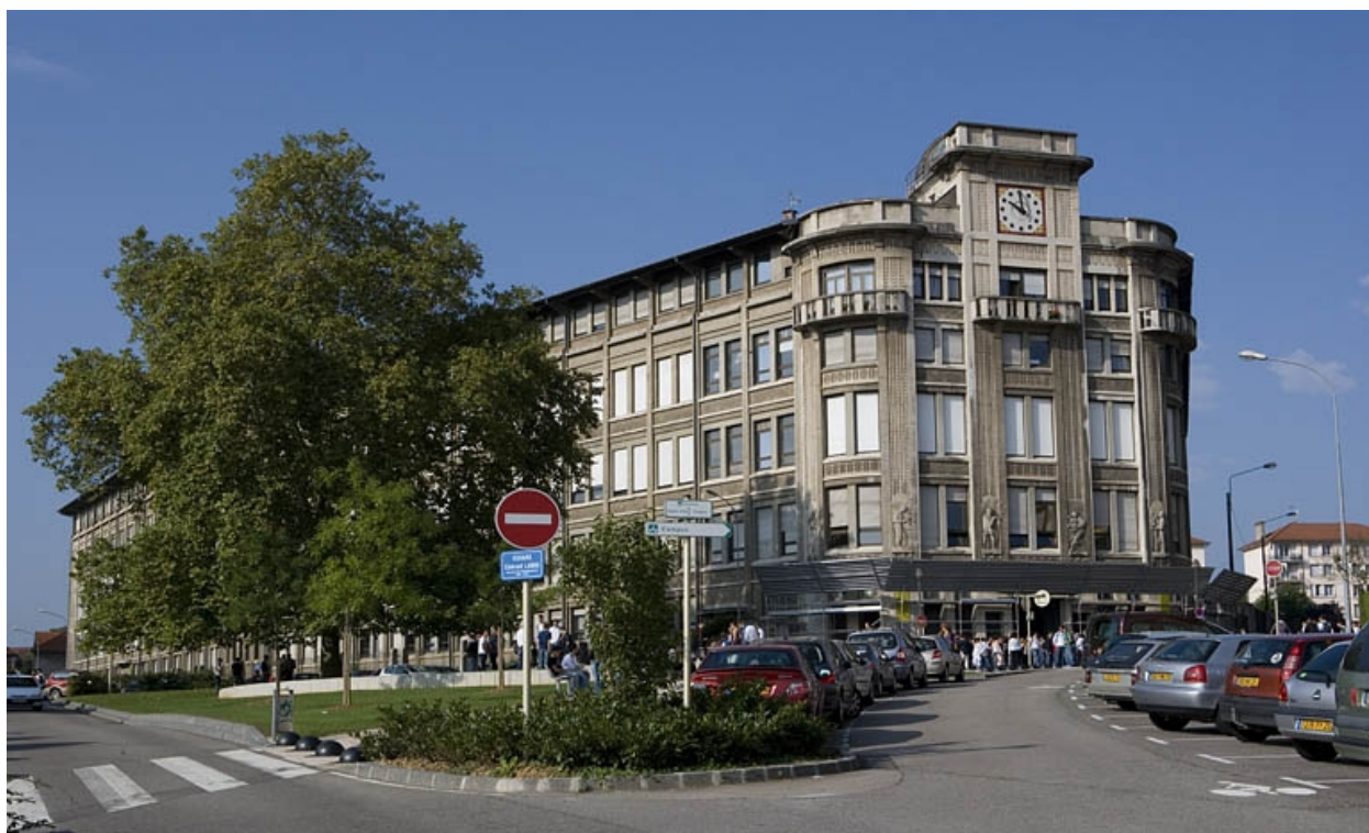
Vue d'ensemble de l'école, depuis l'est.
