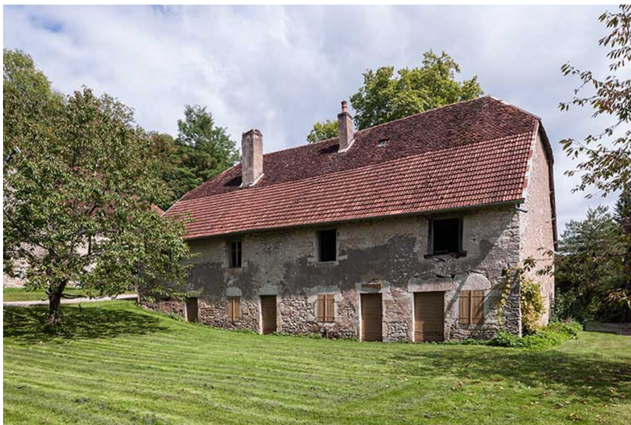
Logement d'ouvriers. Façade ouest de trois quarts.
