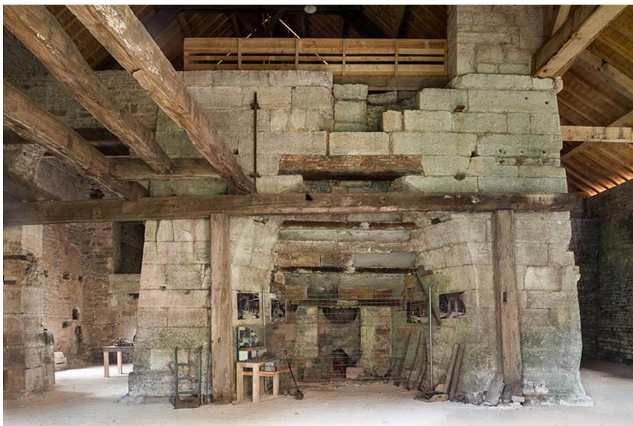
Haut fourneau, vu de face.
