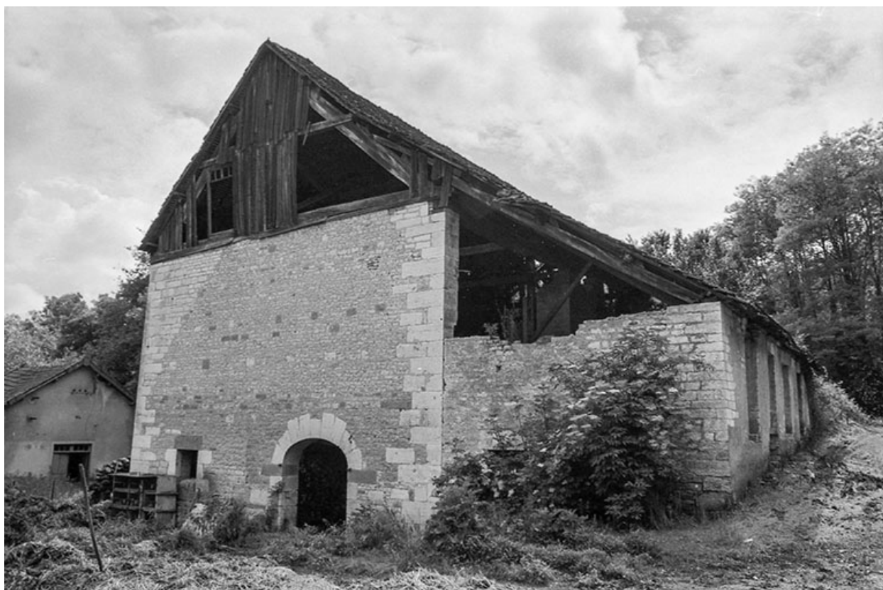
Bâtiment du haut fourneau en 1980.
