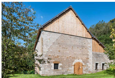
Pignon est du bâtiment du haut fourneau. Phot. Jérôme Mongreville IVR43_20142501205NUC4A
