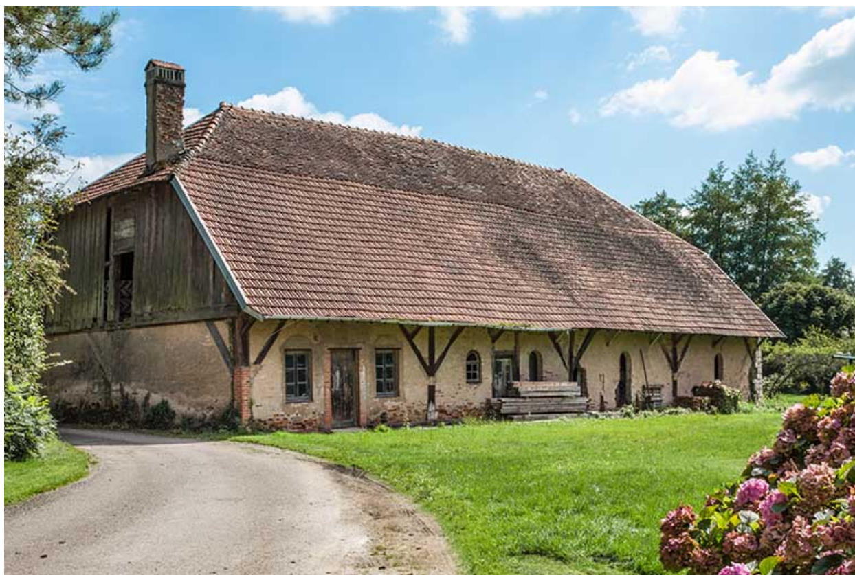
Magasin industriel depuis le nord-ouest.
