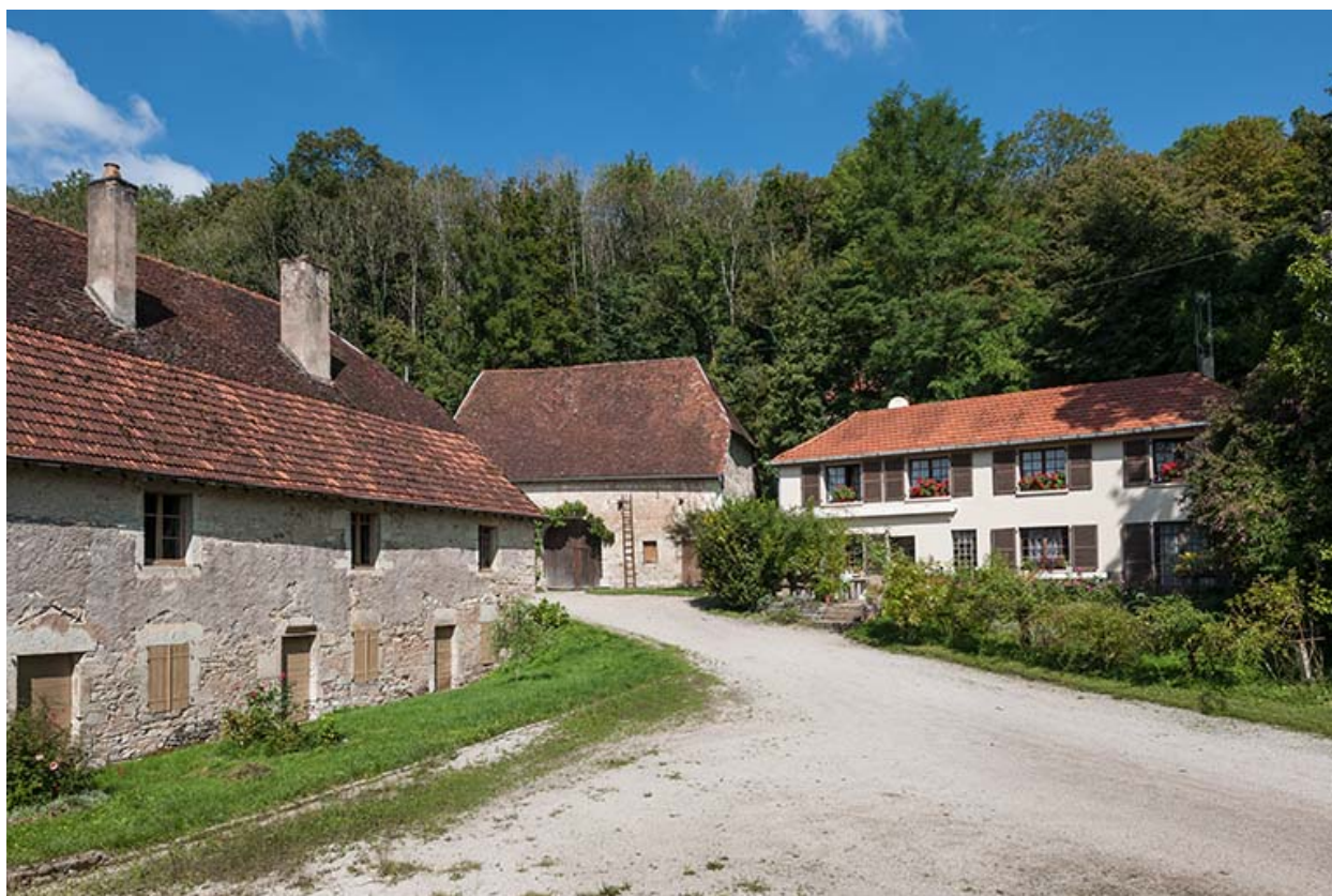
Logements depuis la cour.
