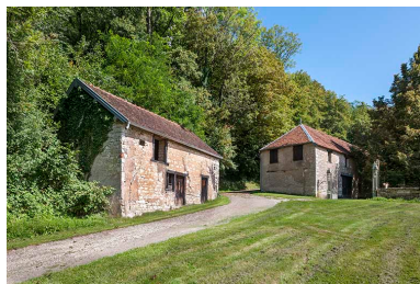
Ecuries vues de trois quarts. Phot. Jérôme Mongreville IVR43_20142501235NUC4A
