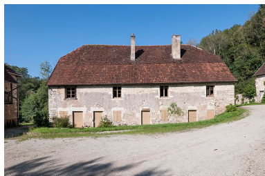
Logement d'ouvriers. Façade est. Phot. Jérôme Mongreville IVR43_20142501218NUC4A
