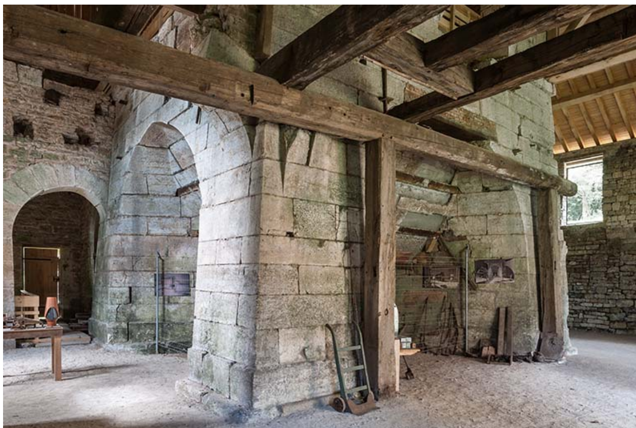
Haut fourneau. Vue rapprochée de trois quarts.
