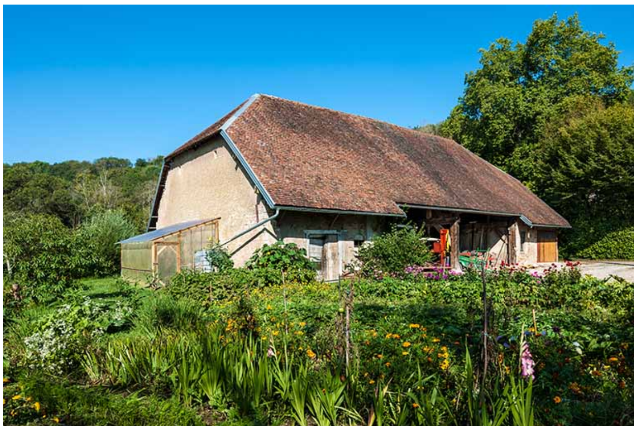
Vue du magasin industriel depuis le sud-est.
