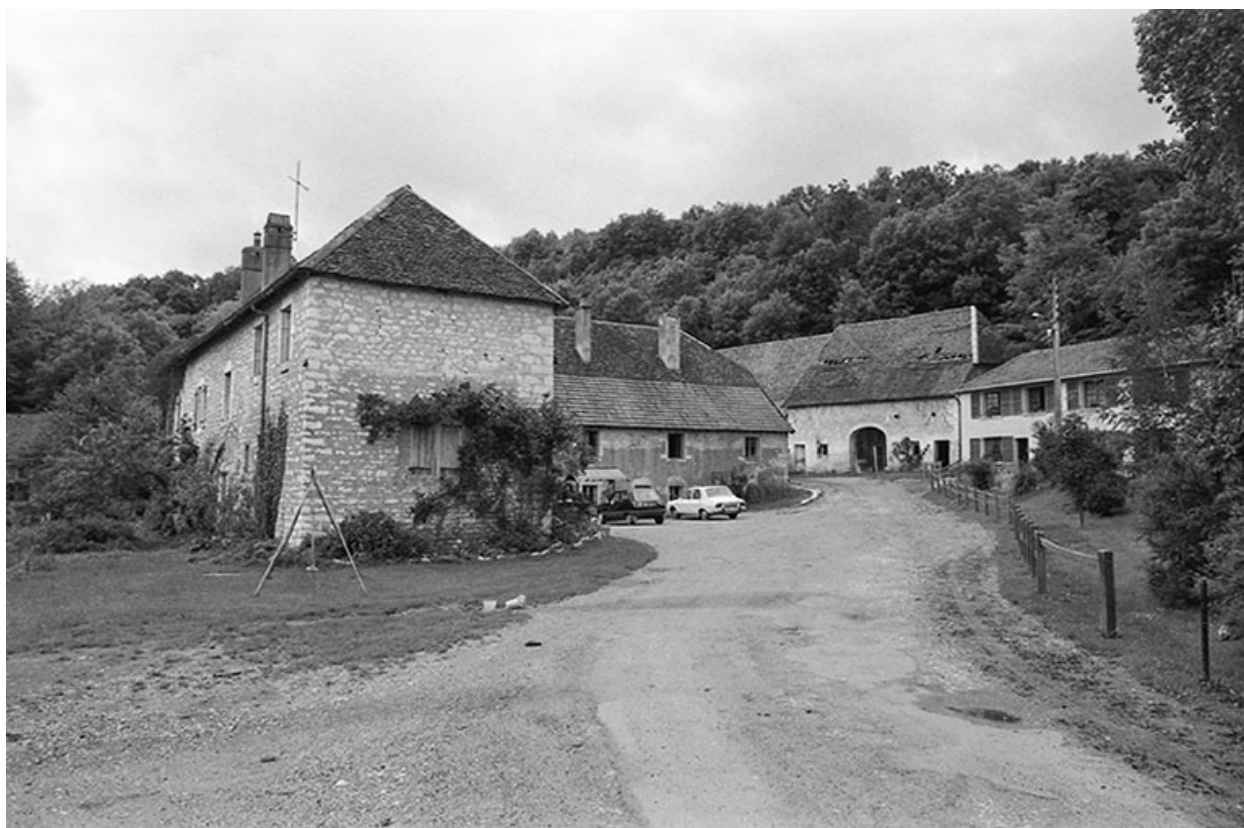
Vue d'ensemble depuis l'entrée en 1980.
