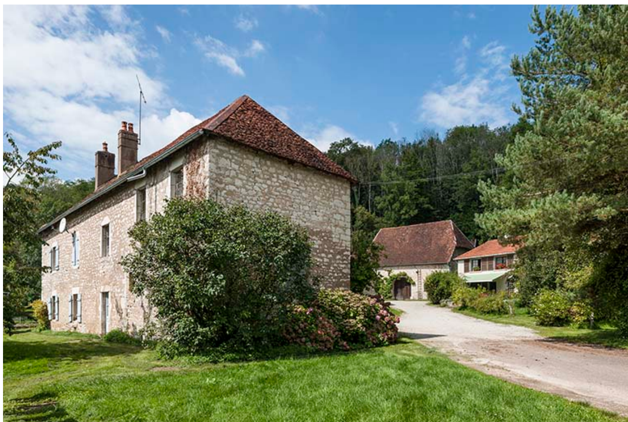
Vue d'ensemble depuis l'entrée du site.
