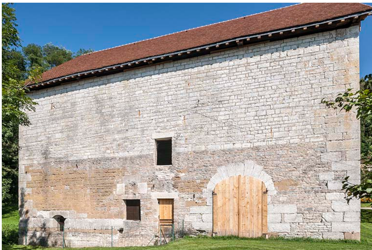
Façade sud du bâtiment du haut fourneau.
