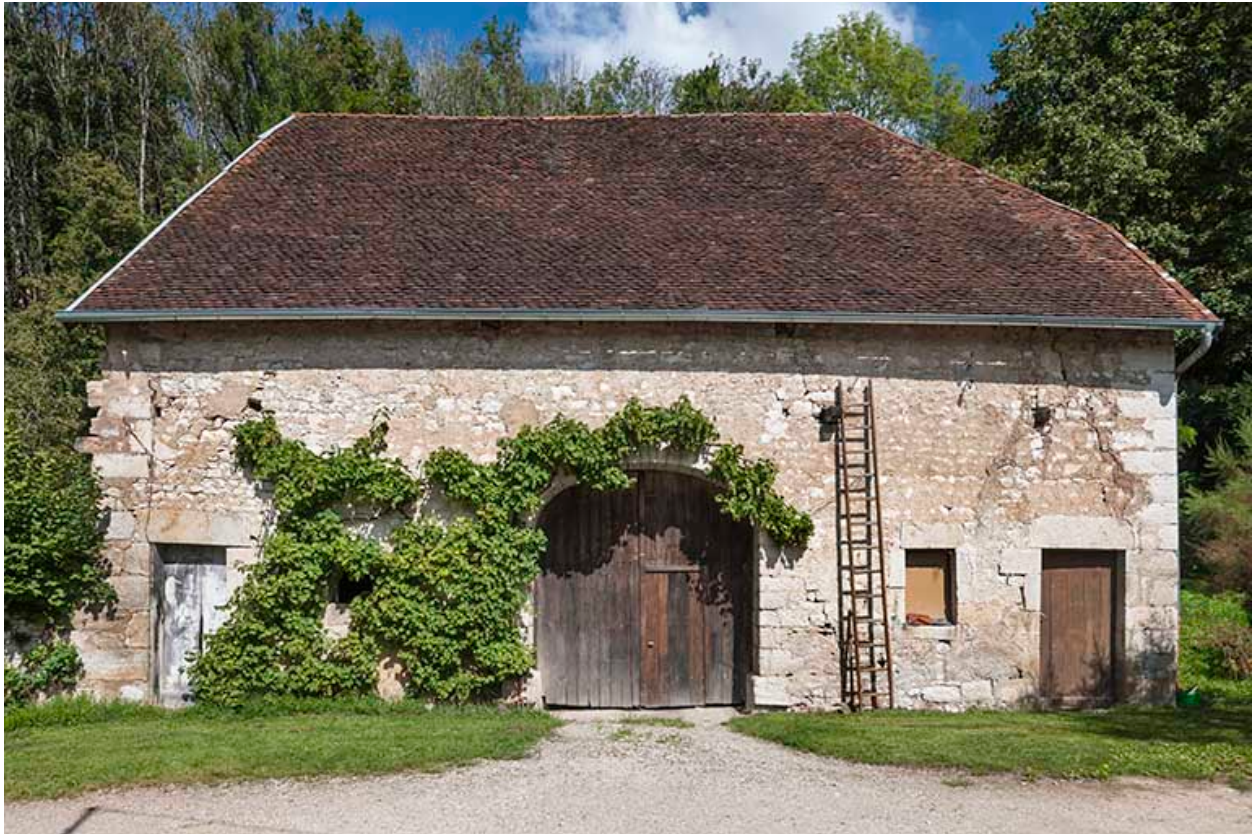
Bâtiment à vocation agricole.
