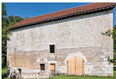
Façade sud du bâtiment du haut fourneau. Phot. Jérôme Mongreville IVR43_20142501206NUC4A
