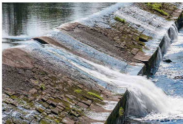
Vue de détail du barrage. Phot. Jérôme Mongreville IVR43_20142501234NUC4A
