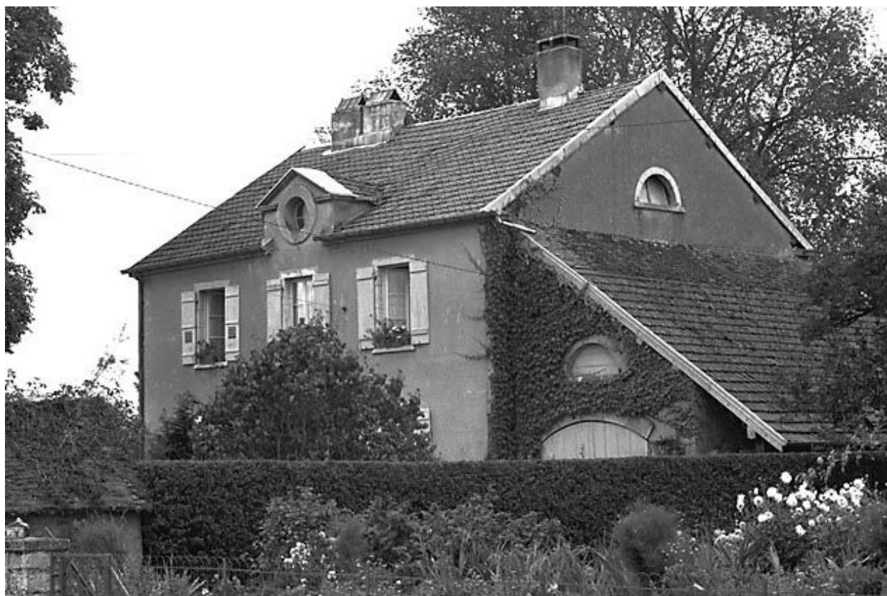
Maison située rue de l'Eglise.
