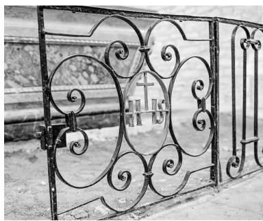
Détail : clôture du chœur. Phot. Yves Sancey IVR43_19777000131X
