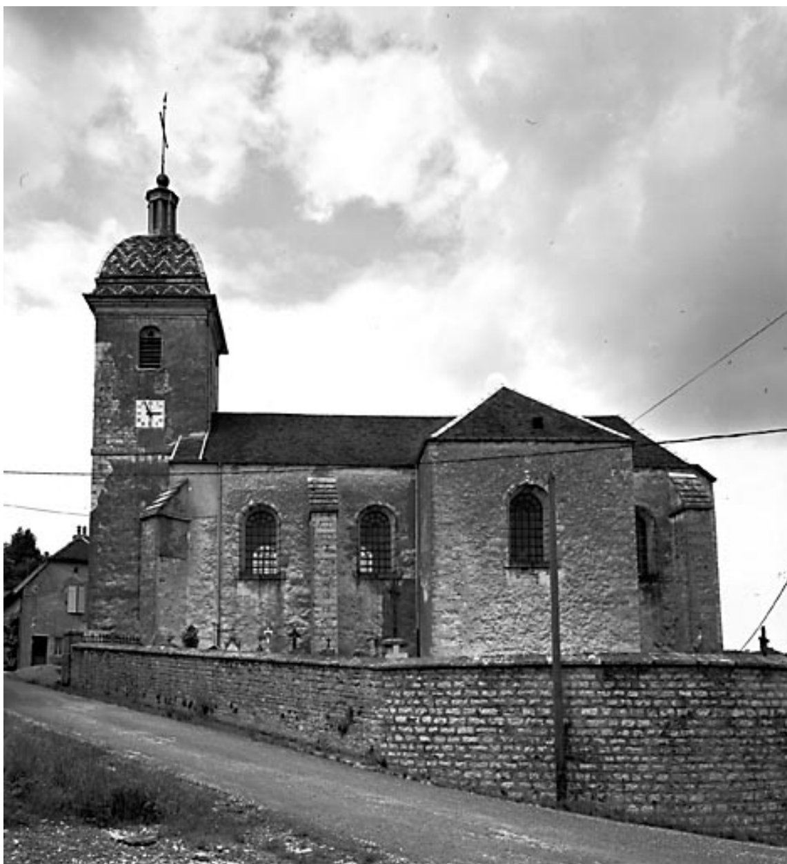
Façade latérale sud.
