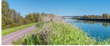
Vue d'ensemble, d'aval. Phot. Thierry Kuntz IVR26_20172100502NUC4A
