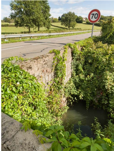
Vue de l'aqueduc. Phot. Pierre-Marie Barbe-Richaud IVR26_20177100306NUC2A
