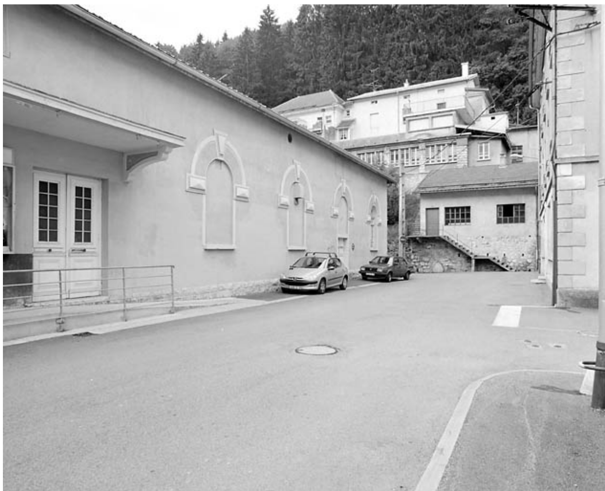
Elévation antérieure, de trois quarts gauche.
