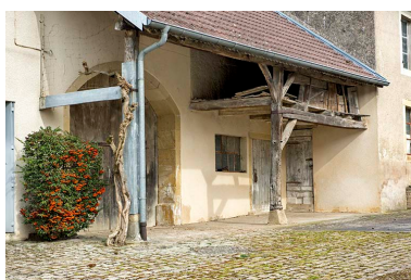
Auvent protégeant l'entrée de la grange. Phot. Sonia Dourlot IVR43_20167000547NUC4A
