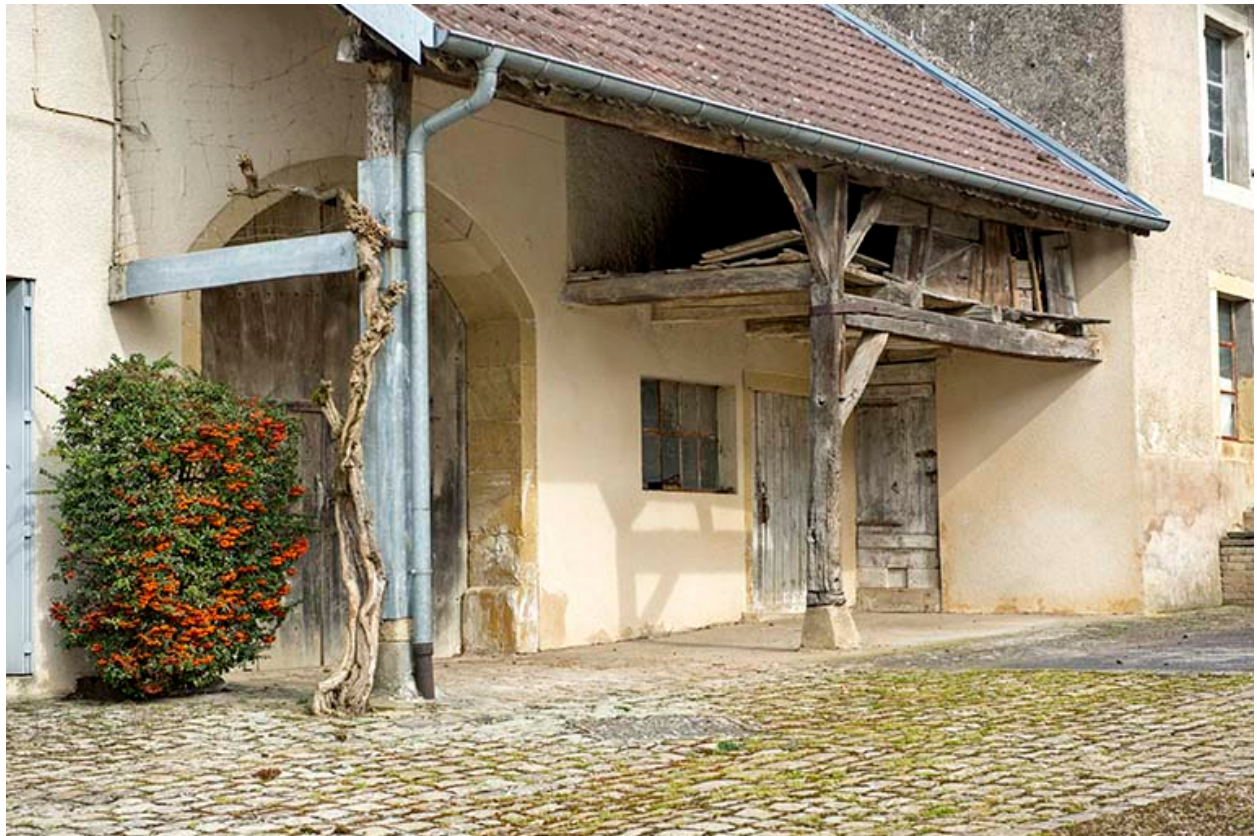
Auvent protégeant l'entrée de la grange.
