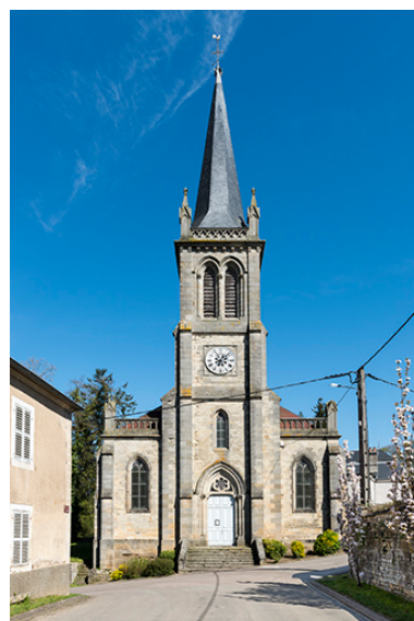
Rue de l'Eglise. Phot. Sonia Dourlot IVR43_20167000633NUC4A
