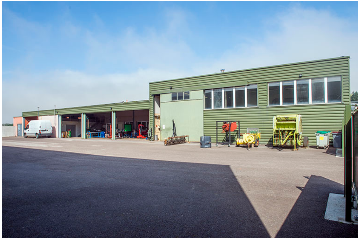
Façade antérieure sud de la halle d'agroéquipement.
