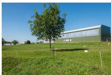
Façade sud de la halle du machinisme.
