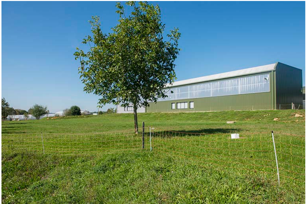
Façade sud de la halle du machinisme.
