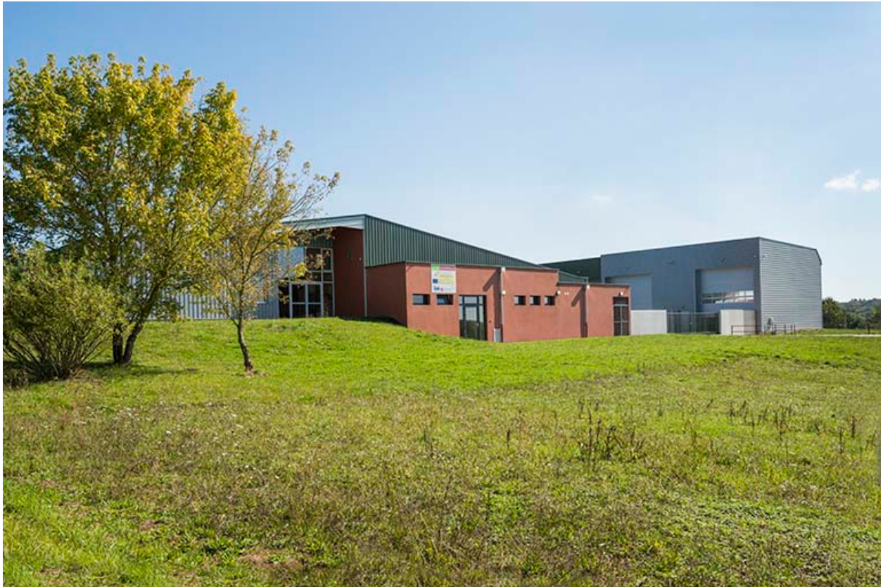
Les deux halles vues du nord-ouest.
