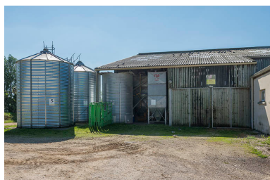
Angle nord-est du bâtiment de production laitière. Phot. Mary Ruffinoni IVR43_20137000708NUC4A
