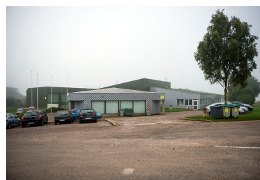
Façade nord-est du hall d'exposition.
