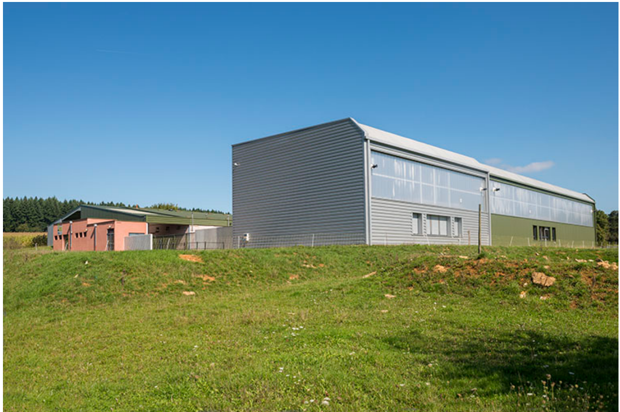
Les deux halles vues du sud-ouest.
