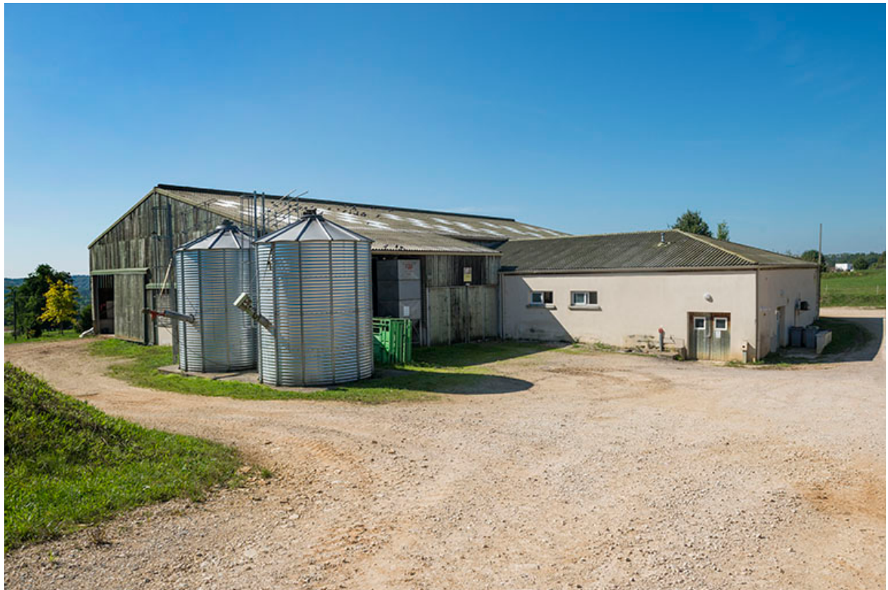
Façade est du bâtiment de production laitière.
