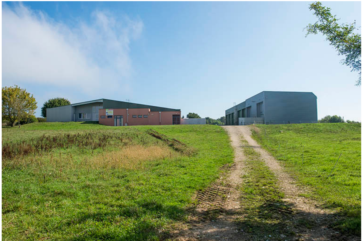
Vue d'ensemble, depuis les serres, à l'ouest.
