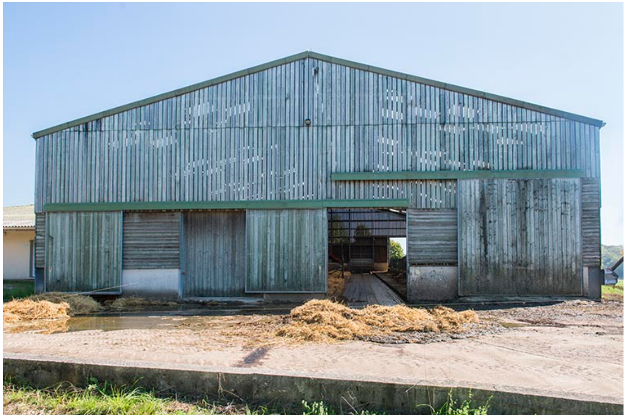
Entrée ouest du bâtiment de production laitière.
