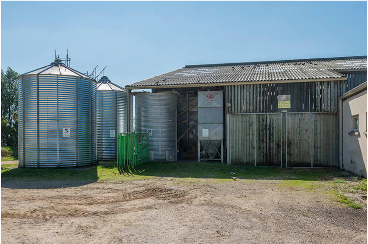
Angle nord-est du bâtiment de production laitière.
