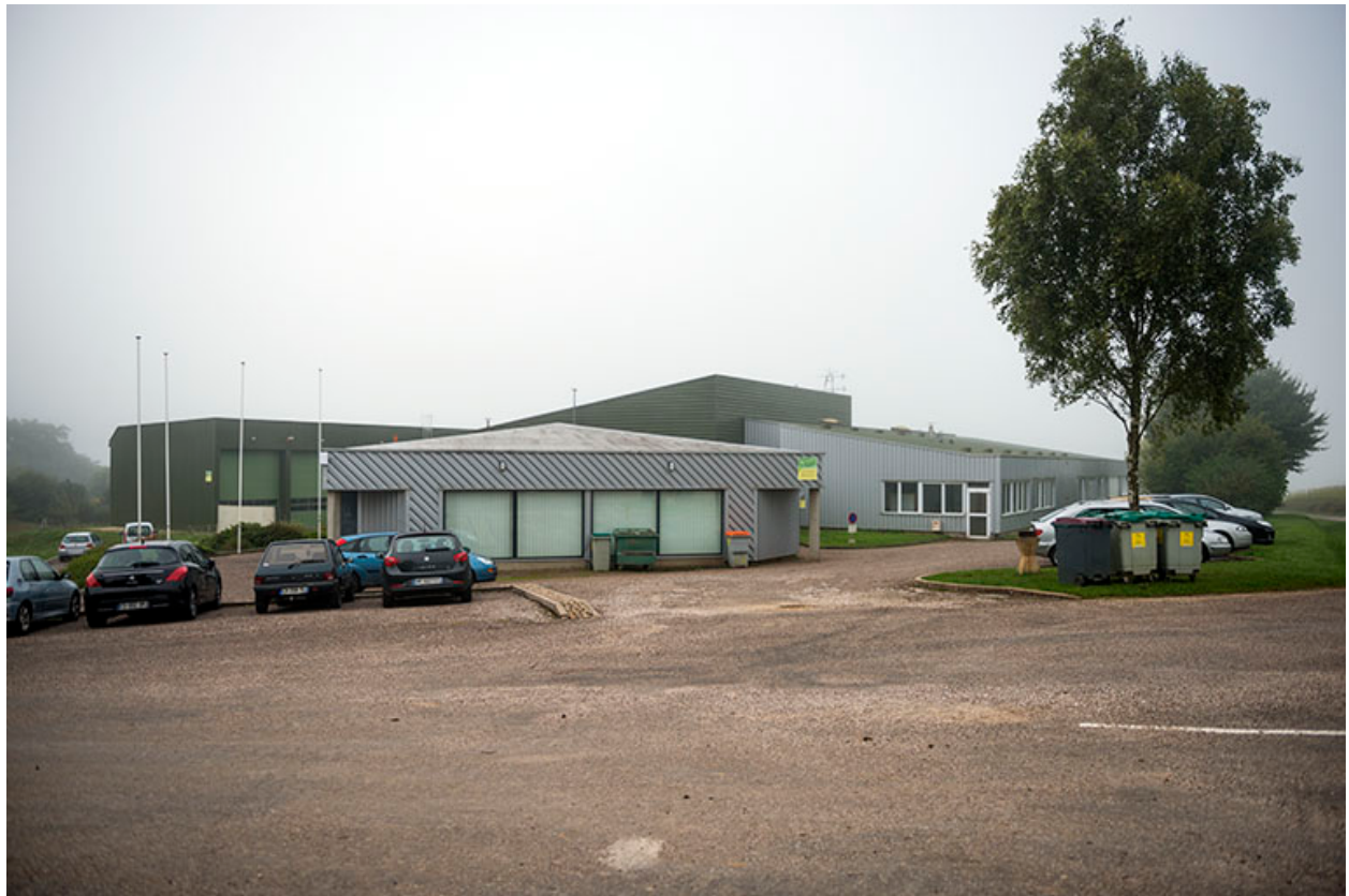
Façade nord-est du hall d'exposition.
