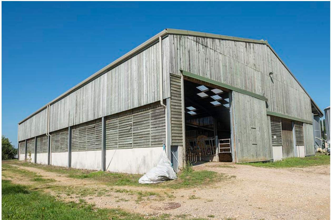
Angle sud-est du bâtiment de production laitière.
