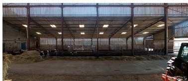
Dans le bâtiment de production laitière. Phot. Mary Ruffinoni IVR43_20137000712NUC4A
