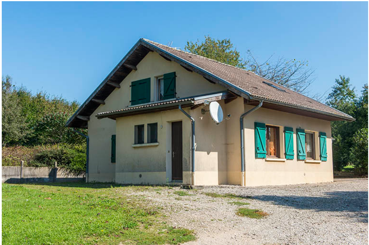
Angle sud-ouest du logement.
