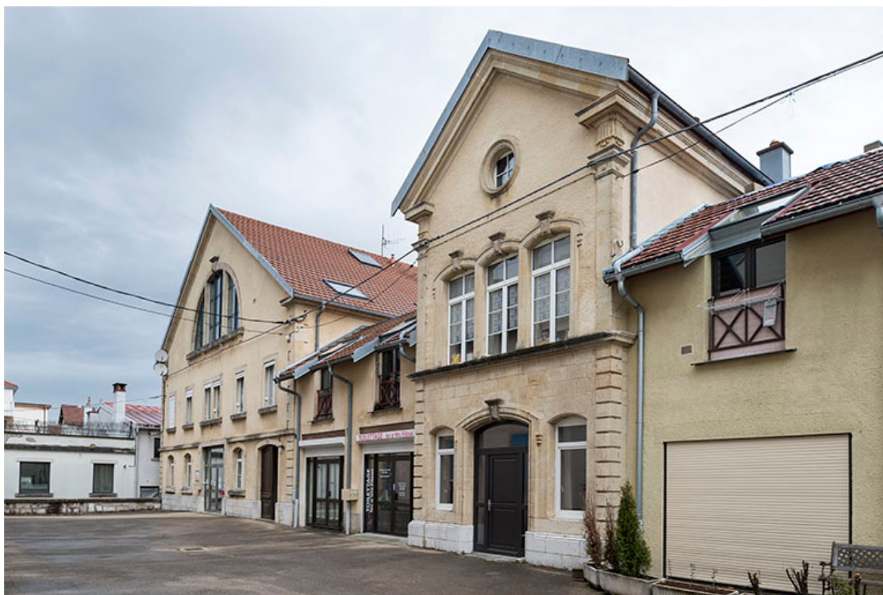
Façade des chais et entrepôts. Vue partielle.
