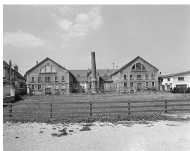
Façade postérieure des chais en 1980. Phot. Yves Sancey IVR43_19802500169X
