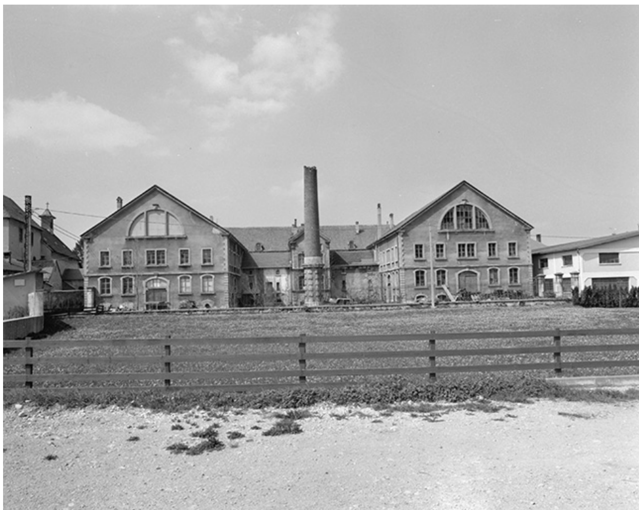
Façade postérieure des chais en 1980.
