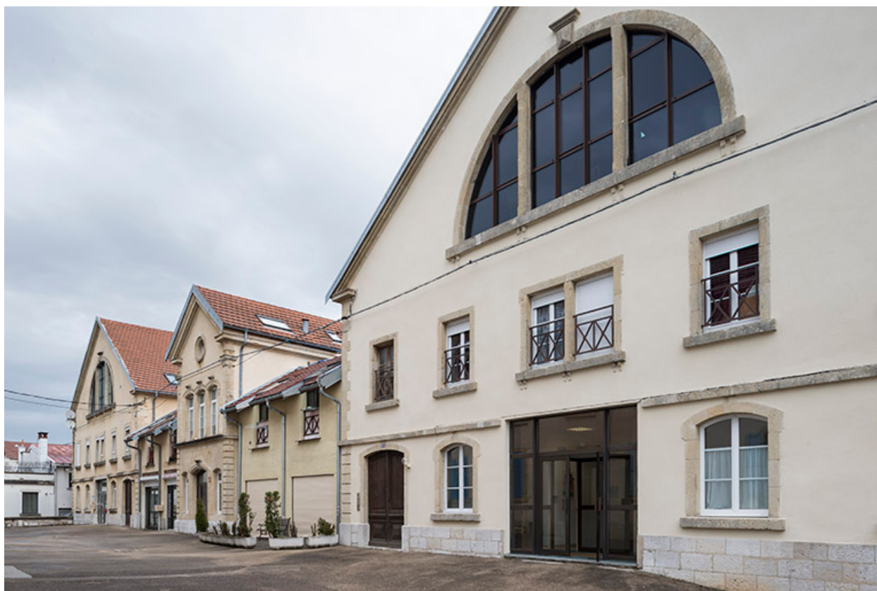
Façade ouest des chais et entrepôts.
