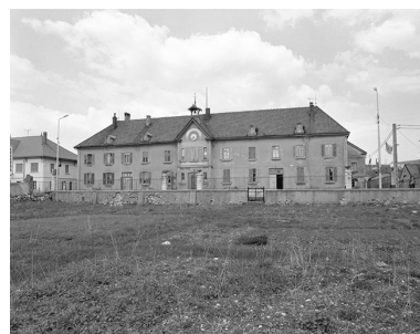
Façade antérieure en 1980. Phot. Yves Sancey IVR43_19802500168X
