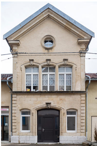
Façade ouest du pavillon central. Phot. Jérôme Mongreville IVR43_20162501581NUC4A
