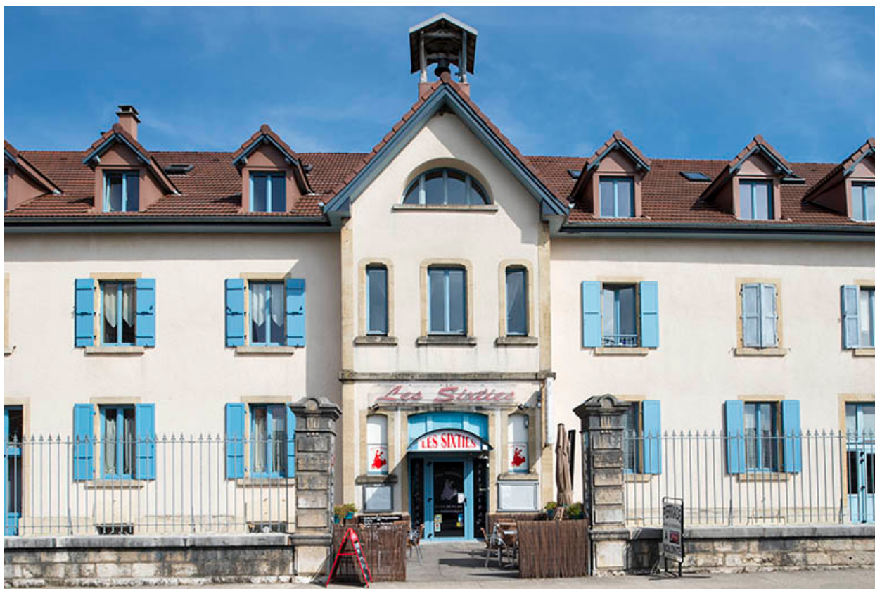
Partie centrale du bâtiment de la distillerie.
