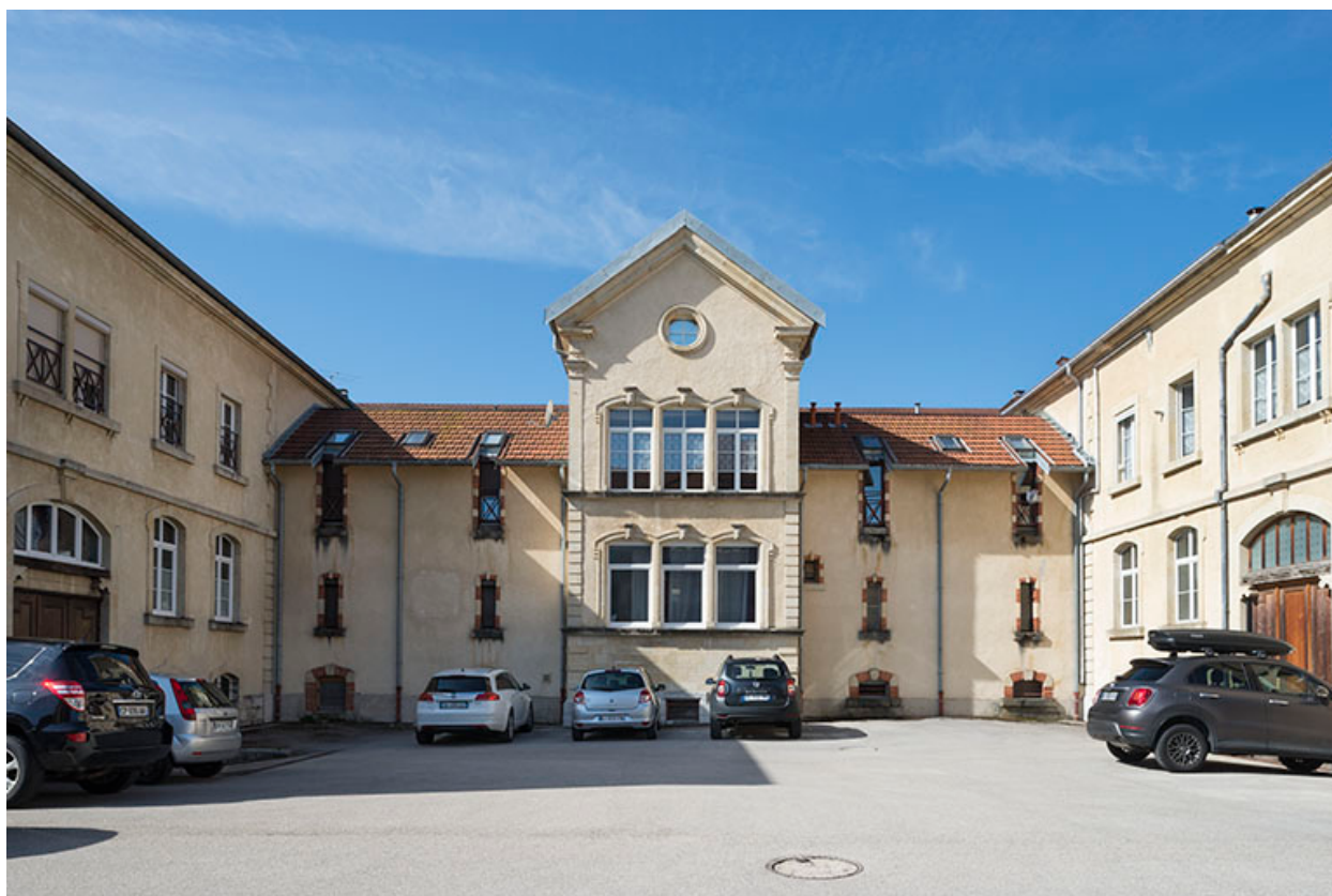
Vue axiale depuis la cour nord.
