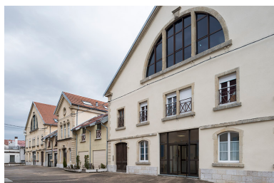
Façade ouest des chais et entrepôts. Phot. Jérôme Mongreville IVR43_20162501580NUC4A
