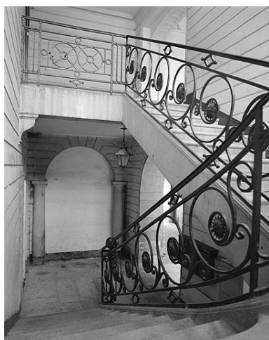
Vue de l'escalier depuis le repos. Phot. Yves Sancey IVR43_19833900321X
