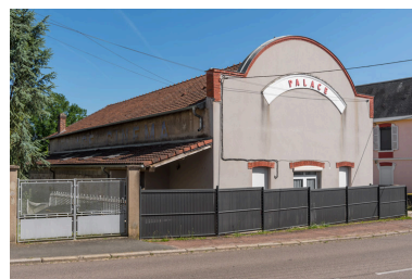
Vue d'ensemble, de trois quarts gauche. Phot. Pierre-Marie Barbe-Richaud IVR26_20257100889NUC4A
