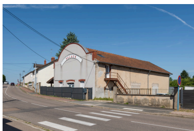
Vue d'ensemble, de trois quarts droite. Phot. Pierre-Marie Barbe-Richaud IVR26_20257100886NUC4A
