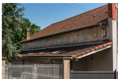
Inscription "Palace Cinéma" sur la façade latérale gauche. Phot. Pierre-Marie Barbe-Richaud IVR26_20257100890NUC4A
