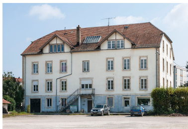
Façade postérieure. Phot. Jérôme Mongreville IVR43_20142501390NUC4A
