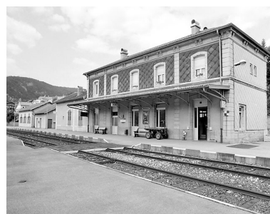
Bâtiment des voyageurs : façade postérieure, de trois quarts droite. Phot. Yves Sancey IVR43_20033900952X
