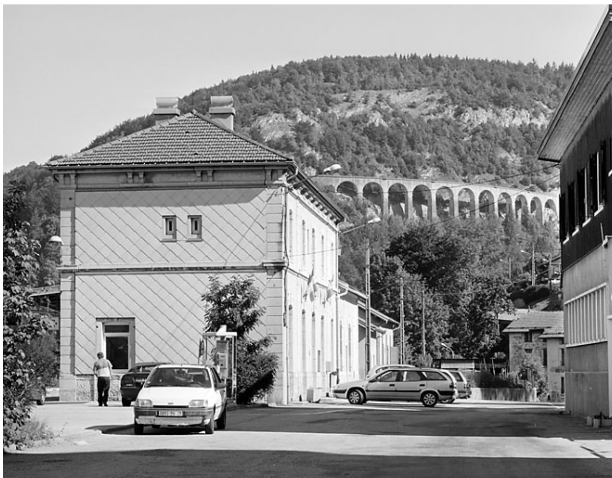
Bâtiment des voyageurs : façade latérale gauche.
