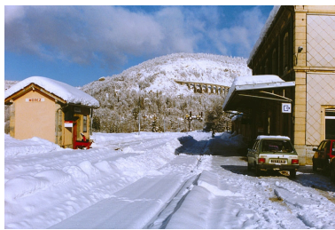
[La gare durant l'hiver 2000, côté bâtiment des voyageurs]. Phot. IVR43_20083900751NUC2A
