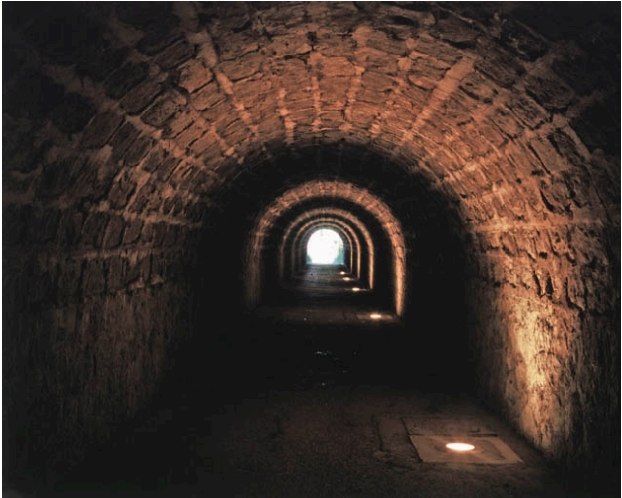
Passage souterrain (sous les voies) : intérieur.
