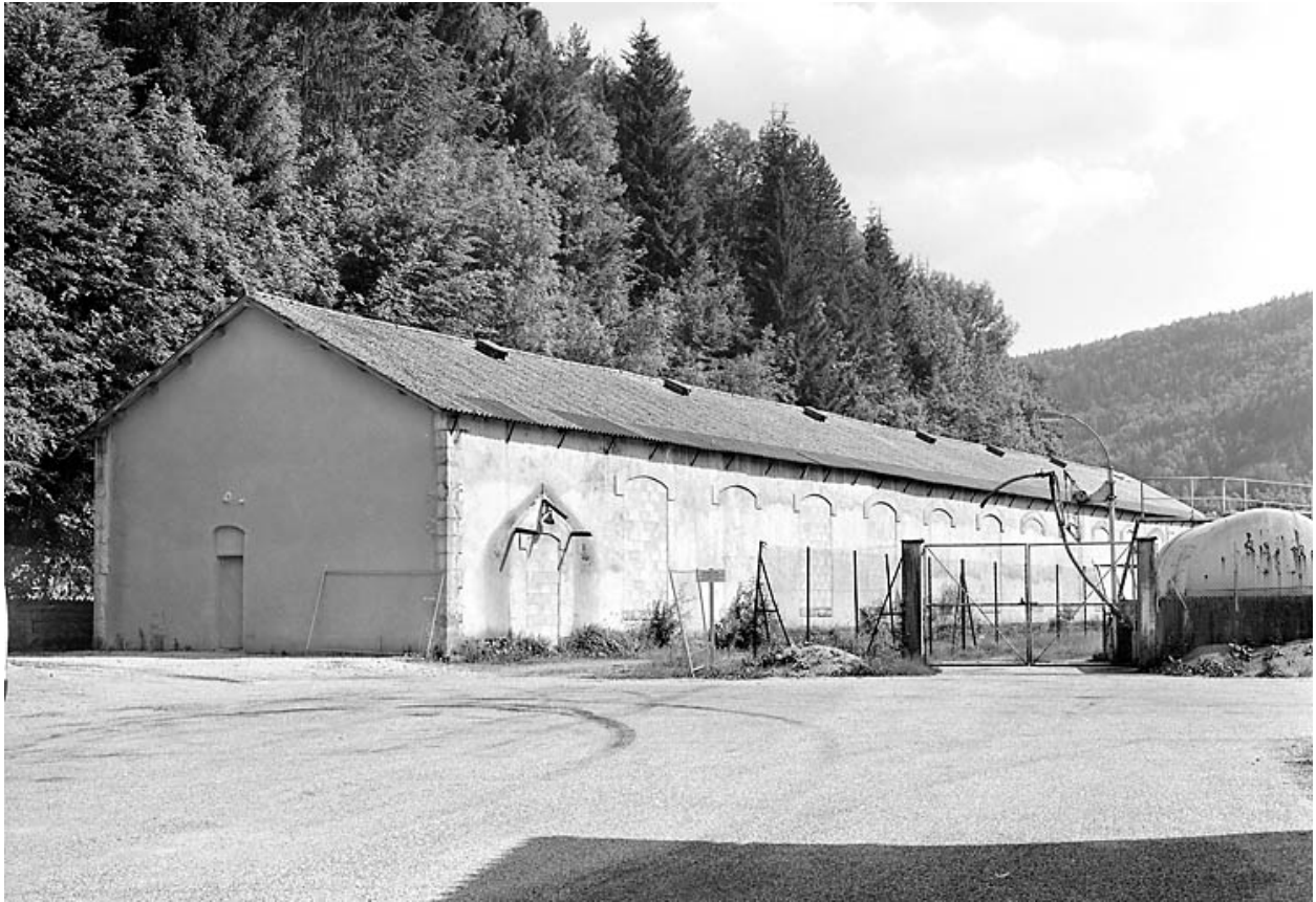
Remise ferroviaire, depuis le nord.
