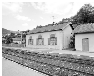
Logement : façade postérieure, de trois quarts droite. Ce logement était autrefois destiné au chef de réserve, responsable du dépôt (traction).
