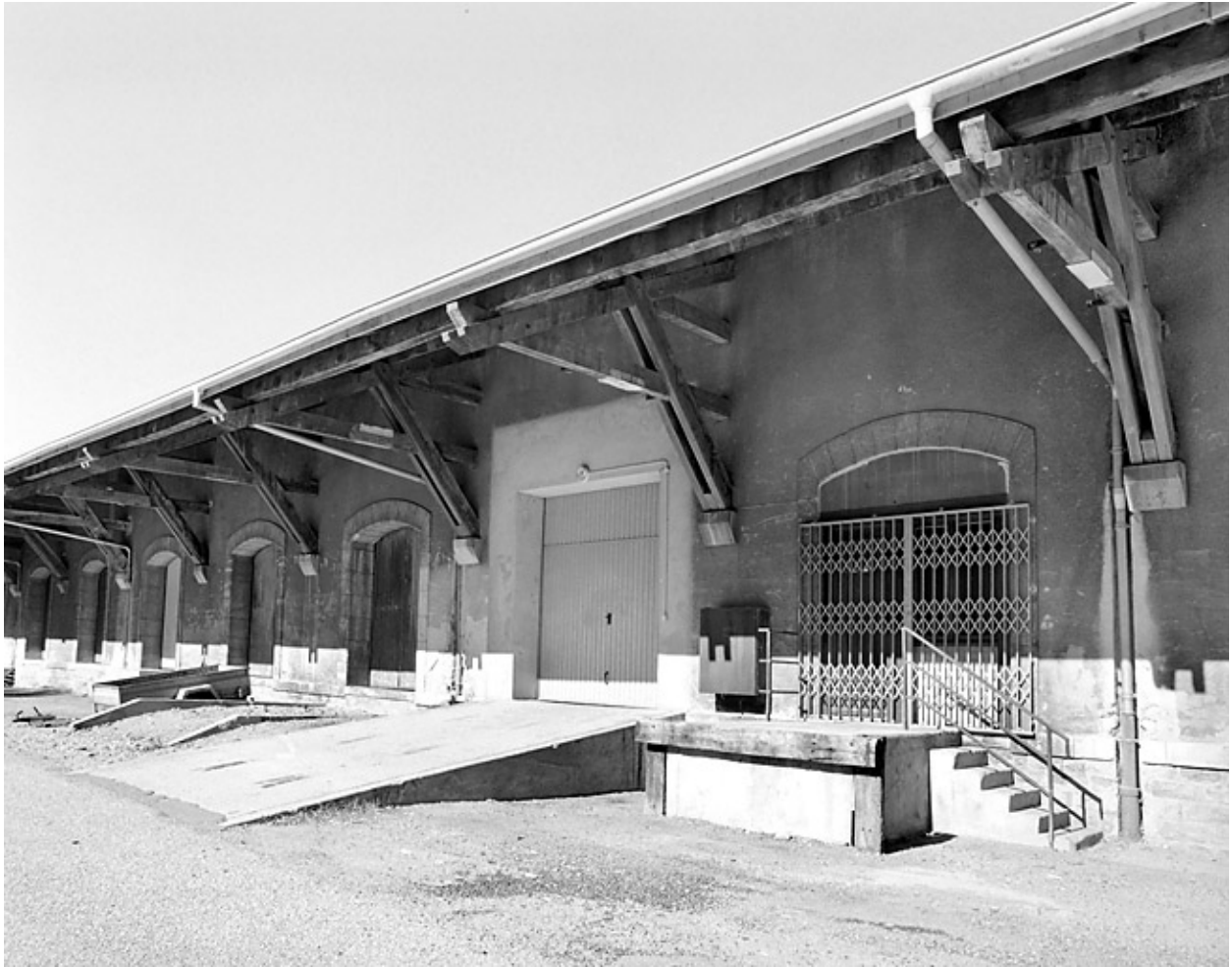
Entrepôt : façade antérieure.
