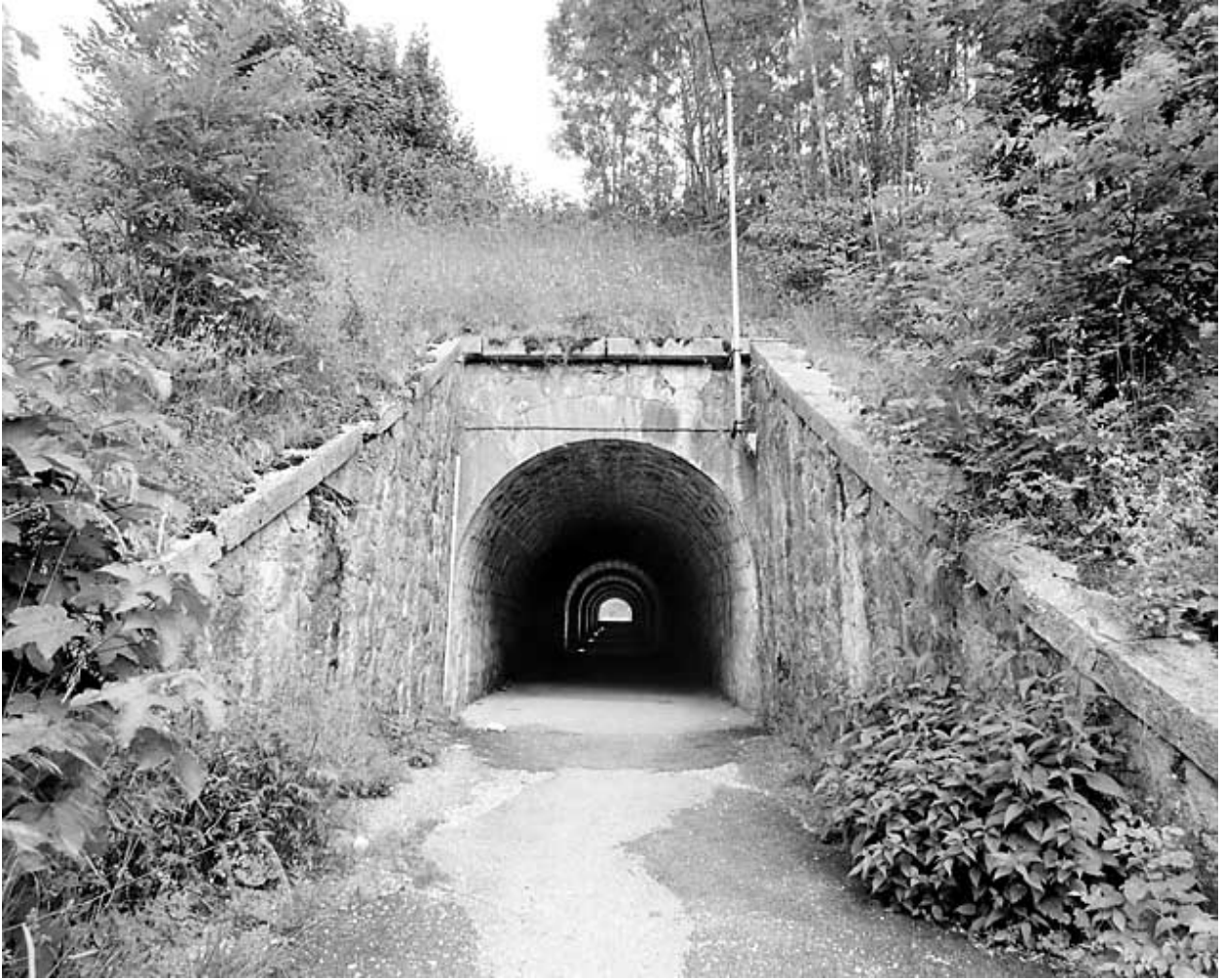
Passage souterrain (sous les voies) : tête côté centre-ville (ouest).
