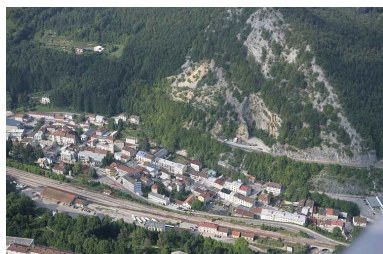
Vue aérienne, depuis l'est. Phot. Jean-Pierre Bévalot IVR43_20053900971NUCA
