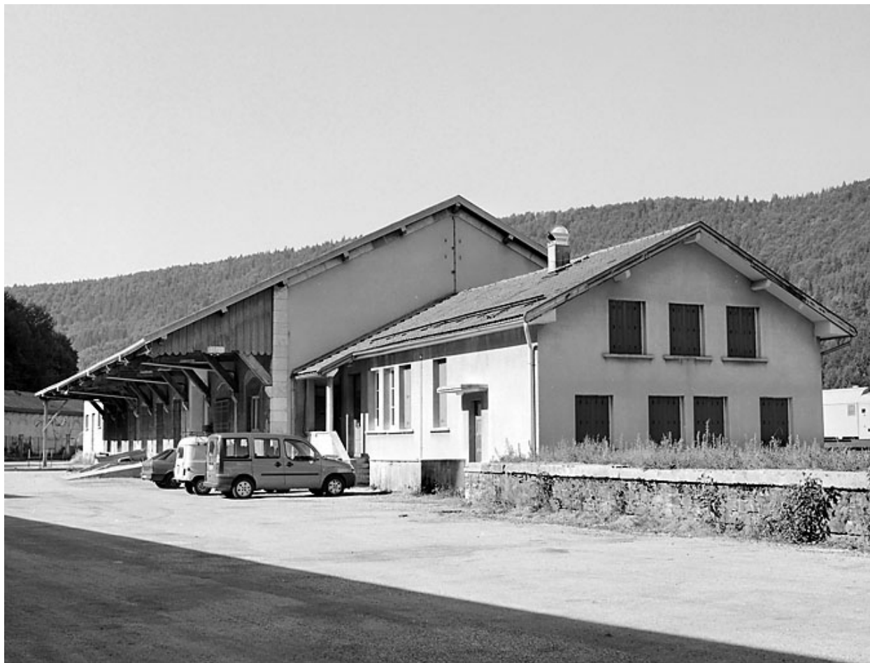
Entrepôt et ancien foyer des roulants, depuis le nord-est.
