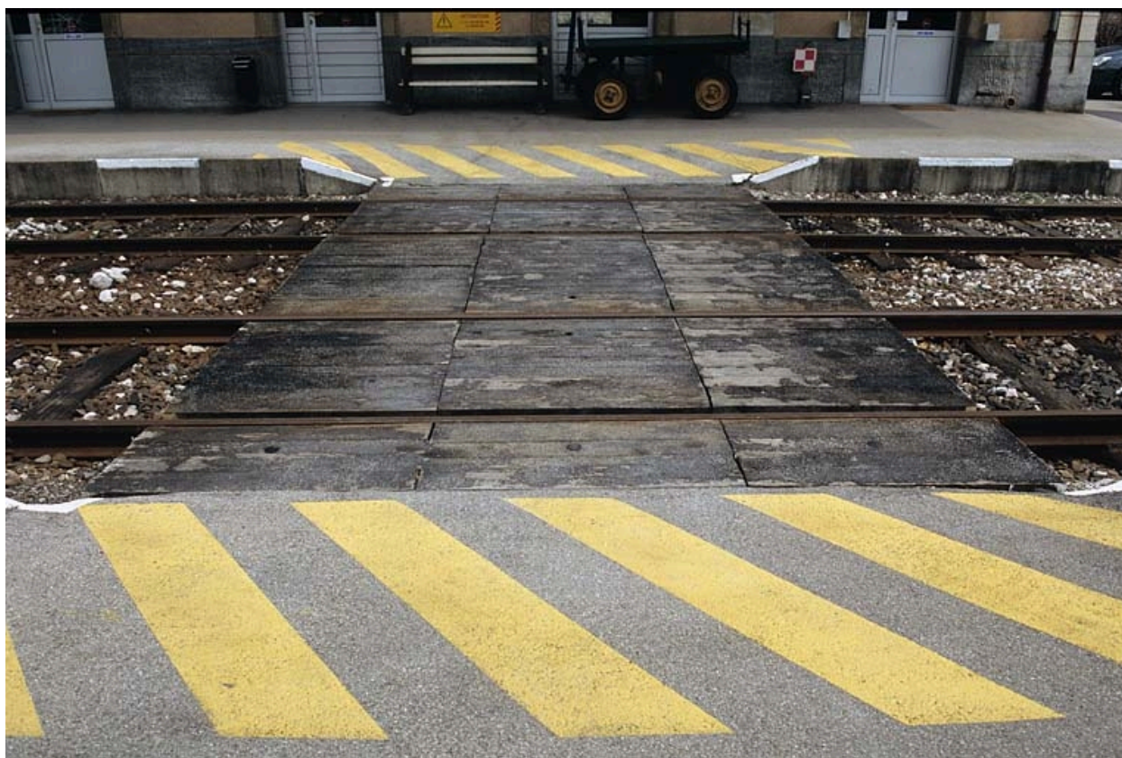
Passage planchéié reliant les deux quais, près du bâtiment des voyageurs.
