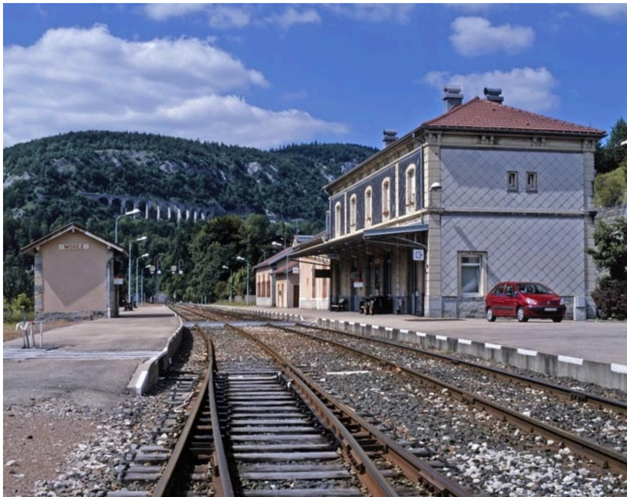
Bâtiment et abri de voyageurs, depuis le sud.
