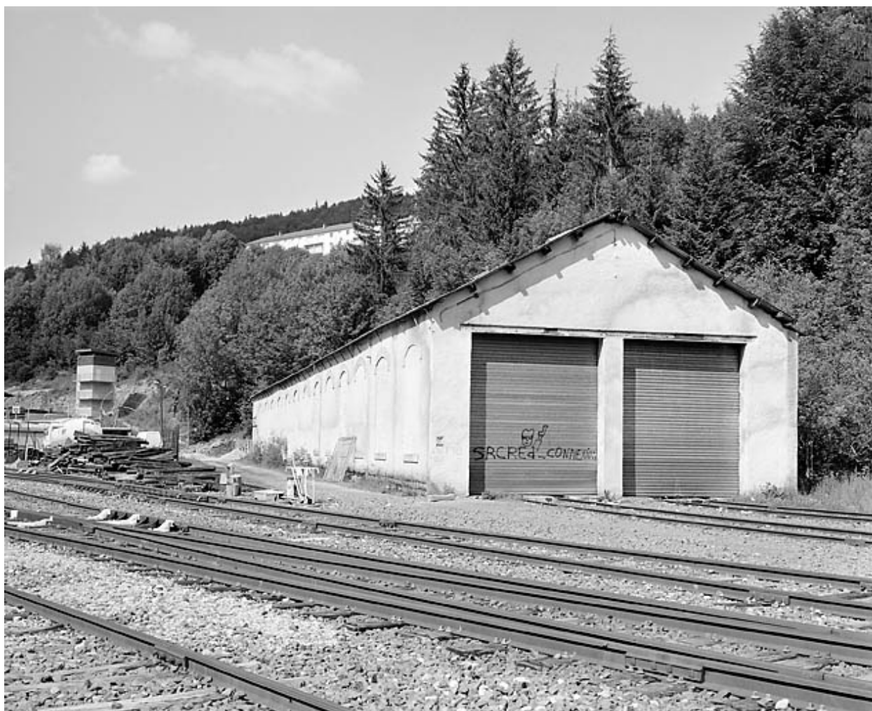
Remise ferroviaire, depuis le sud.
