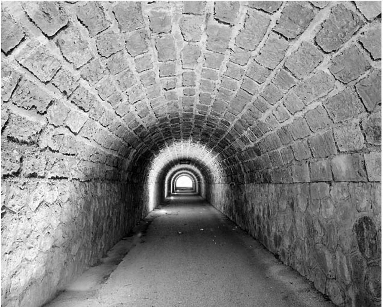
Passage souterrain (sous les voies) : intérieur.
