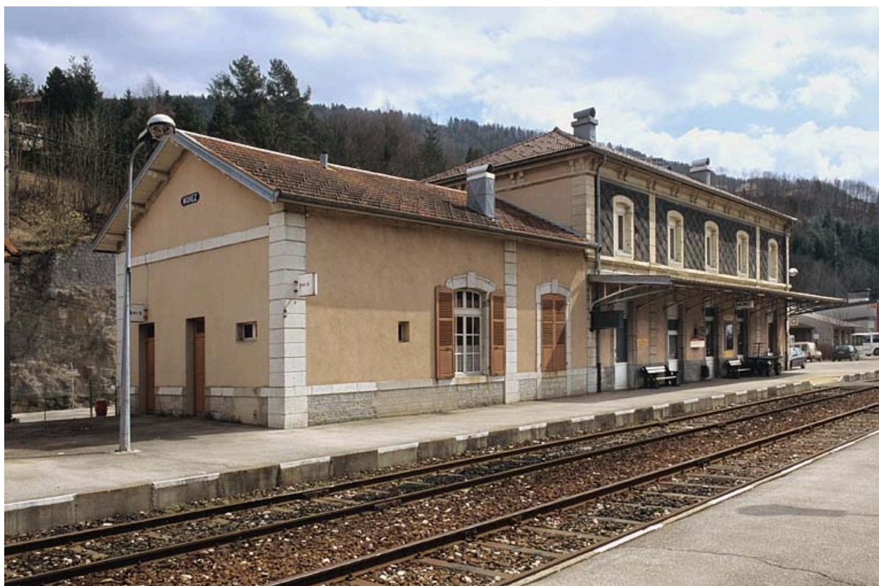
Bâtiment des voyageurs : façade postérieure, de trois quarts gauche.
