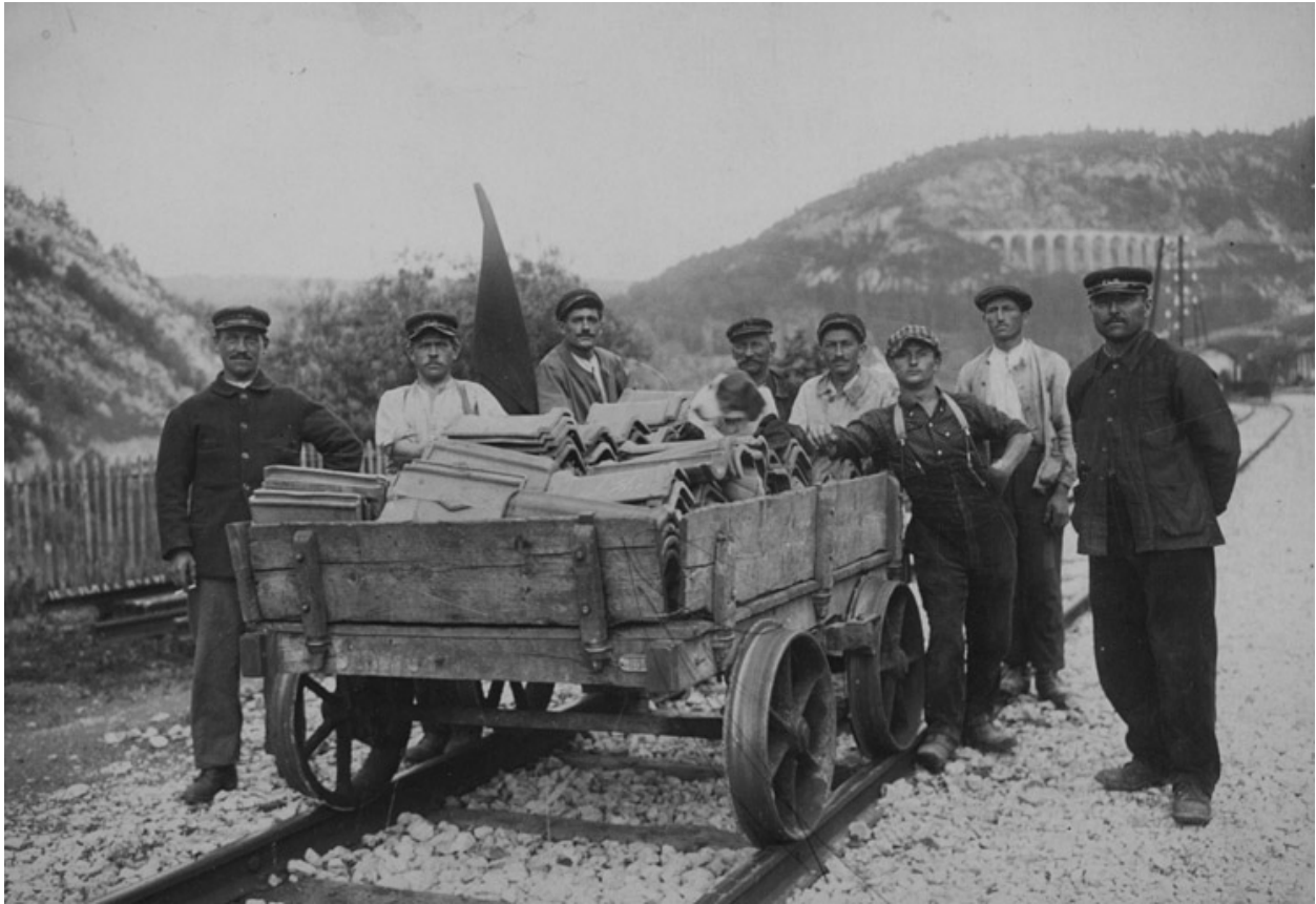
L'équipe d'entretien de la voie, sur la voie de service n° 6 de Morez, 1935.
