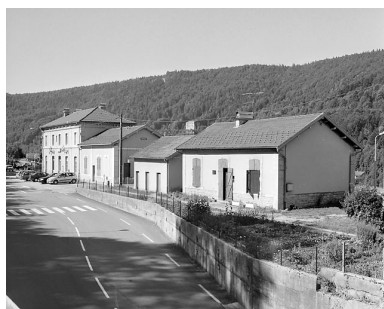
Bâtiment des voyageurs et logement, depuis le nord-est. Phot. Yves Sancey IVR43_20033900946X
