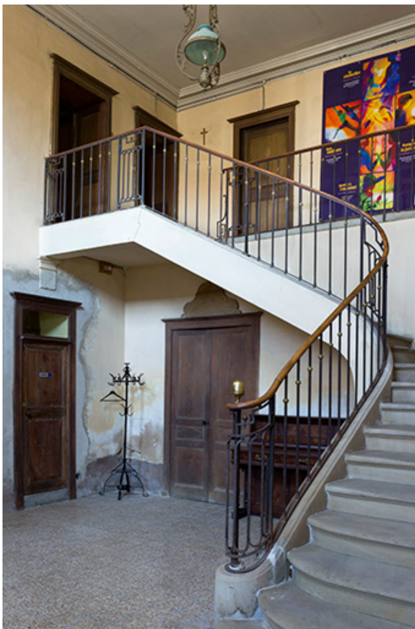
Vue d'ensemble de l'escalier de distribution intérieur.
