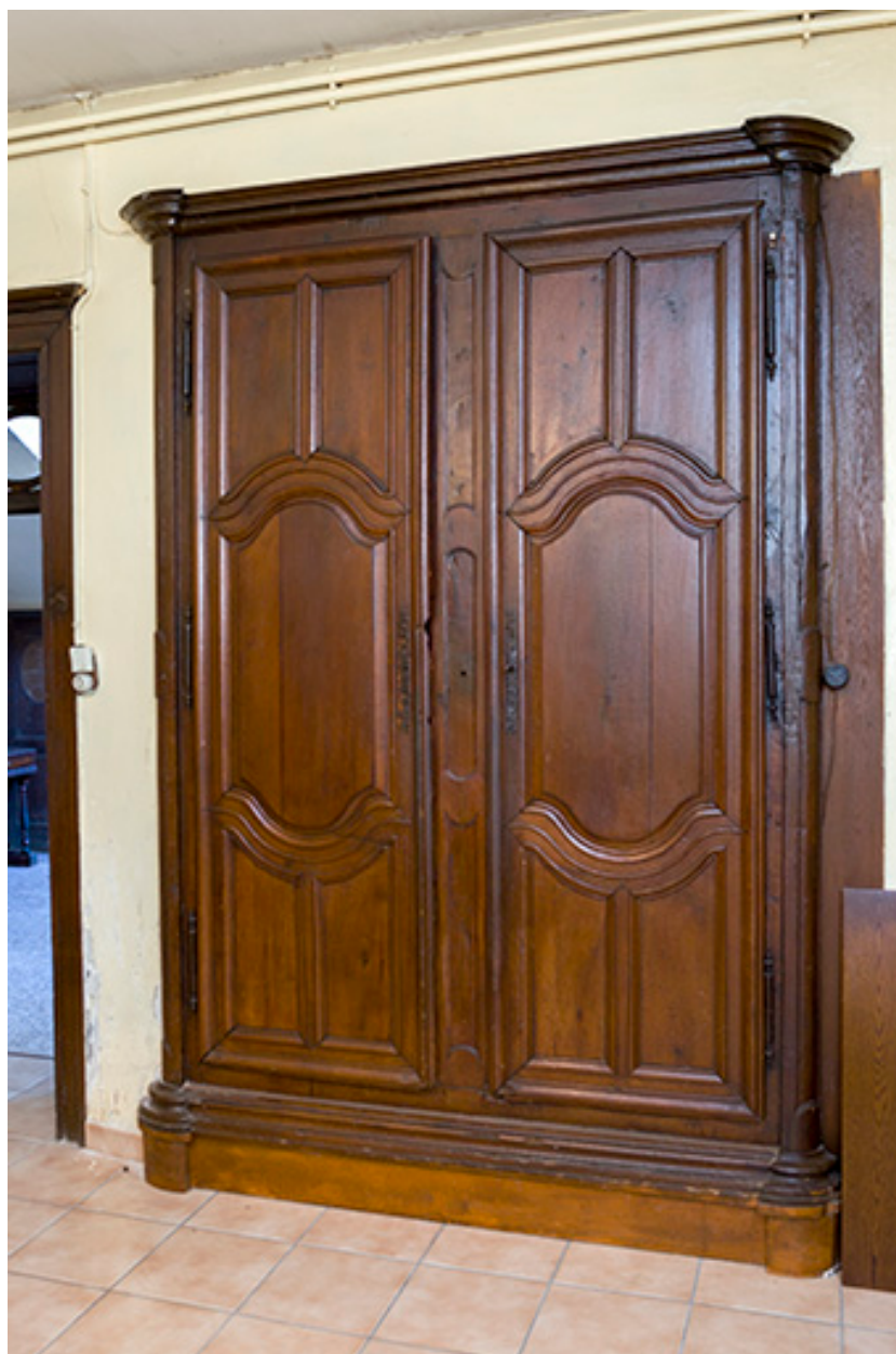
Portes du placard de la cuisine.
