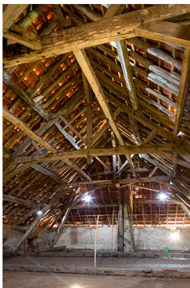
Vue intérieure de la charpente de toit. Phot. Sonia Dourlot IVR43_20157001446NUC2A
