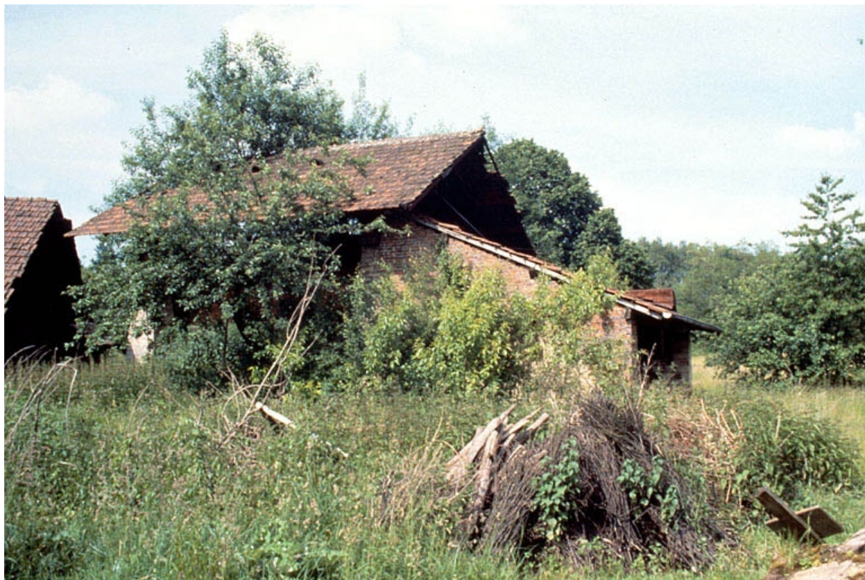
Bâtiment du four (C), depuis le sud.
