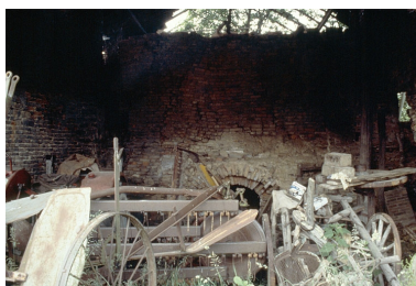
Bâtiment du four : foyer au centre, cendrier à droite. Phot. Laurent Poupard IVR43_19883900489ZA
