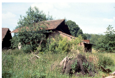
Bâtiment du four (C), depuis le sud. Phot. Laurent Poupard IVR43_19883900488ZA
