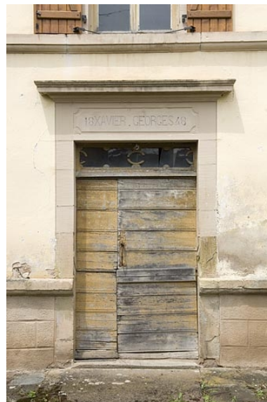
Porte du logement. Phot. Jérôme Mongreville IVR43_20097000365NUC2A
