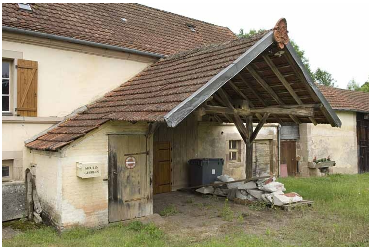
Auvent sur la façade antérieure.
