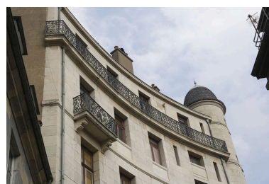
Détail du balcon filant sur la façade donnant rue Lacoré. Phot. Yves Sancey IVR43_20092500236NUC2A
