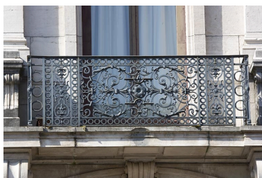
Détail d'un balcon ponctuel. Phot. Yves Sancey IVR43_20092500245NUC2A
