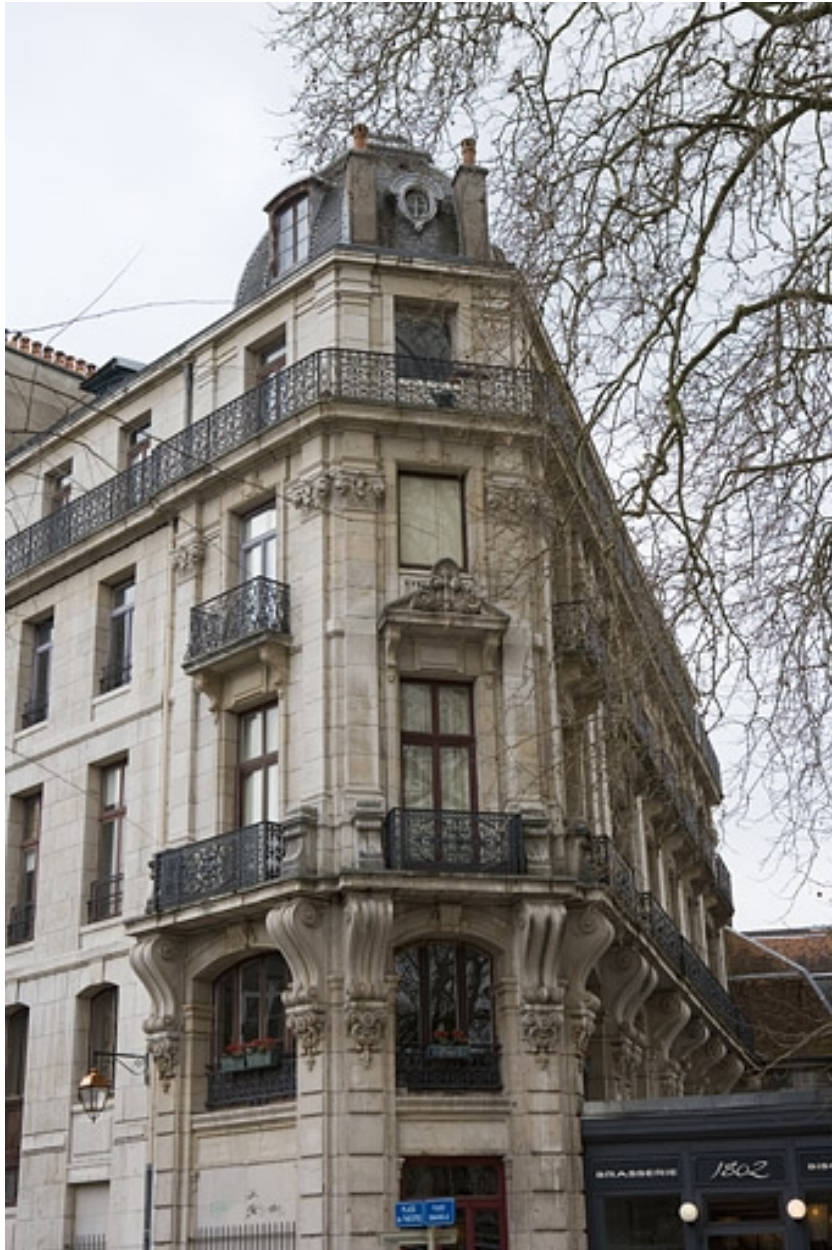
Vue d'ensemble de l'angle de l'immeuble.
