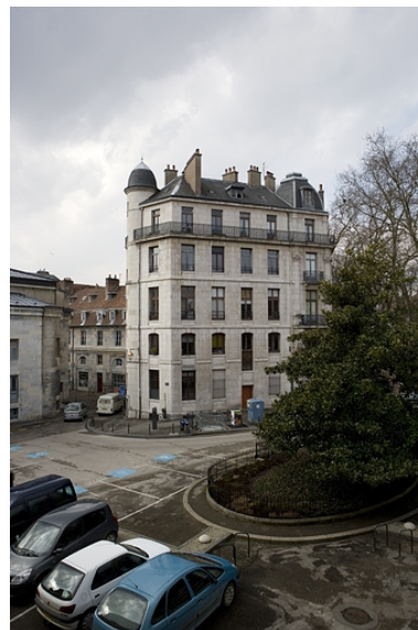
Vue d'ensemble de l'immeuble depuis la place Granvelle. Phot. Yves Sancey IVR43_20092500237NUC2A
