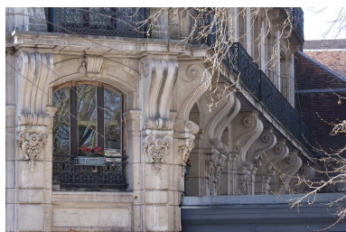
Détail des consoles soutenant le balcon filant. Phot. Yves Sancey IVR43_20092500244NUC2A
