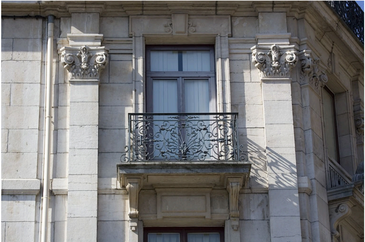
Détail d'un balcon ponctuel entre deux pilastres.
