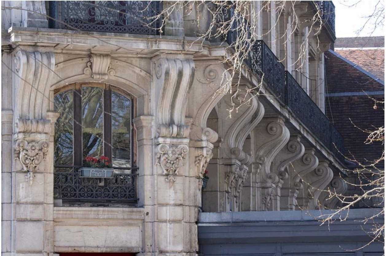
Détail des consoles soutenant le balcon filant.
