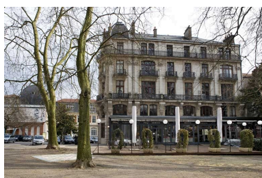
Vue d'ensemble de la façade sur la place Granvelle. Phot. Yves Sancey IVR43_20092500241NUC2A
