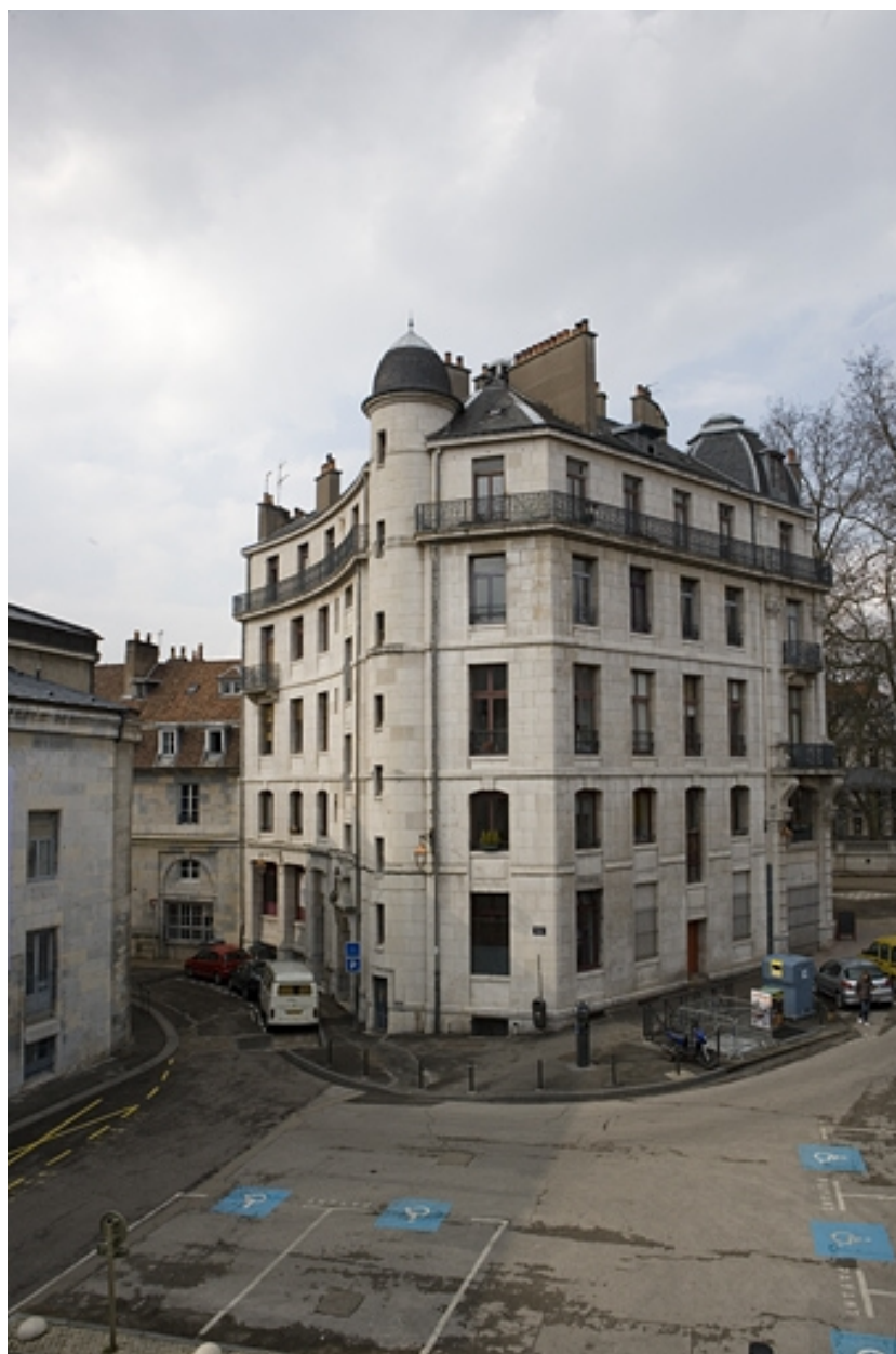
Vue d'ensemble de l'immeuble à l'angle de la place Granvelle et de la rue Lacoré.
