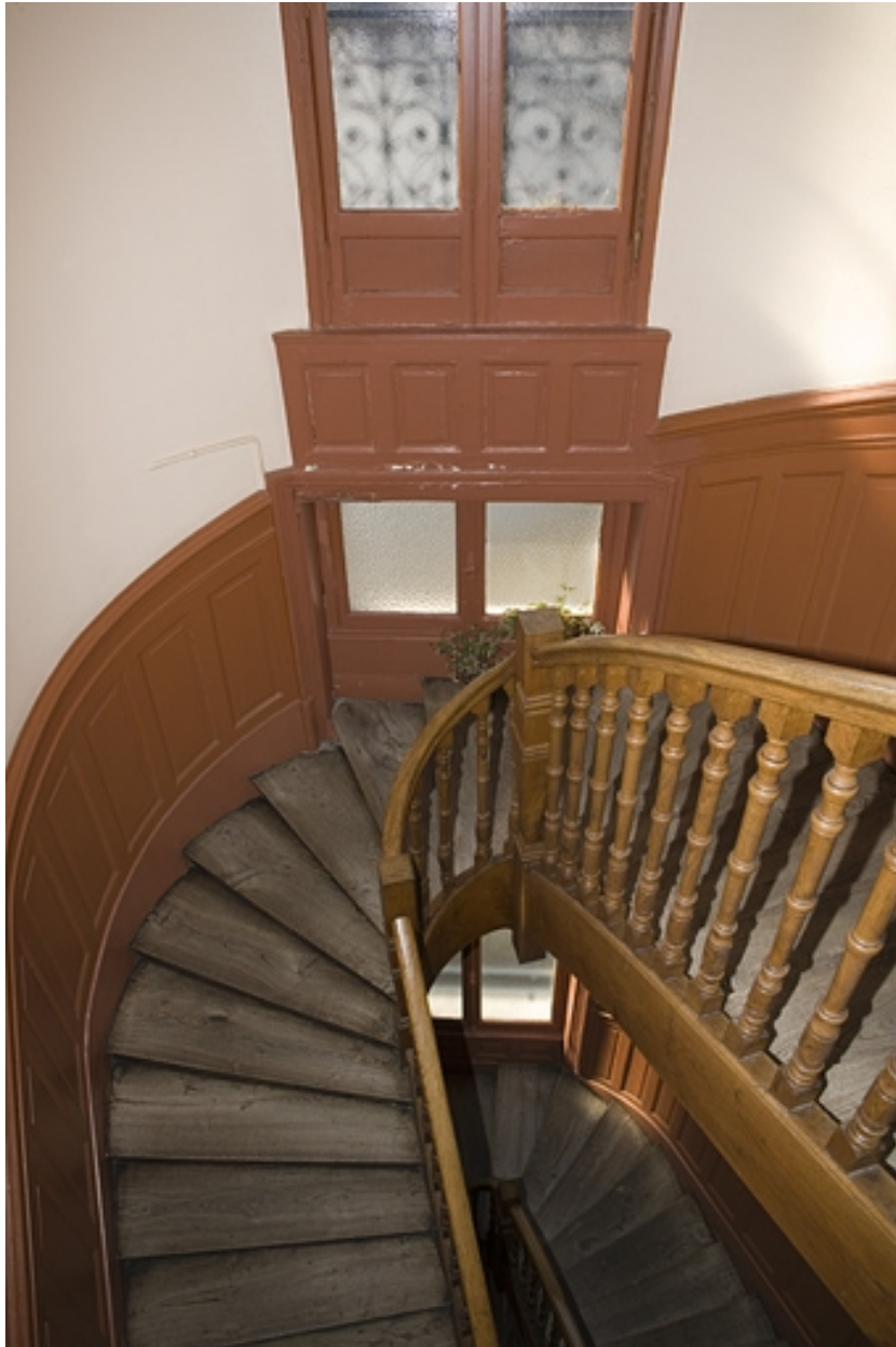
Détail d'une partie de l'escalier.
