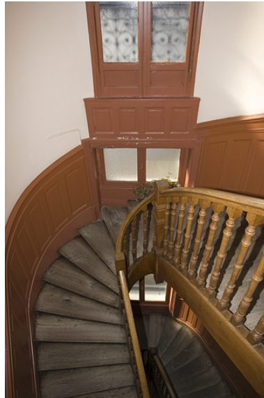
Détail d'une partie de l'escalier. Phot. Yves Sancey IVR43_20092500242NUC2A
