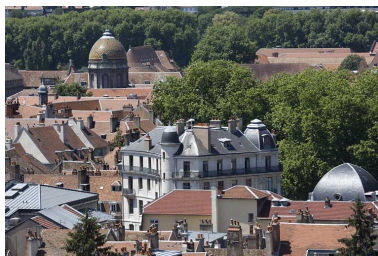
Vue d'ensemble éloignée. Phot. Yves Sancey IVR43_20092500969NUC2A
