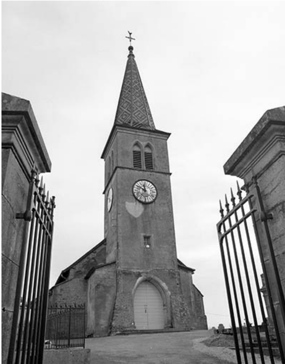
Extérieur : façade antérieure.
