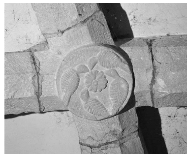
Intérieur : clé de voûte du chœur. Phot. Yves Sancey IVR43_19773900150X
