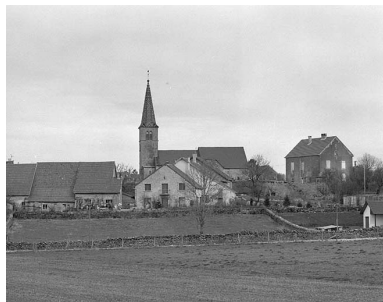
Vue de situation. Phot. Yves Sancey IVR43_19833900019X
