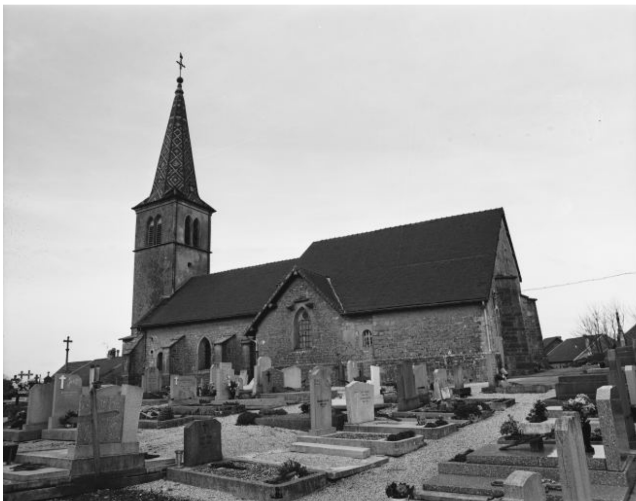
Façade latérale droite.
