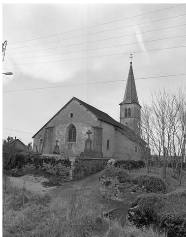
Extérieur : chevet. Phot. Yves Sancey IVR43_19833900026X
