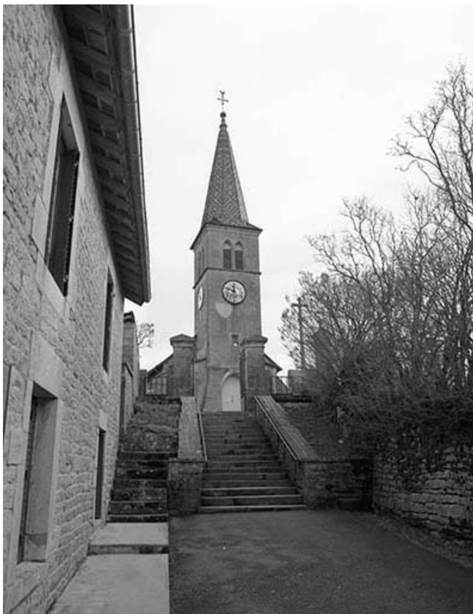
Extérieur : façade antérieure.
