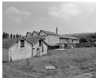
Remises et atelier de fabrication.
