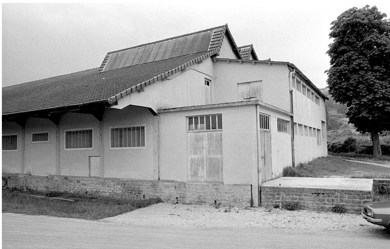
Extrémité ouest de l'atelier de fabrication.
