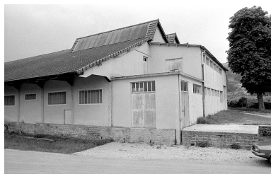
Extrémité ouest de l'atelier de fabrication.
