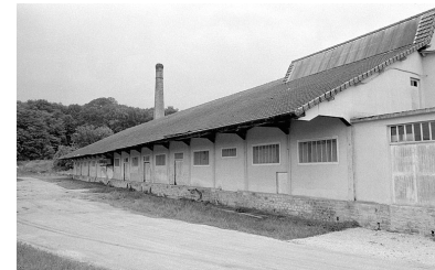
Magasin industriel depuis le nord-ouest en 1980. Phot. Jack Dumont IVR43_19803900324Z
