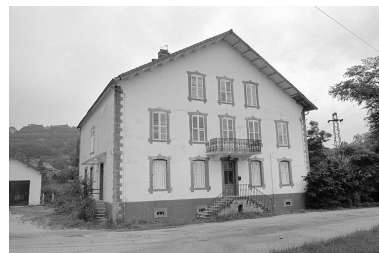
Façade antérieure du logement patronal et bureau.
