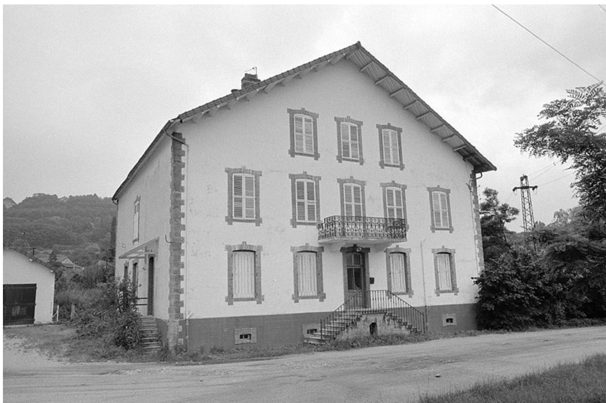
Façade antérieure du logement patronal et bureau.
