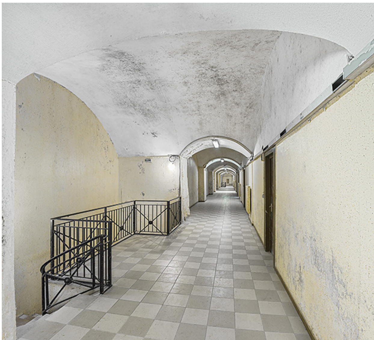
Couloir du premier étage de l'espace de casernement.
