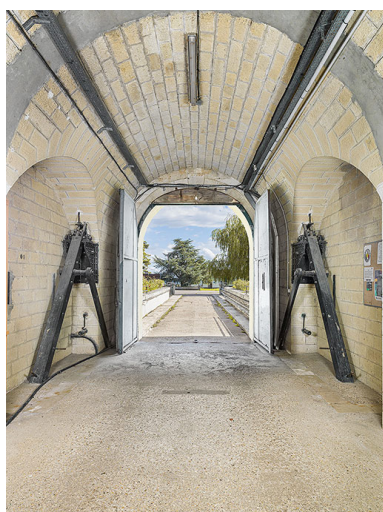
Sas d'entrée du fort. Phot. Thierry Kuntz IVR26_20252100224NUC4A
