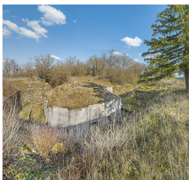
Vue de la caponnière depuis la contrescarpe. Phot. Thierry Kuntz IVR26_20262100313NUC4A
