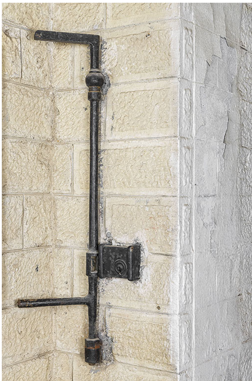
Taquet pivotant bloquant ou activant la bascule du pont.
