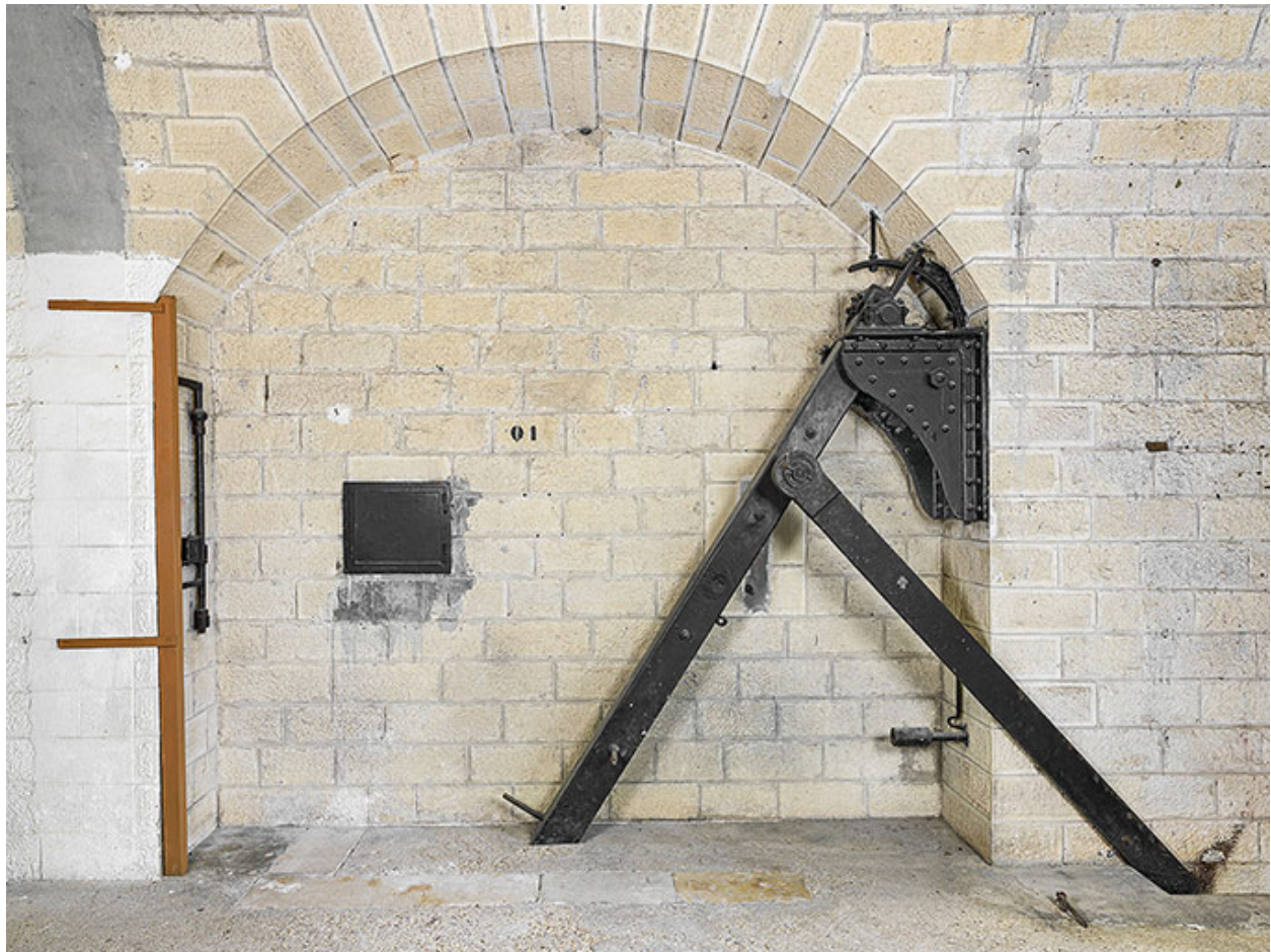
Mécanisme du pont-levis.
