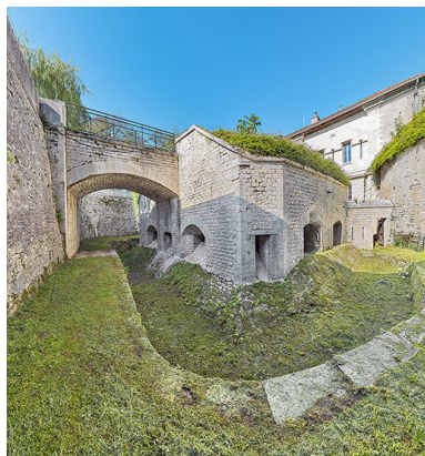
La double caponnière du front de gorge et son fossé diamant. Phot. Thierry Kuntz IVR26_20252100222NUC4A
