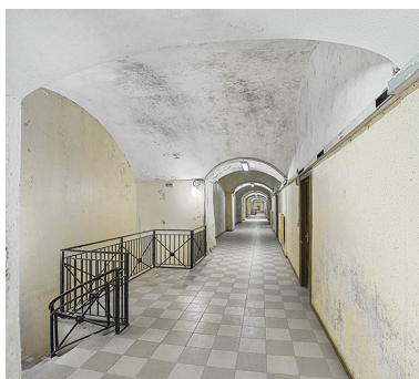
Couloir du premier étage de l'espace de casernement. Phot. Thierry Kuntz IVR26_20252100449NUC4A
