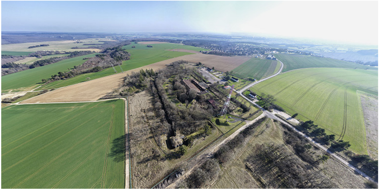
Vue d'ensemble. (vue aérienne).
