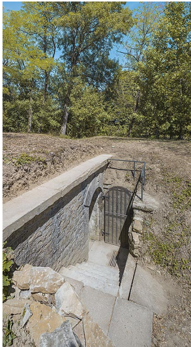
Porte d'accès à la caserne depuis les plateformes de tir du front de gorge. Phot. Thierry Kuntz IVR26_20252100483NUC4A
