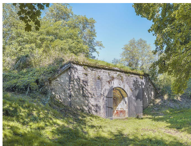
Traverse-abri dite la chapelle. Phot. Thierry Kuntz IVR26_20252100255NUC4A
