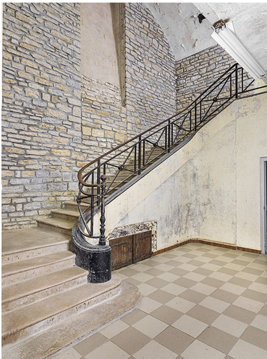
L'escalier vu depuis le rez-de-chaussée.
