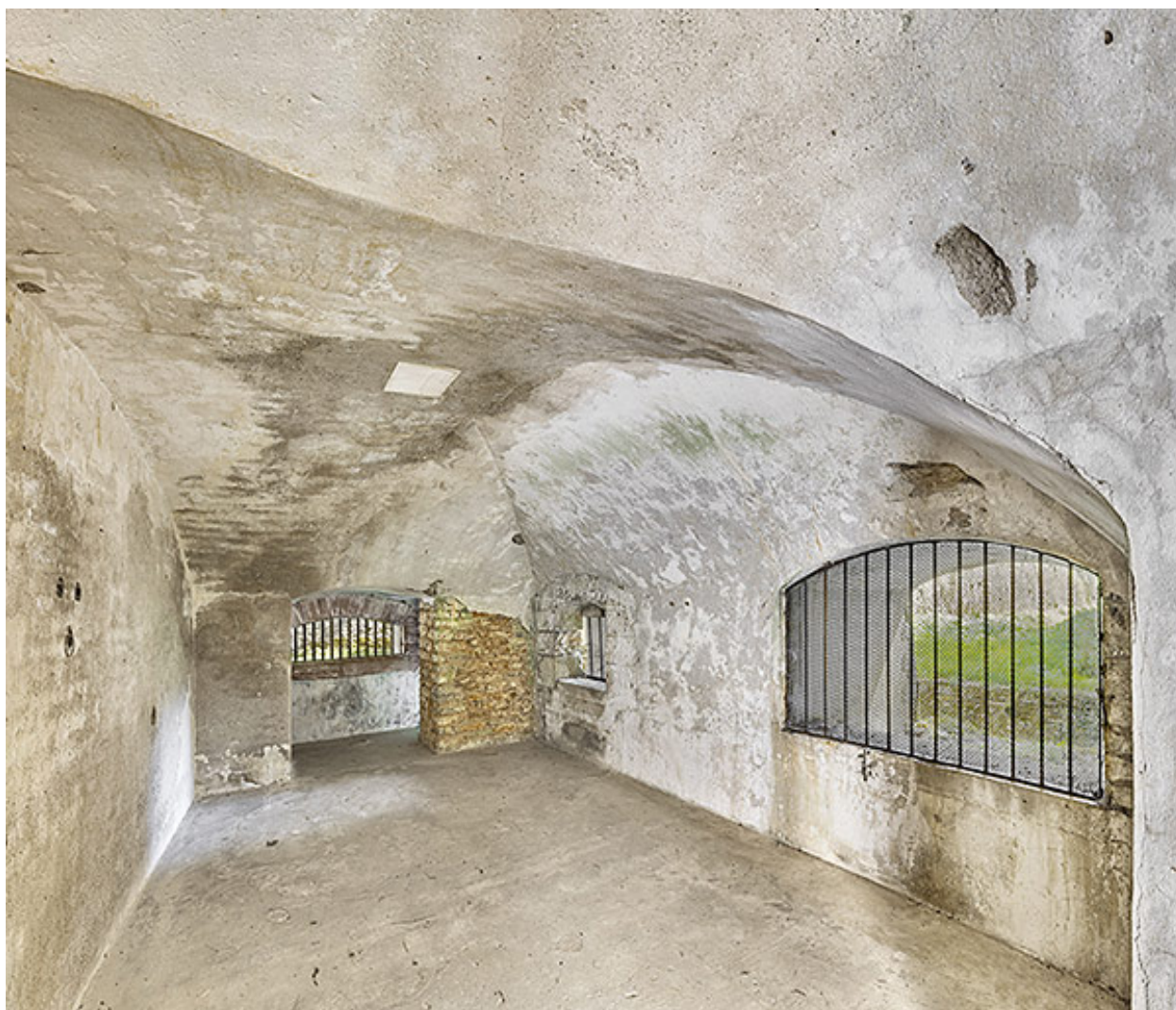
Vue intérieure de la double caponnière.
