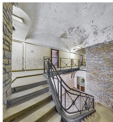
L'escalier entre le premier étage et le rez-de-chaussée. Phot. Thierry Kuntz IVR26_20252100450NUC4A
