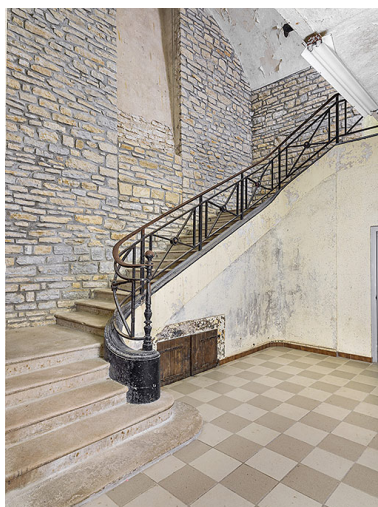
L'escalier vu depuis le rez-de-chaussée. Phot. Thierry Kuntz IVR26_20252100451NUC4A
