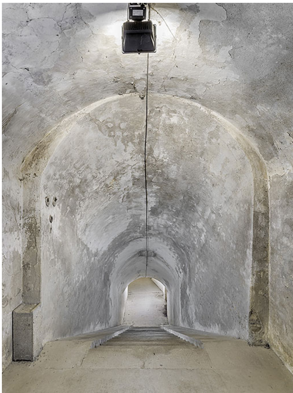
Escalier-rampe en direction de la double caponnière.
