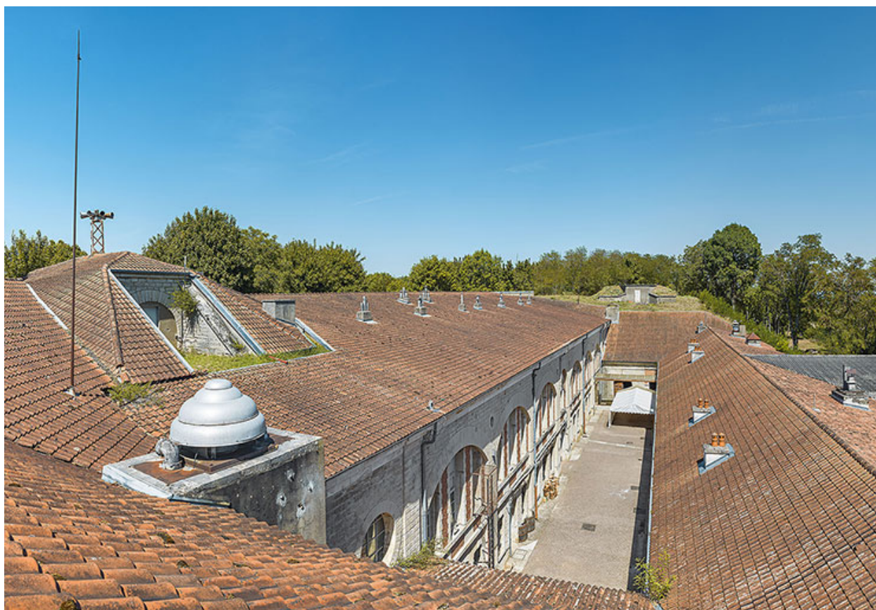
Vue depuis le sud-ouest de la cour et des casernes.
