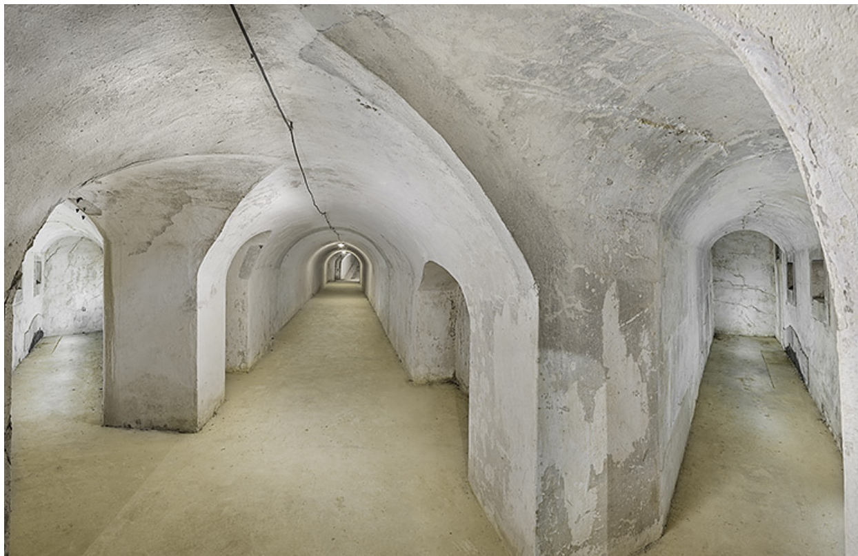
Postes de tir latéraux (aux flancs de la double caponnière).
