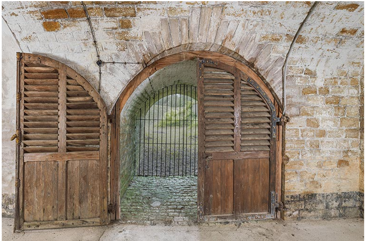
Porte d'accès vers la rue des Remparts, galerie latérale droite de la caserne.
