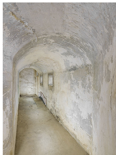
Détail intérieur d'un flanc. Phot. Thierry Kuntz IVR26_20252100501NUC4A
