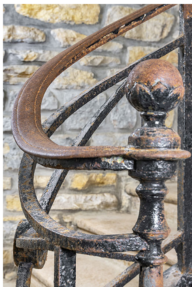
Détail du départ de la rampe et de la main courante. Phot. Thierry Kuntz IVR26_20252100457NUC4A
