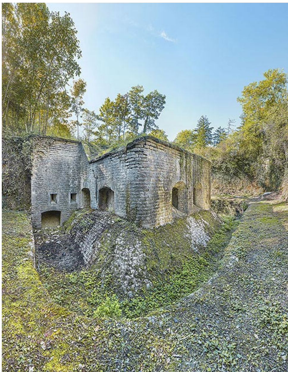
Vue de la double caponnière depuis le fossé.
