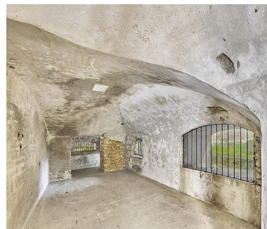
Vue intérieure de la double caponnière. Phot. Thierry Kuntz IVR26_20252100478NUC4A
