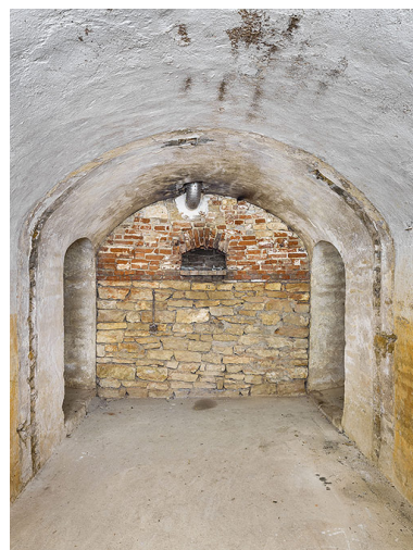
Galerie latérale droite de la caserne. Phot. Thierry Kuntz IVR26_20252100241NUC4A
