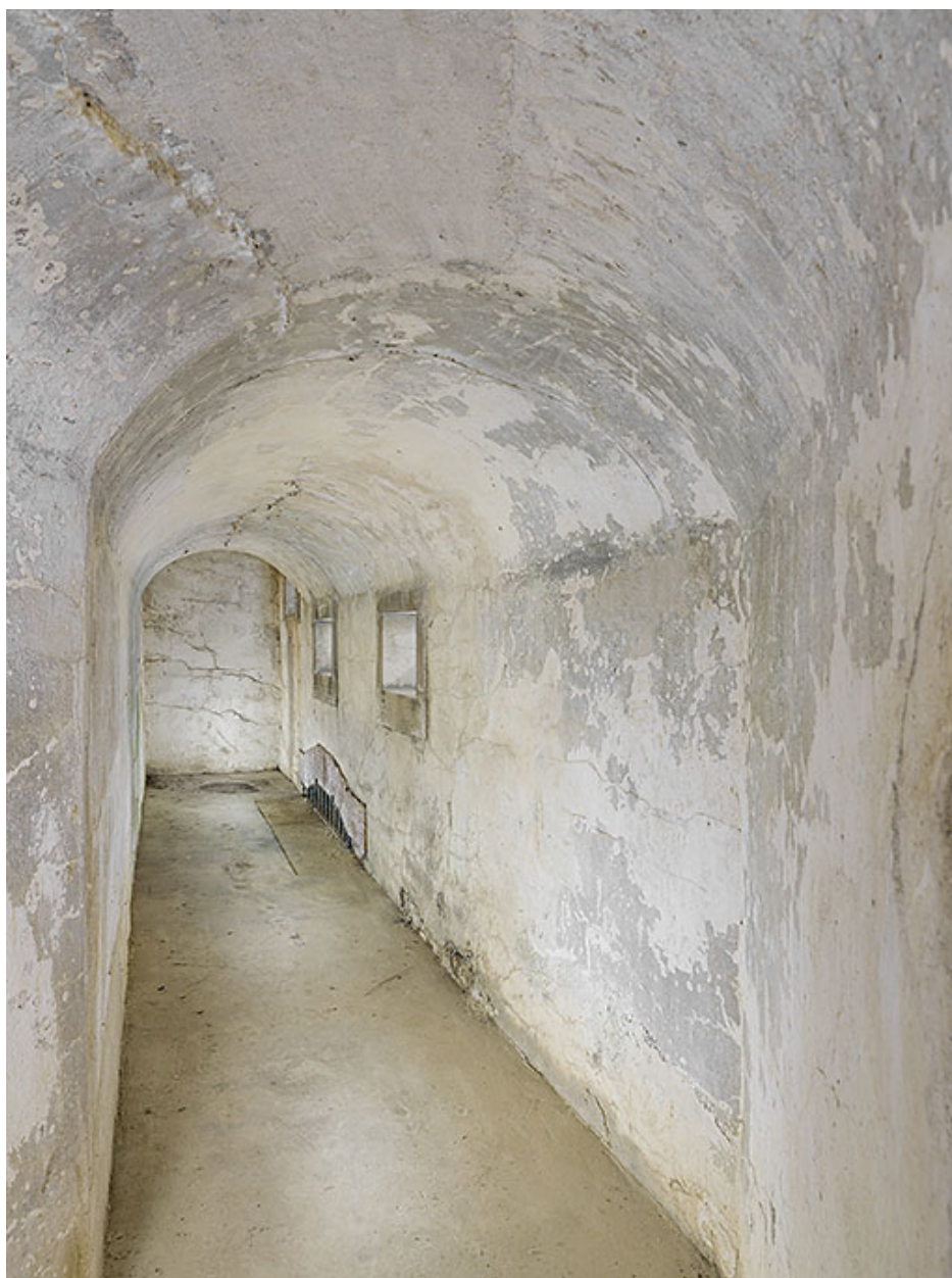
Détail intérieur d'un flanc.
