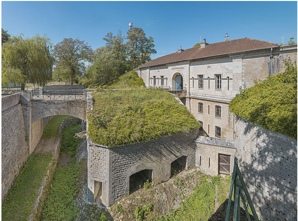
La double caponnière du front de gorge, vue depuis la contrescarpe.
