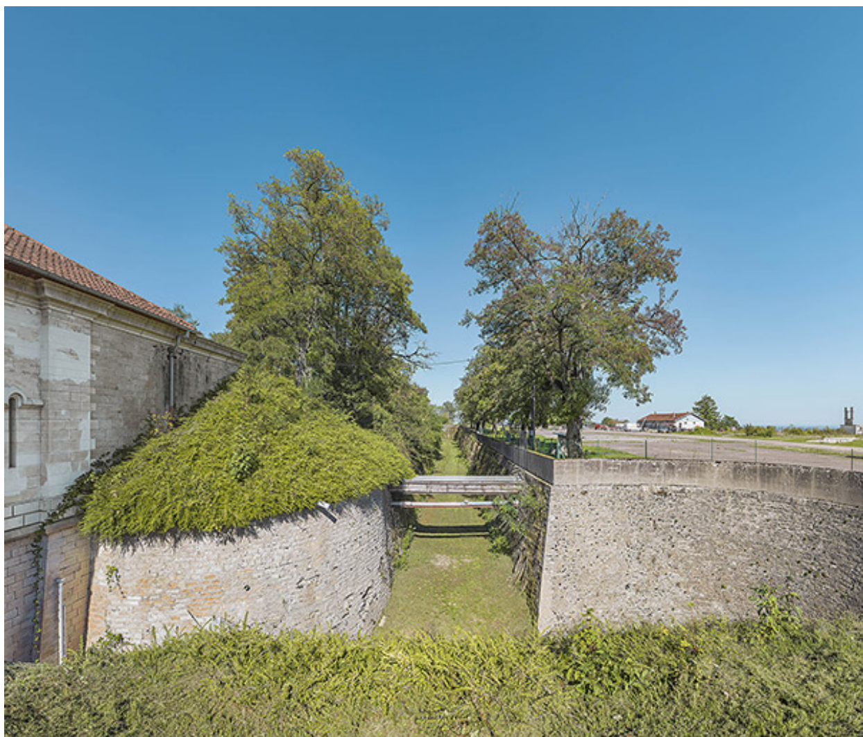
Fossé du front de gorge.
