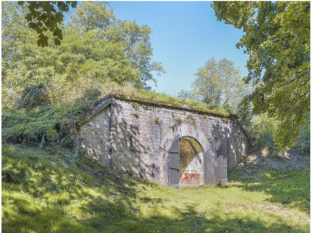
Traverse-abri dite la chapelle.
