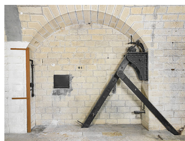
Mécanisme du pont-levis. Phot. Thierry Kuntz IVR26_20252100227NUC4A
