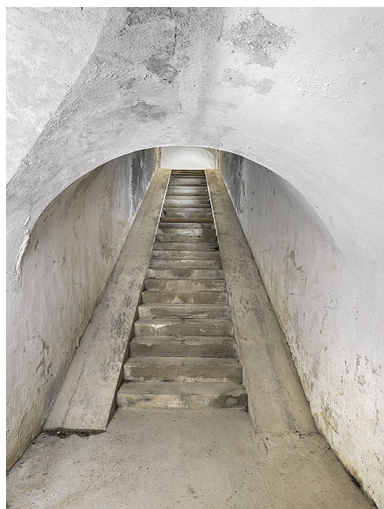
Escalier-rampe, vue montante.
