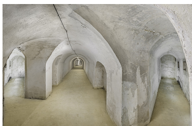
Postes de tir latéraux (aux flancs de la double caponnière). Phot. Thierry Kuntz IVR26_20252100499NUC4A
