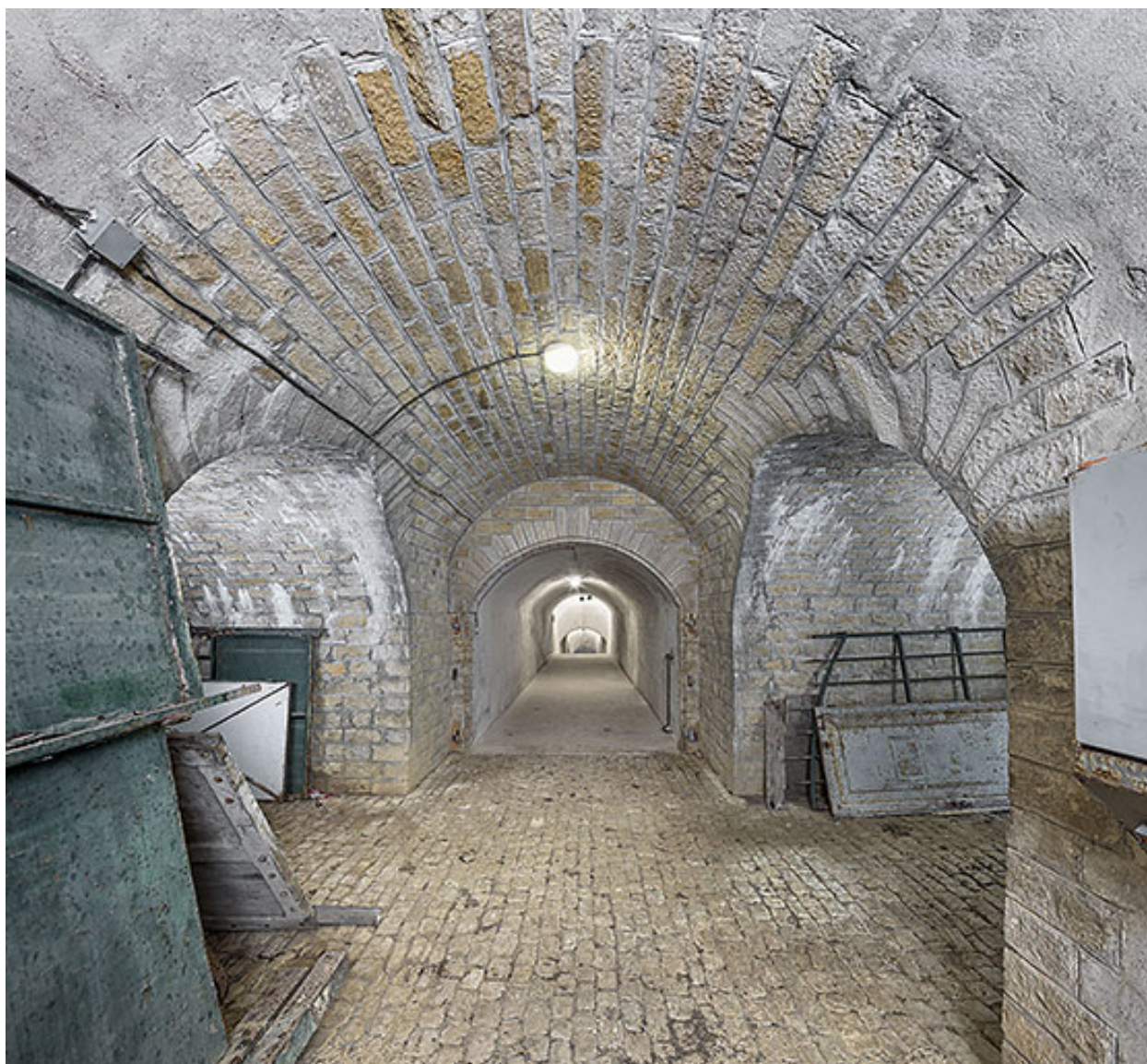
Gaine d'accès à la double caponnière et à la rue des Remparts.
