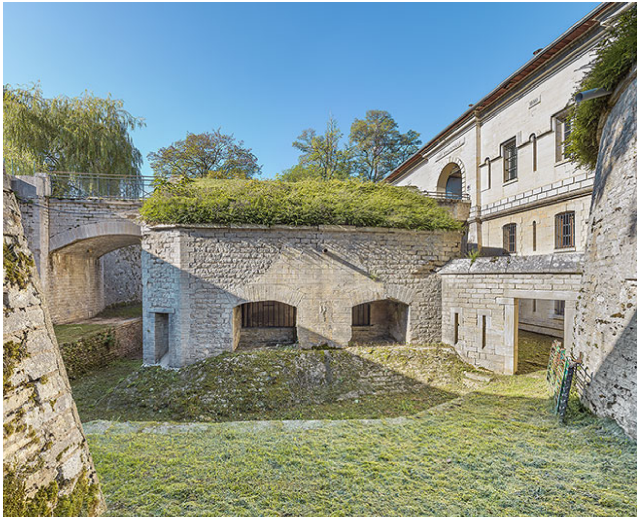
La double caponnière du front de gorge, vue depuis le fossé.
