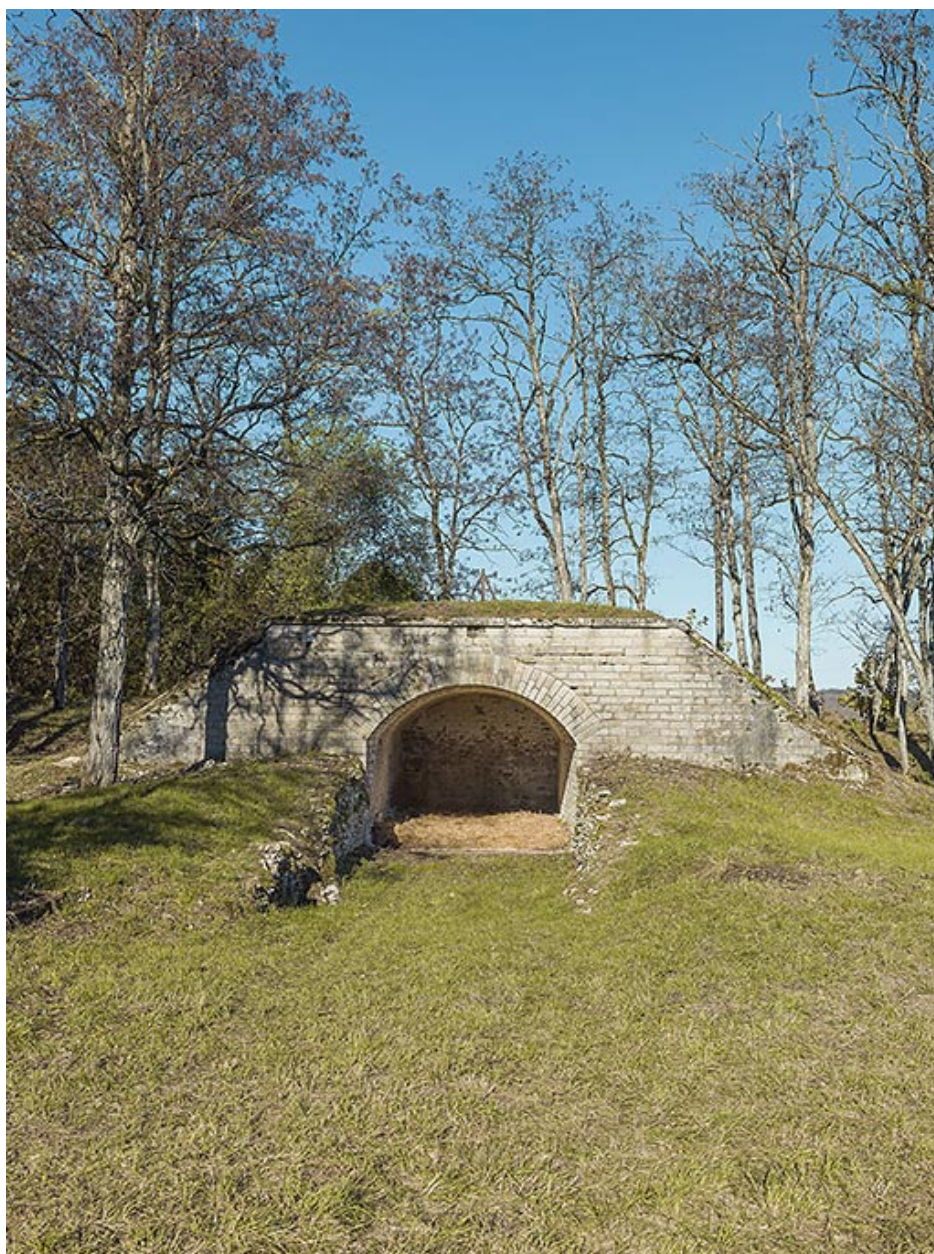
Traverse-abri de la batterie.
