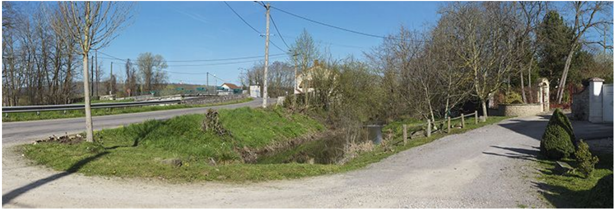
Rigole d'alimentation derrière la maison éclusière.
