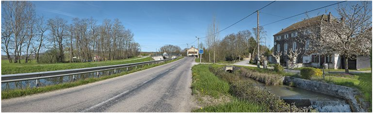
Rigole d'alimentation derrière la maison éclusière.
