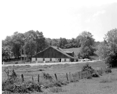
Vue générale. Phot. Bernard Lardière IVR43_19782500228X
