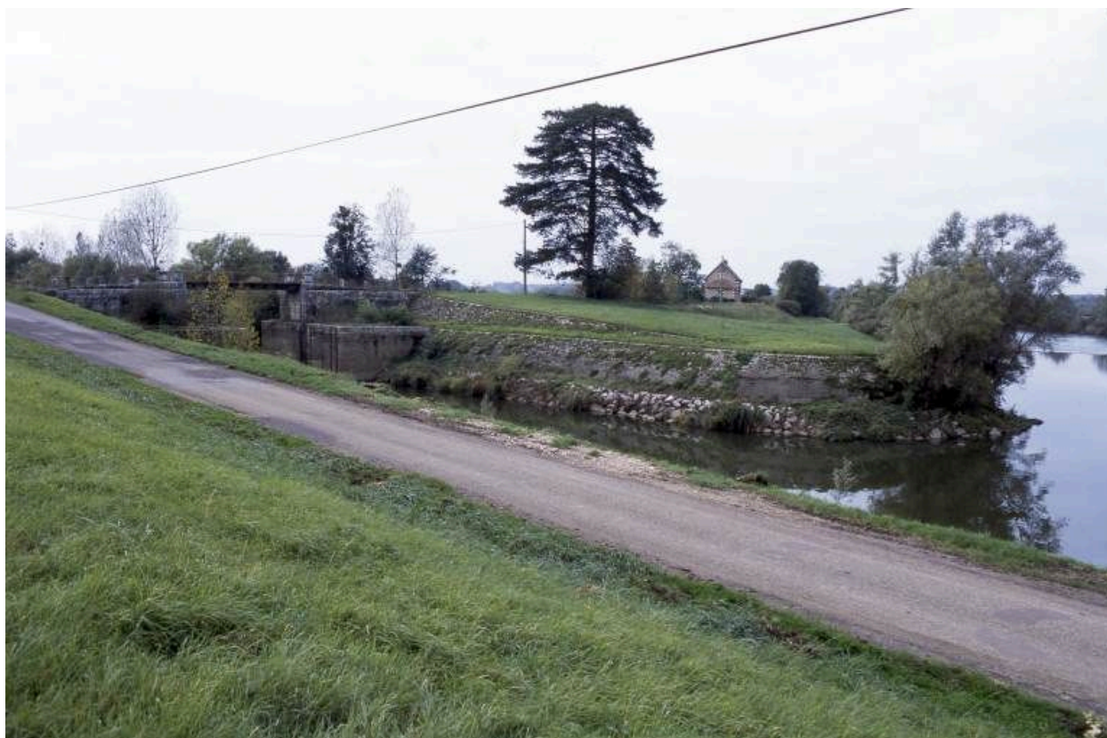
L'entrée est de l'écluse, à gauche du Pasquier du bief, en 2001.
