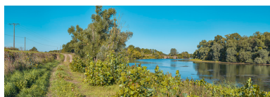
Vue d'ensemble du site du barrage en 2019. Phot. Thierry Kuntz IVR26_20197100477NUC4A
