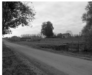
L'écluse en 2001. Phot. Michel Rosso IVR26_20017101280X
