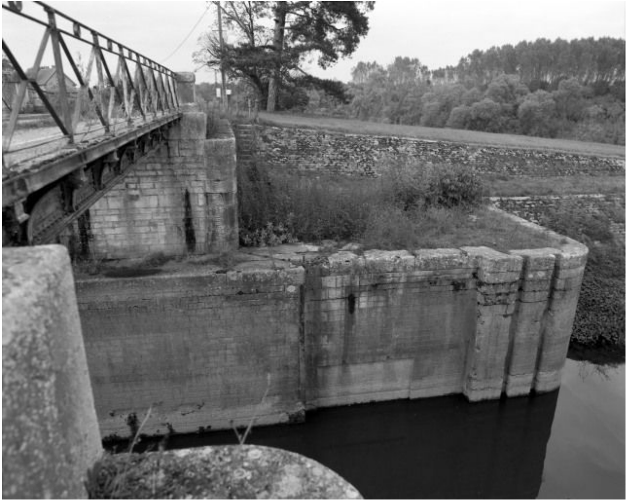
L'entrée est de l'écluse en 2001, détail.
