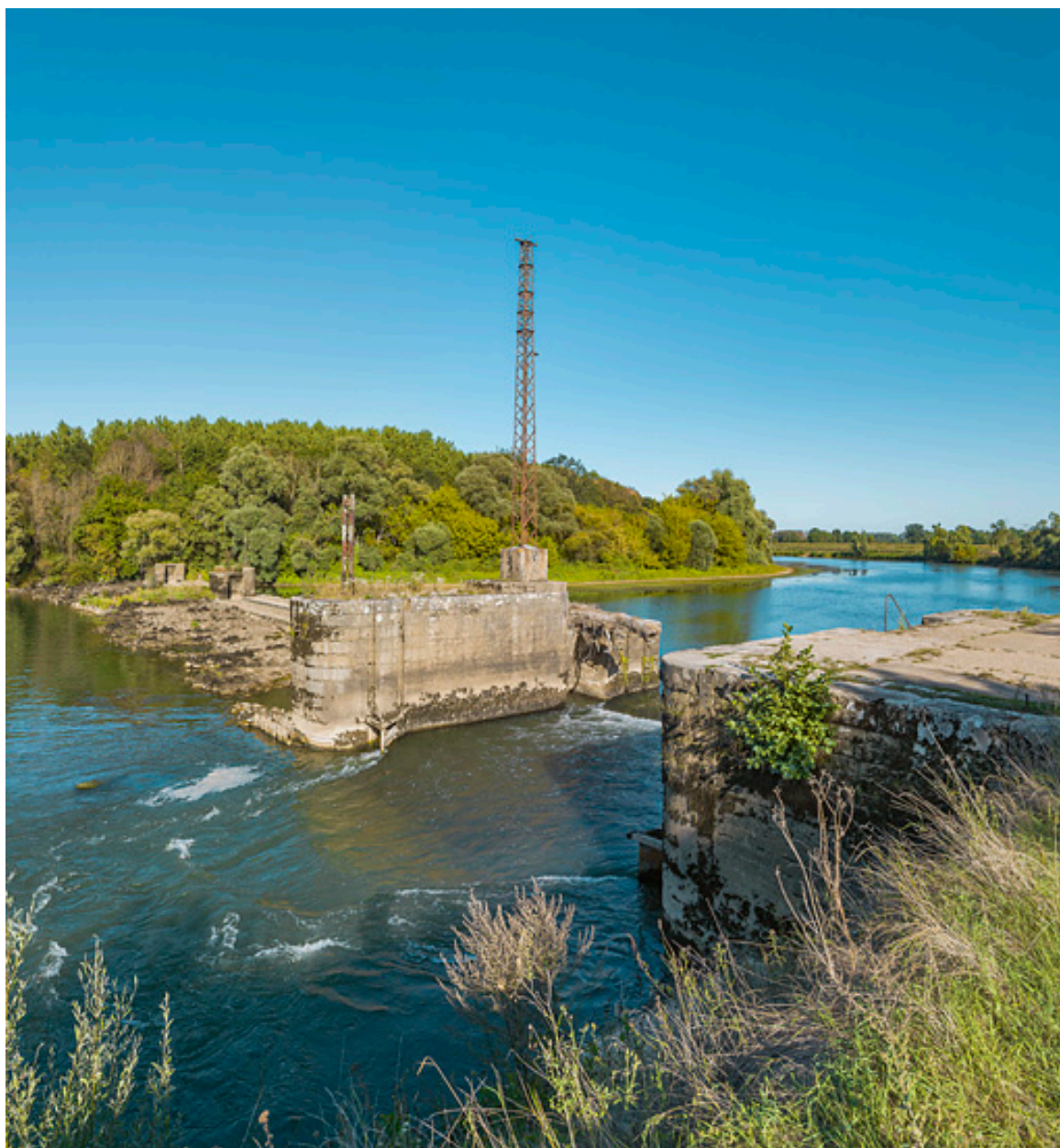
Vue d'ensemble du barrage en 2019 : au premier plan, l'ancien pertuis.
