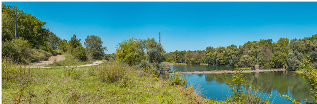
Vue d'ensemble du barrage en 2019. A gauche, se trouvait la maison du barragiste.
