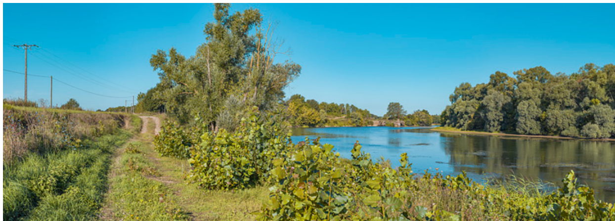
Vue d'ensemble du site du barrage en 2019.
